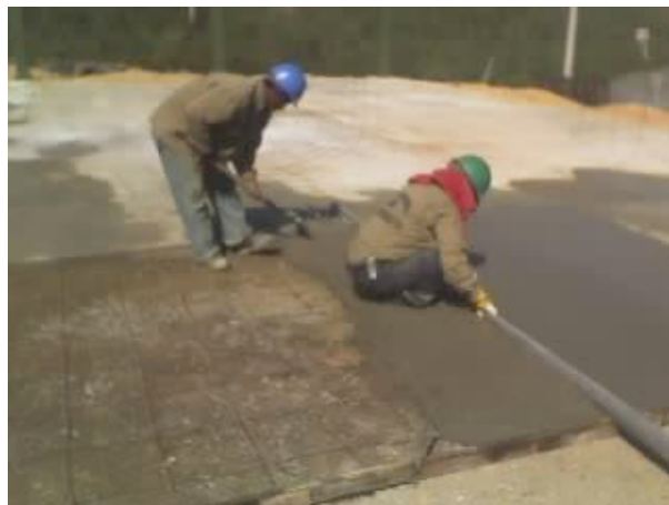
Figura 42. Construcción de piso en concreto
