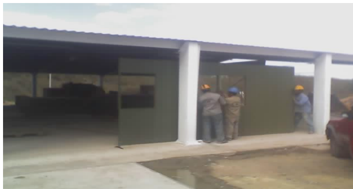
Figura 45. Instalación de módulos perimetrales
