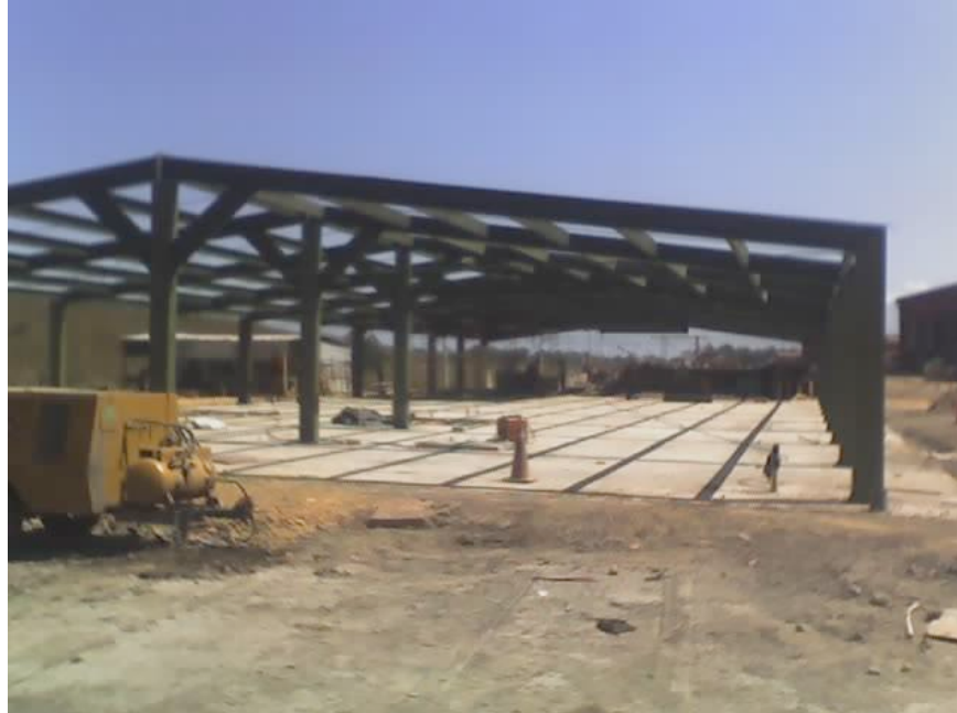
Figura 44. Sistema estructural terminado
