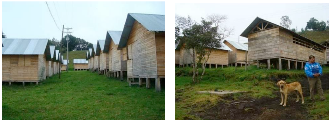
Figura 39. Albergue temporal construido en madera, Pasto, Colombia
