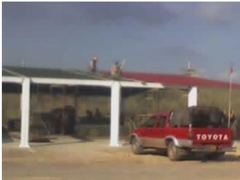
Figura 48. Instalación de cubierta con teja termo-acústica
