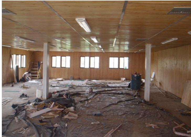
Figura 47. Cielo raso con machimbre
