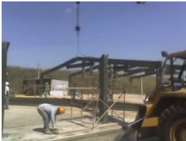
Figura 43. Conexión viga columna (montaje con grúa)
