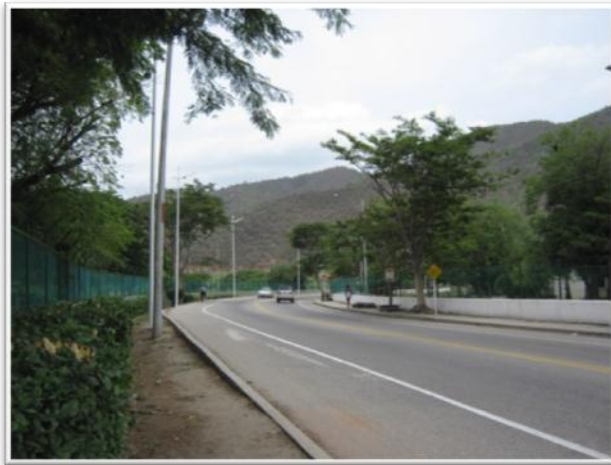
Figura 6. Vía principal del acceso
