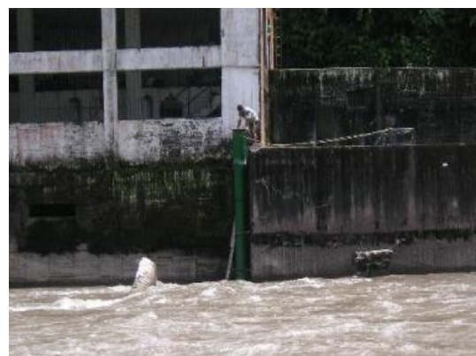
Figura 7-2. Limnógrafo Estación Puente Abadía, ubicada sobre el río Guatiquía. Fuente EAAB.
