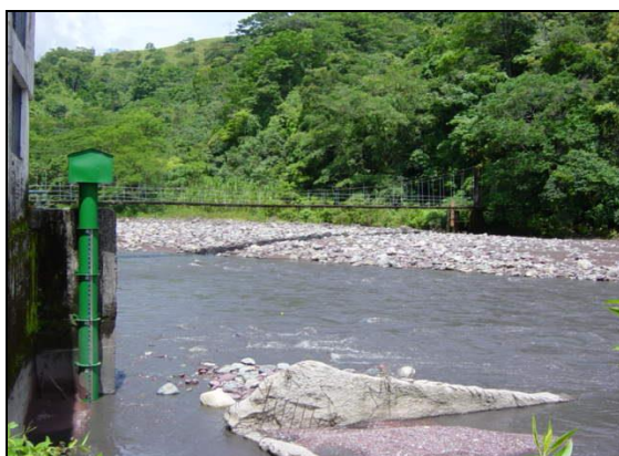
Figura 7-1. Estación limnigráfica Puente Abadía. Fuente EAAB.
