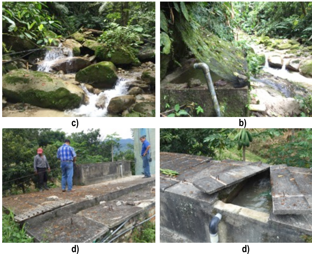
Imagen 9. Acueducto veredal Helechales bajo. A) Fuente de captación. B) Desarenador. C) Tanque de almacenamiento. D) Planta de tratamiento. Fuente propia.
