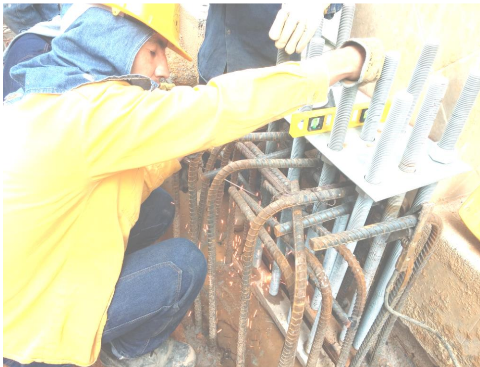
Imagen 32 Instalación de varillas pedestales.
