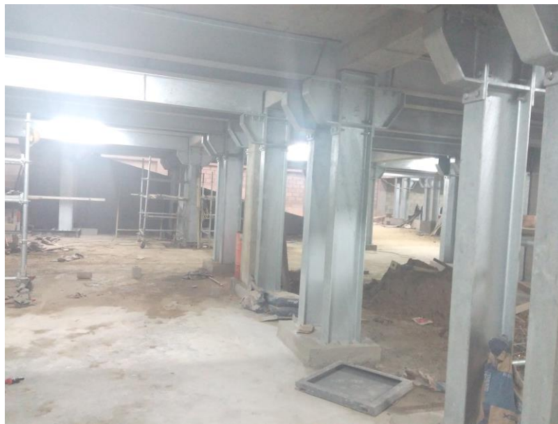
Imagen 2 Refuerzo estructural distribuidora Dissanmotos1.
