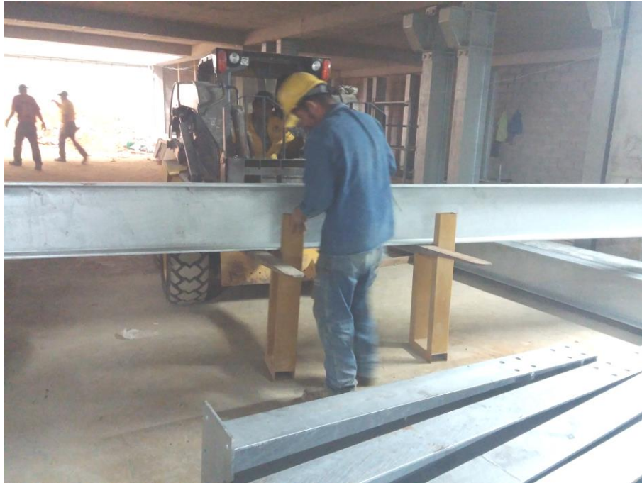
Imagen 11 Montaje de vigas metálicas 1.
