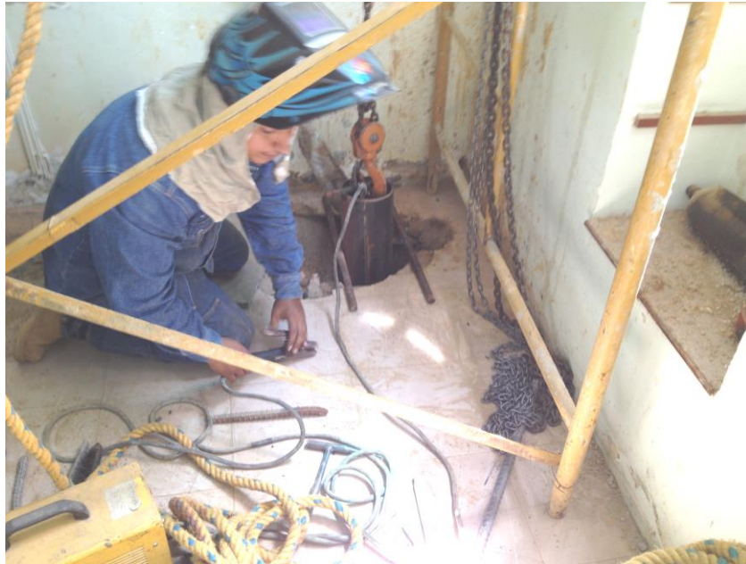
Imagen 21 Instalación de tubería en tramos de 2m.
