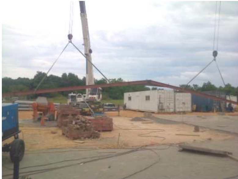
Imagen 41 Izaje de cerchas en el proyecto Bodega Discon Ltda.
