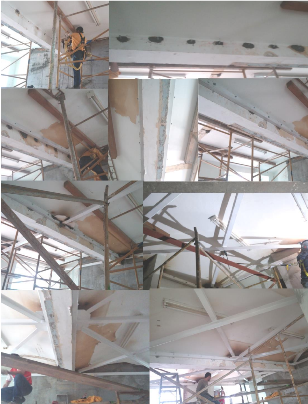
Imagen 28 Procedimiento del montaje mejoramiento diafragma.
