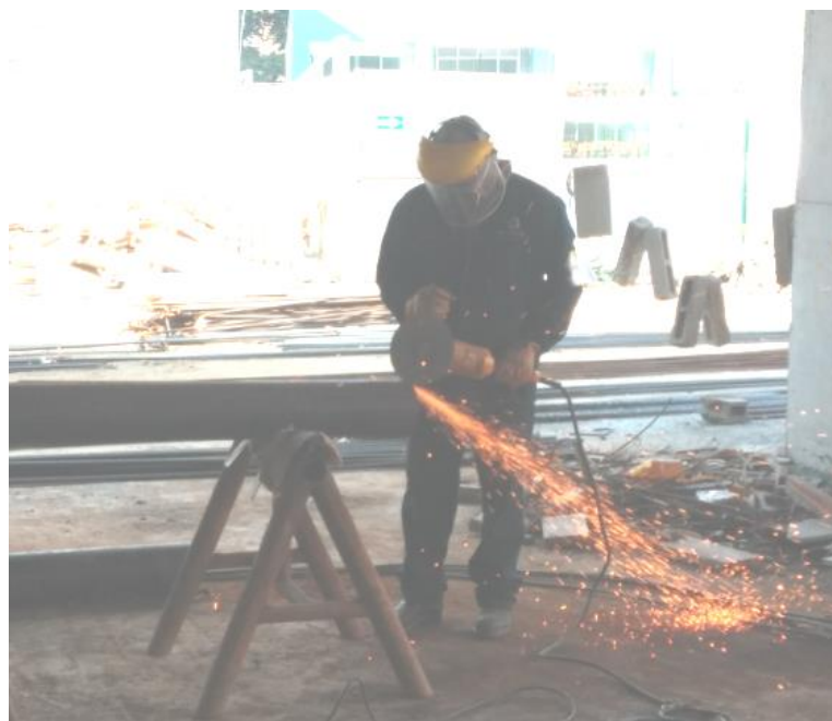
Imagen 19 Corte en forma de lápiz de tubería metálica.
