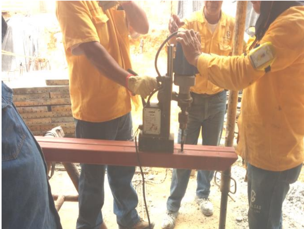
Imagen 27 Perforación de tubos cuadrados metálicos.
