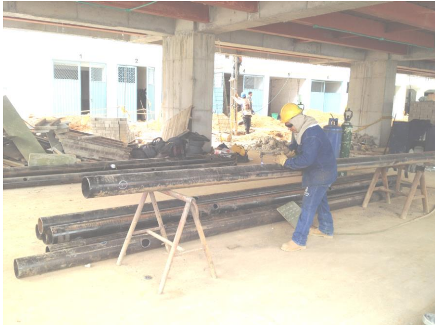
Imagen 16 Perforación de tubería metálica de 6" con oxicorte.
