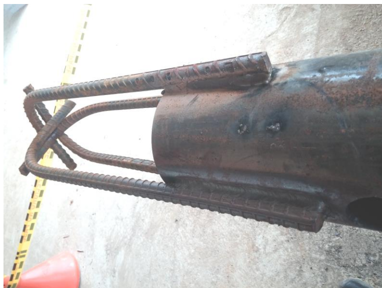
Imagen 18 Varillas de 7/8" Instaladas a un extremo del tubo metálico.
