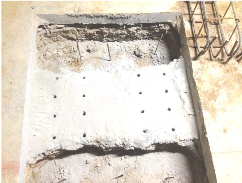
Imagen 6 Perforaciones a viga de cimentación con broca de \frac{3}{4} " Dissanmotos.
