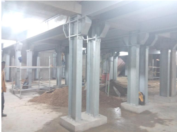
Imagen 3 Refuerzo estructural distribuidora Dissanmotos2.
