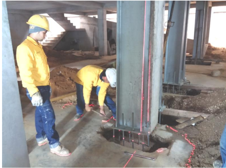
Imagen 10 Verificación de niveles de las columnas metálicas 2.
