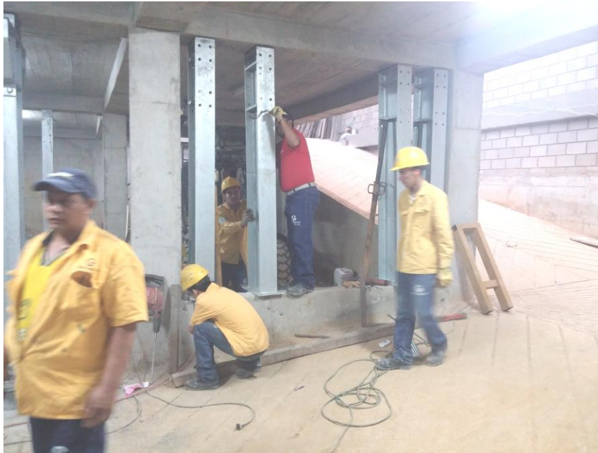
Imagen 8 Montaje Columnas metálicas 2.
