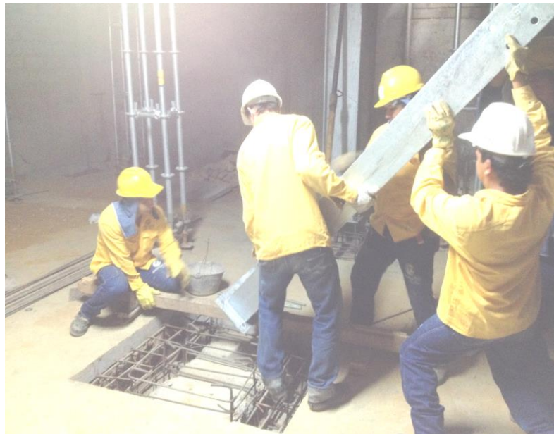
Imagen 7 Montaje de columna metálica 1.
