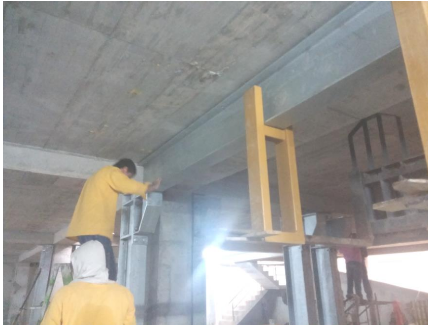
Imagen 13 Montaje de viga metálica 3.
