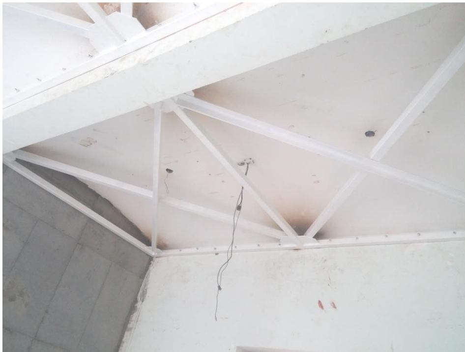
Imagen 15 Mejoramiento Diafragma (Refuerzo Placas de entrepiso).
