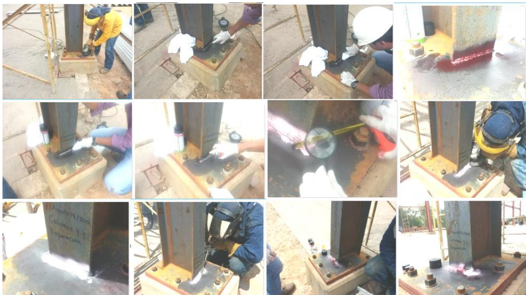
Imagen 49 Procedimiento de aplicación del ensayo de tintas penetrantes.
