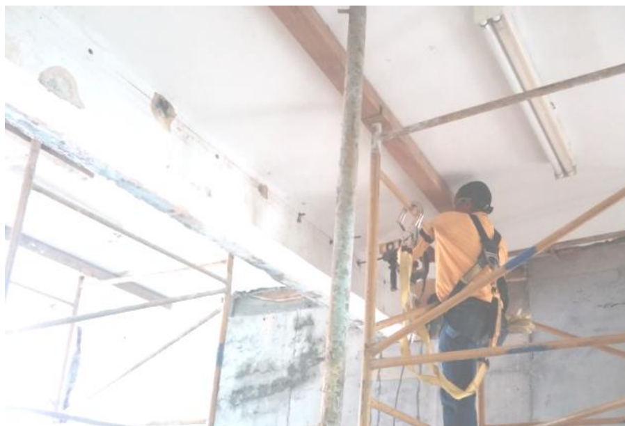
Imagen 26 Anclajes a viga existente.
