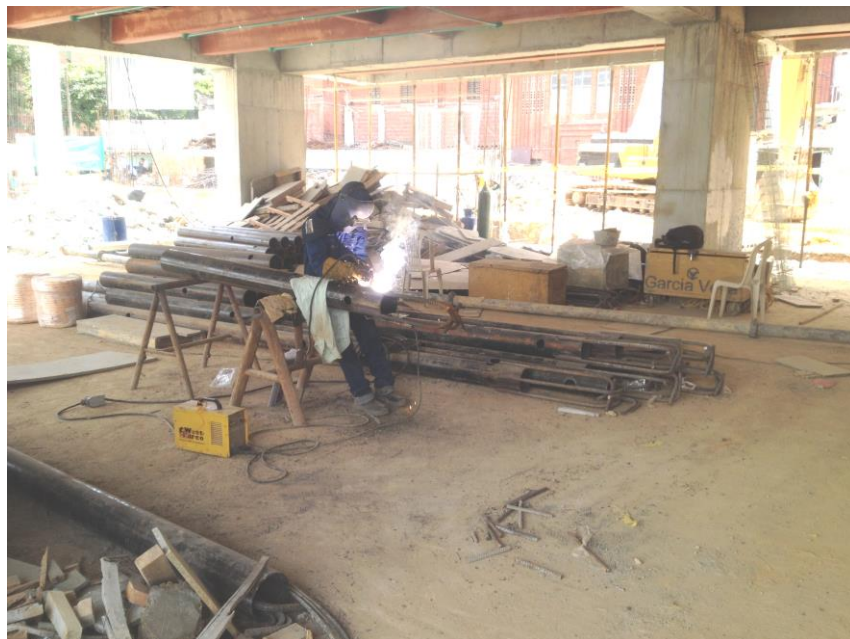
Imagen 17 Instalación de bastones por proceso SMAW, son 4 varillas de 7/8".
