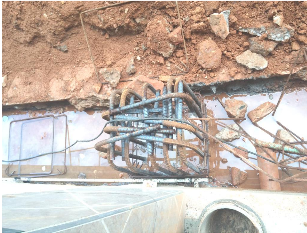
Imagen 31 Acero de refuerzo del pedestal.
