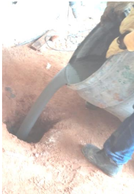
Imagen 24 Mezcla de agua cemento.
