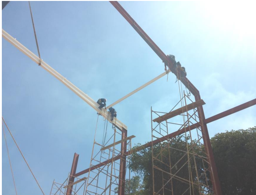
Imagen 43 Instalación de correas en la obra Bodega Discon Ltda.
