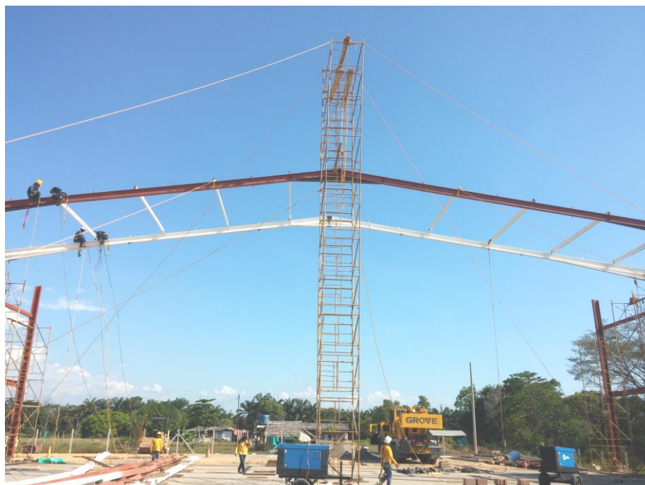
Imagen 44 Instalación de correas en la obra Bodega Discon Ltda.
