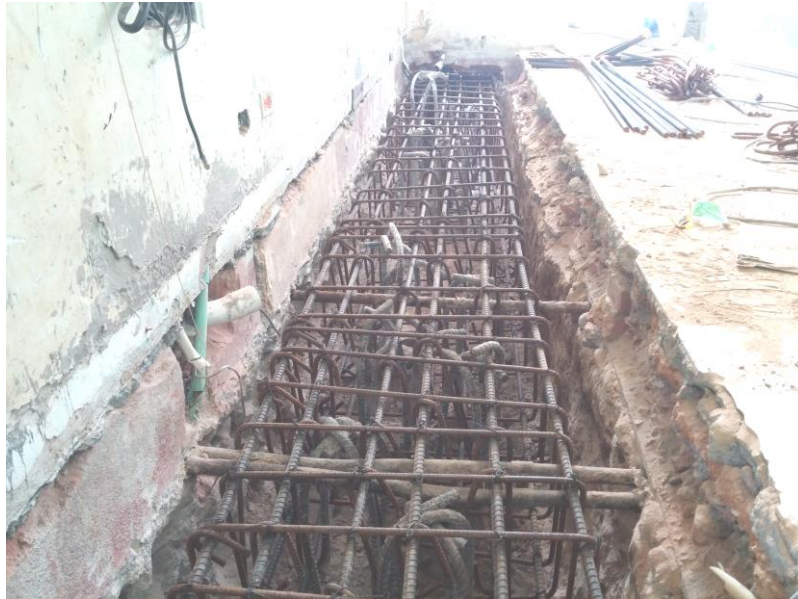
Imagen 25 Bastones en el interior de la estructura de la viga de cimentación.
