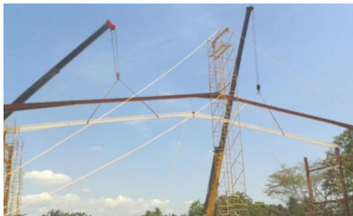
Imagen 42 I Izaje de cerchas en el proyecto Bodega Discon Ltda 2.
