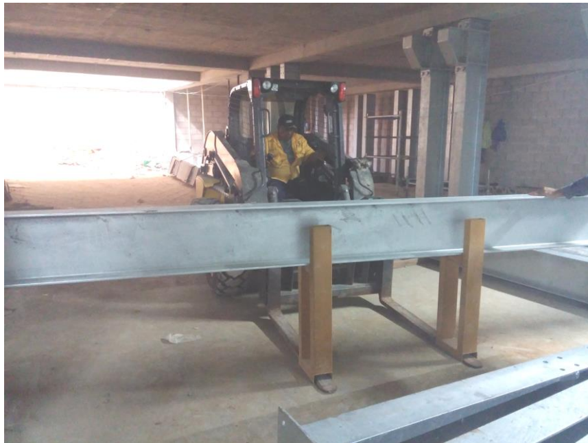
Imagen 12 Montaje de viga metálica 2.
