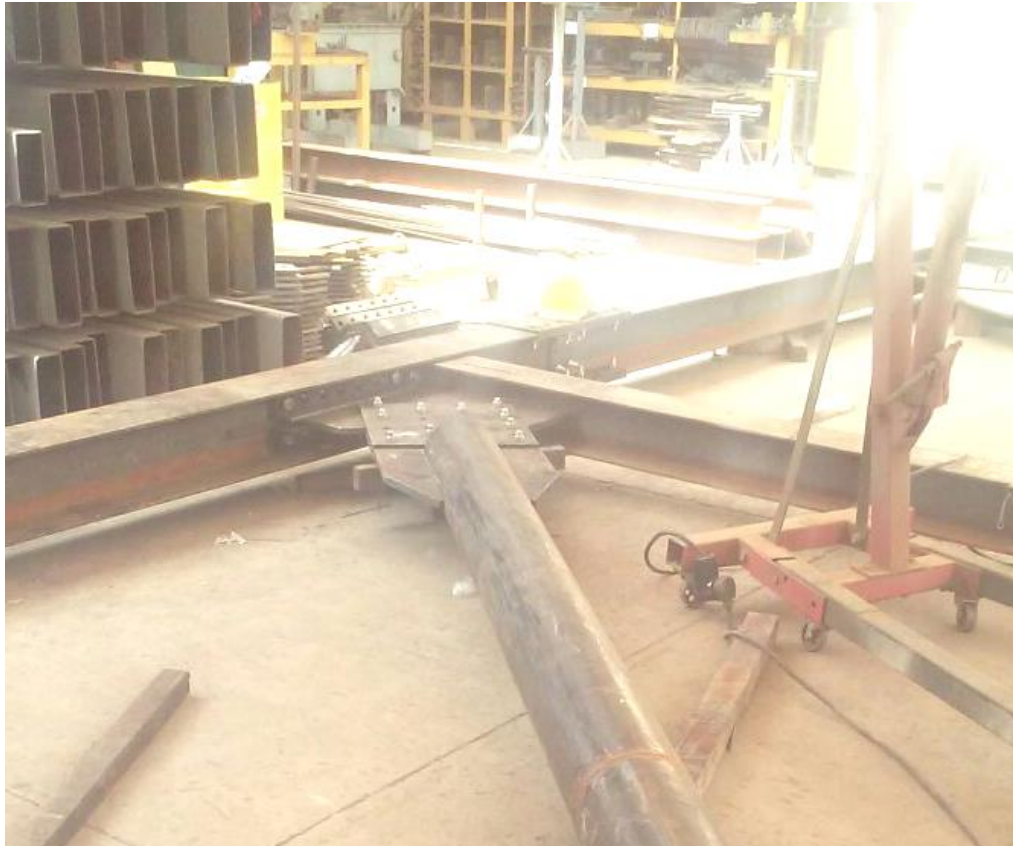
Imagen 14 Fabricación Pórticos para refuerzo Estructural Col. San Pedro.
