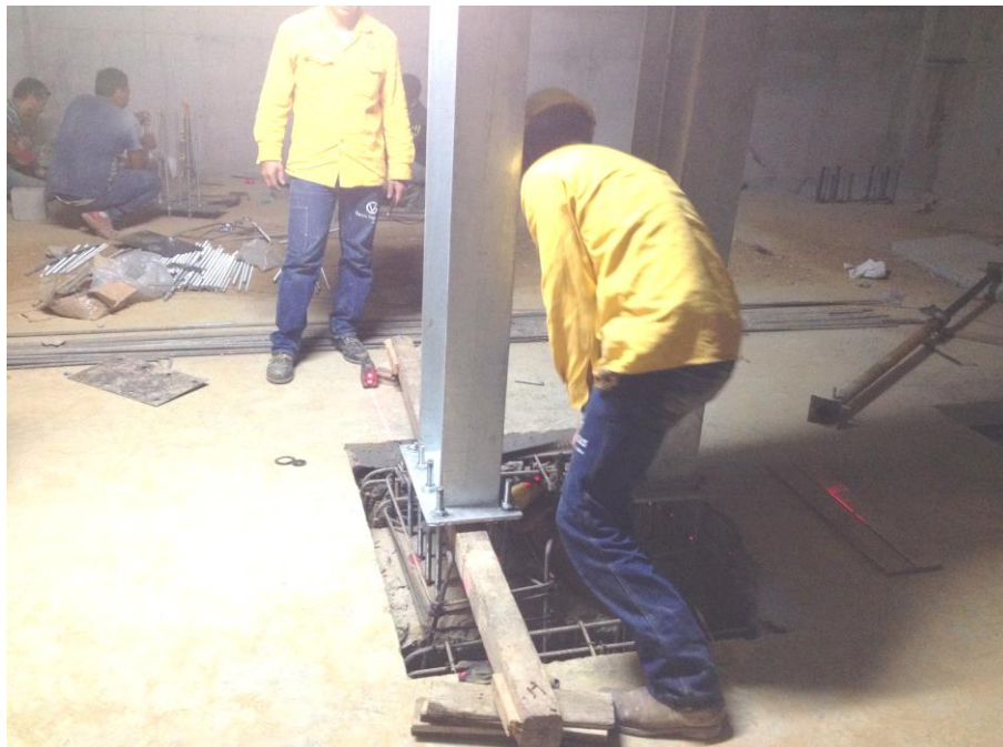
Imagen 9 Verificación de niveles de las columnas metálicas.
