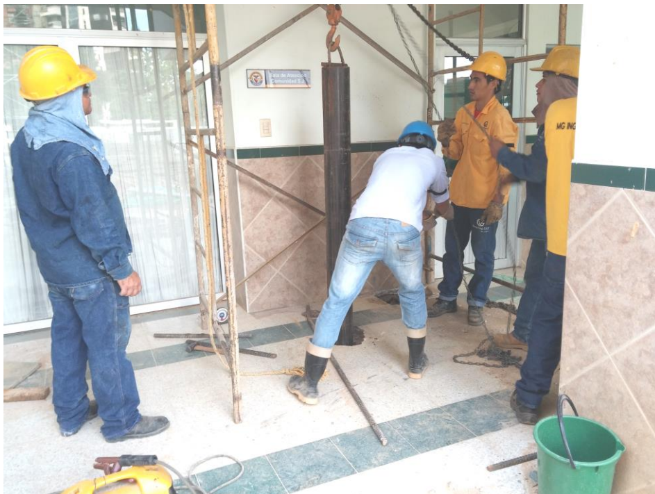
Imagen 22 Instalación de tubería en tramos de 2 metros.
