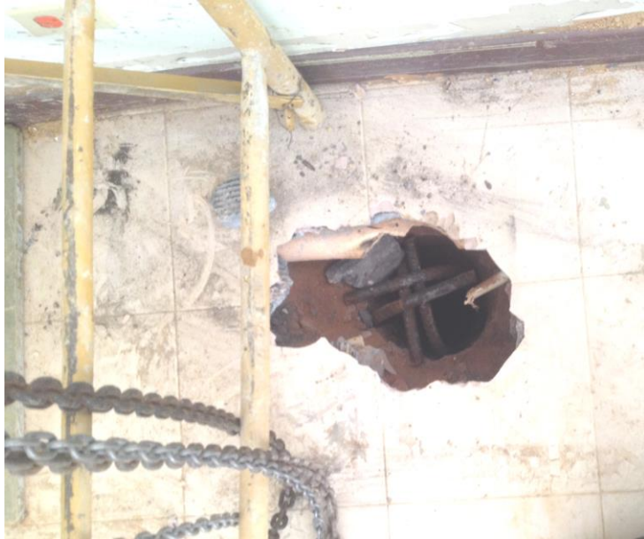
Imagen 23 Tubo metálico de 6" hincado.
