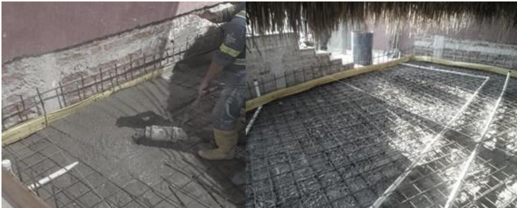
Ilustración 11. Fundición de concreto
