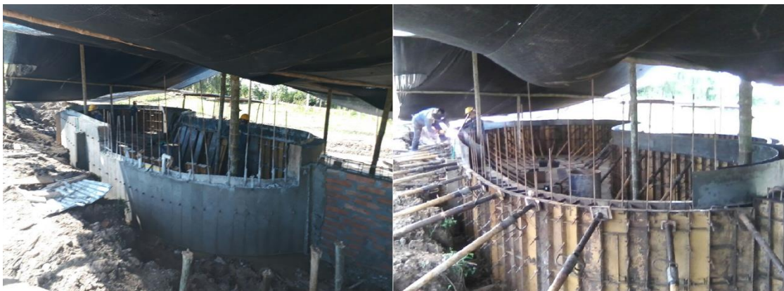
Ilustración 17. Fundición de concreto Fuente: Archivo fotográfico Imsaguas
