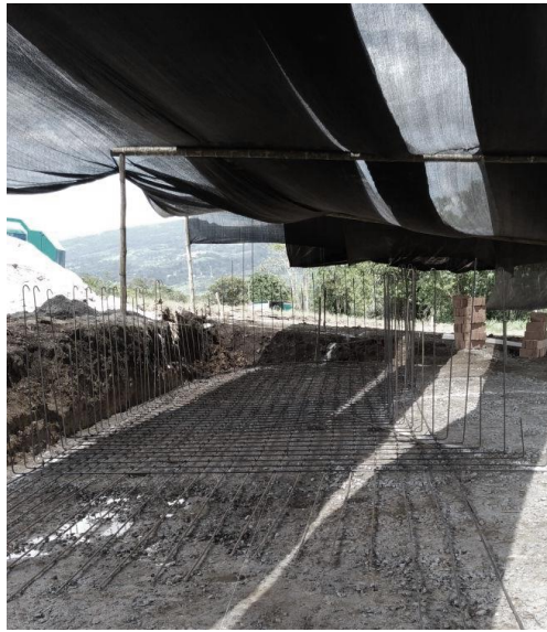
Ilustración 16. Armado de acero de refuerzo Fuente: Archivo fotográfico Imsaguas
