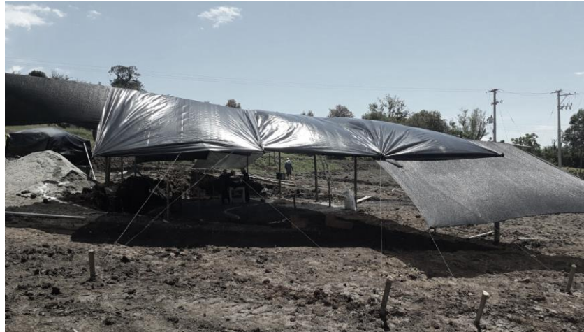
Ilustración 15. Desmonte y montaje de campamento Fuente: Archivo fotográfico Imsaguas
