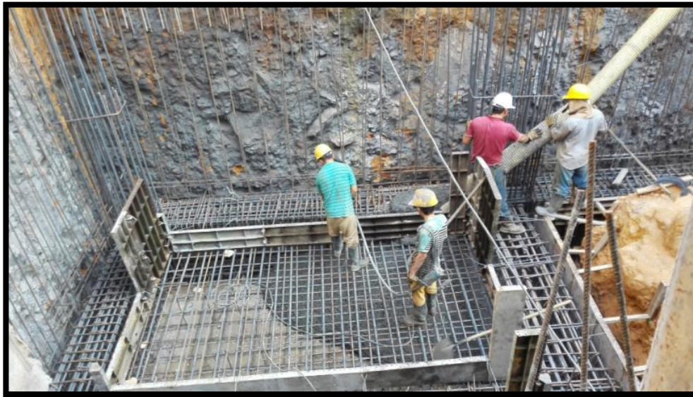
Figura 1. Fundida de losa y vigas de cimentación
