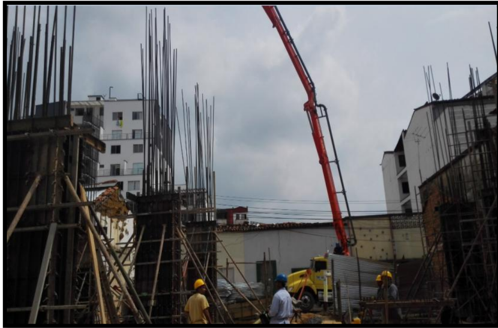
Figura 3. Fundida columnas con autobomba
