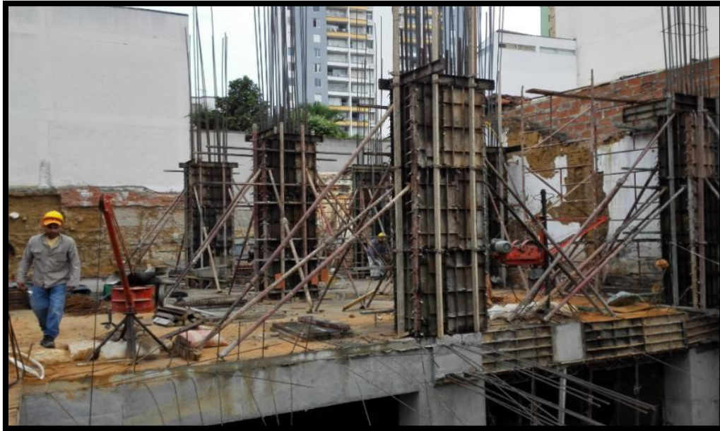
Figura 2. Encofrado de columnas
