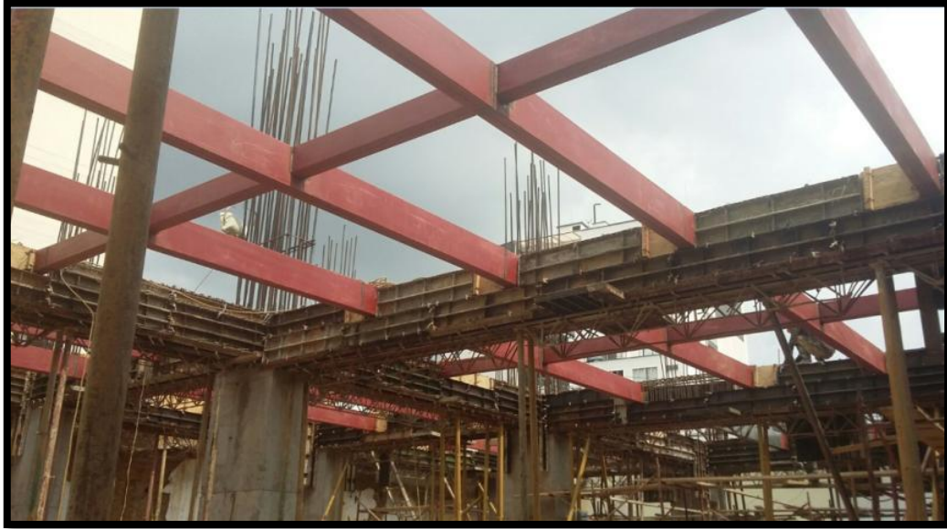
Figura 6. Instalación de viguetas de apoyo (Perlines)
