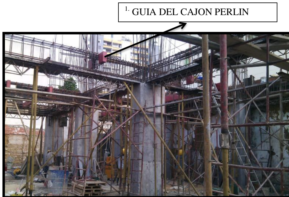
Figura 5. Instalación del cajón perlin
