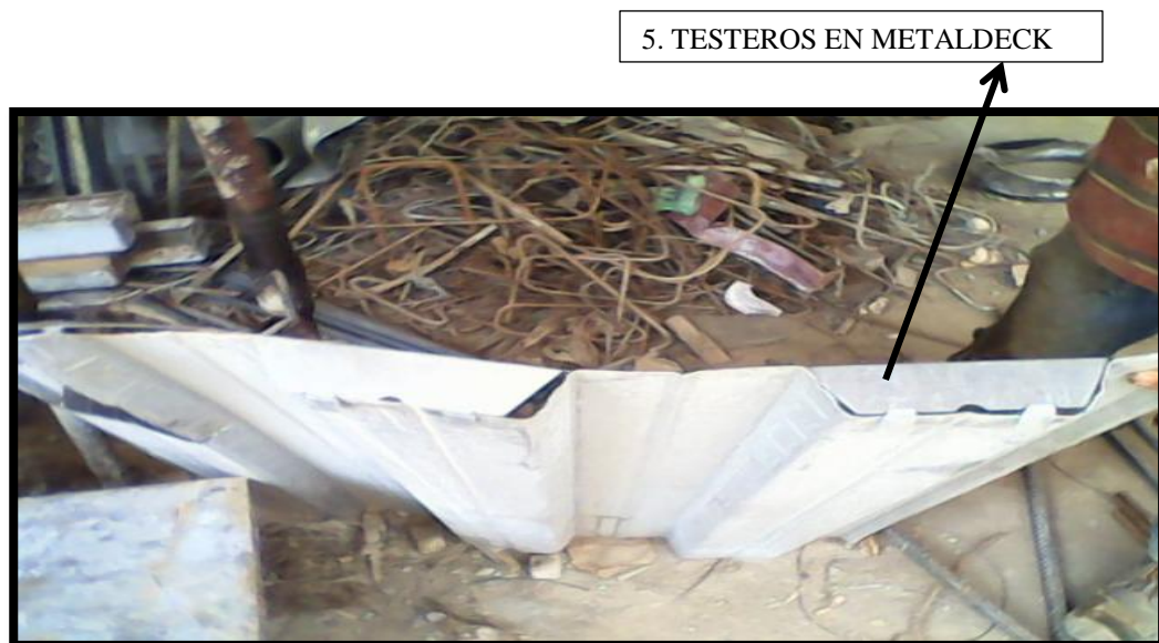
Figura 8. Instalación de testers en lámina colaborante
