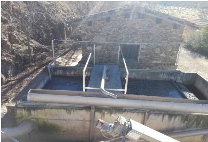
Figura 6. Desarenado (tratamiento preliminar).
