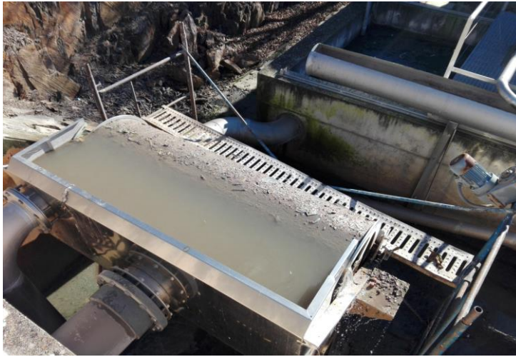
Figura 5. Tamiz rotatorio (tratamiento preliminar).
