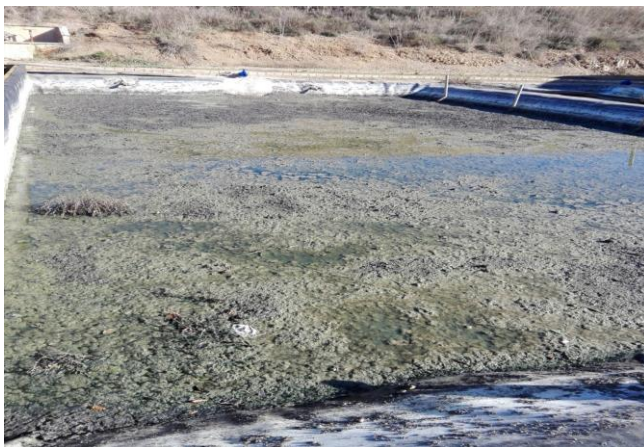
Figura 10. Secado de fangos (tratamiento secundario). Fuente: DTD
