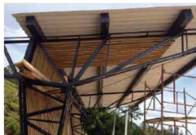
FOTOGRAFIA DE PROCESO DE INTERVENCIÓN DE PARASOL
