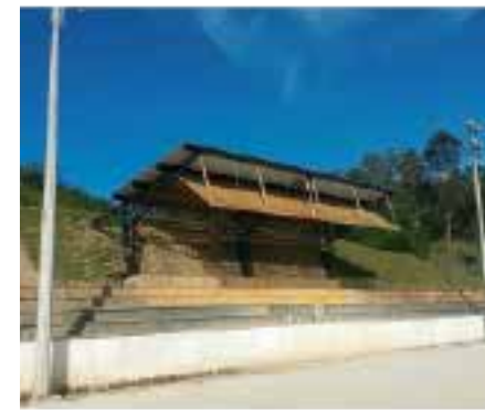
FOTOGRAFIA OBRA TERMINADA
