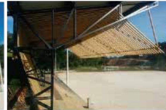
FOTOGRAFIA OBRA TERMINADA
