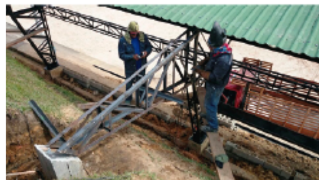
FOTOGRAFIA PROCESO DE VACIADO GRADERIA
