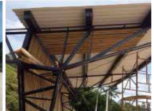
FOTOGRAFIA OBRA EN PROCESO
