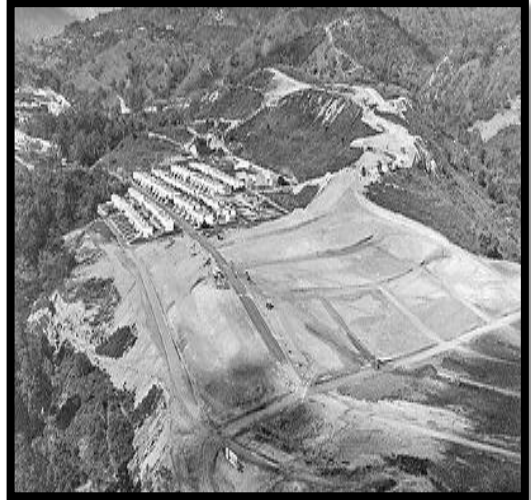
Construcción Barrio Pan de Azúcar.
