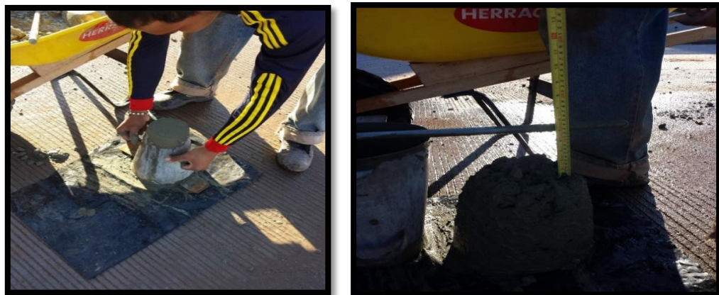
Figura 20. Prueba del Slump.
