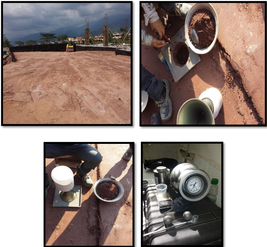
Figura 28. Ensayo Densidades Material de Relleno.
