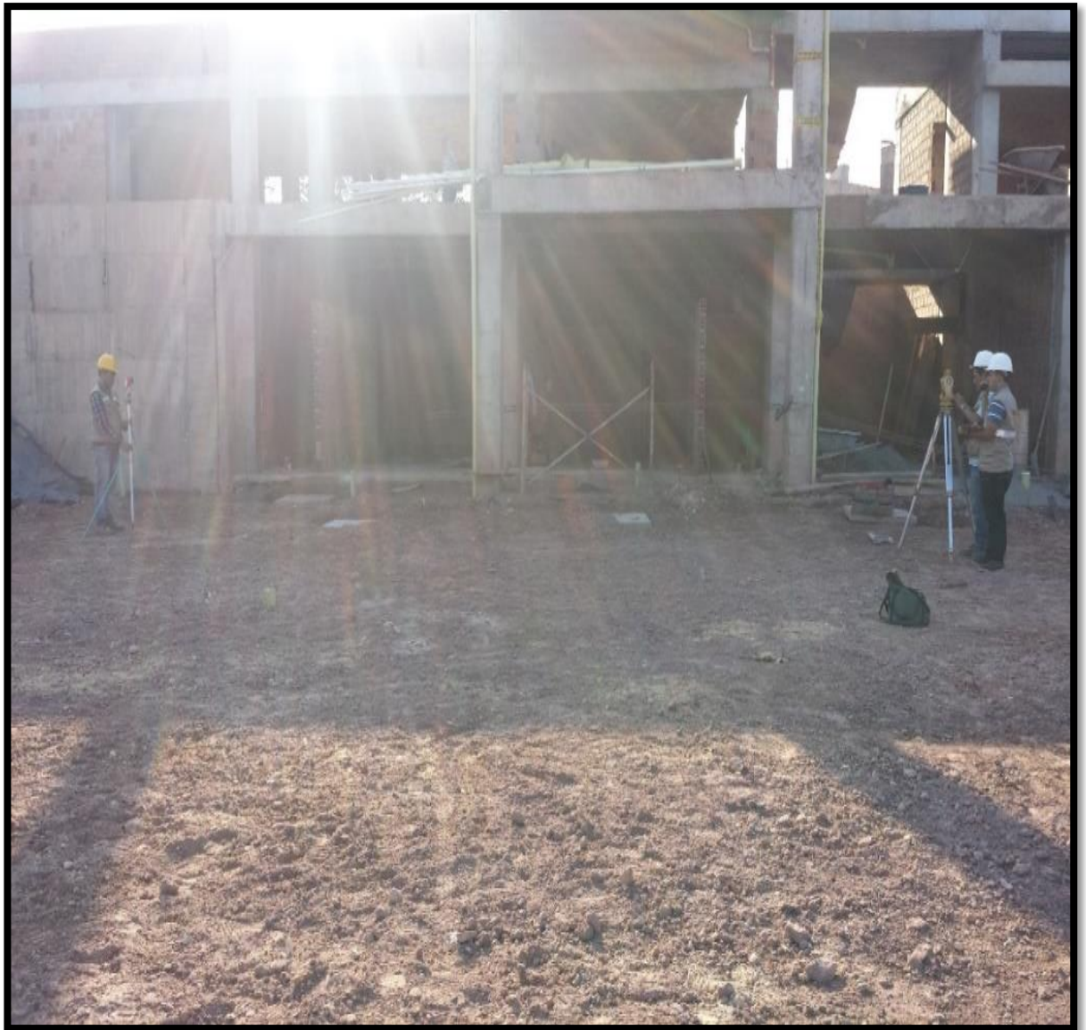
Figura 14. Realización del cierre de Poligonal.
