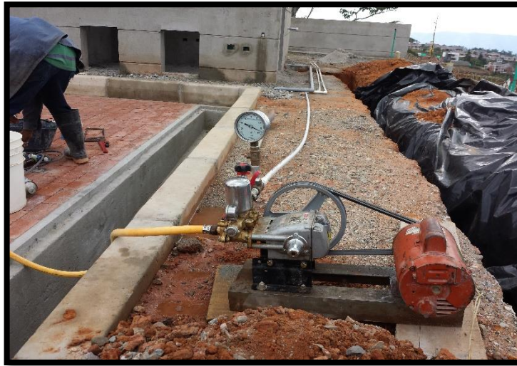
Figura 26. Prueba Hidráulica.
