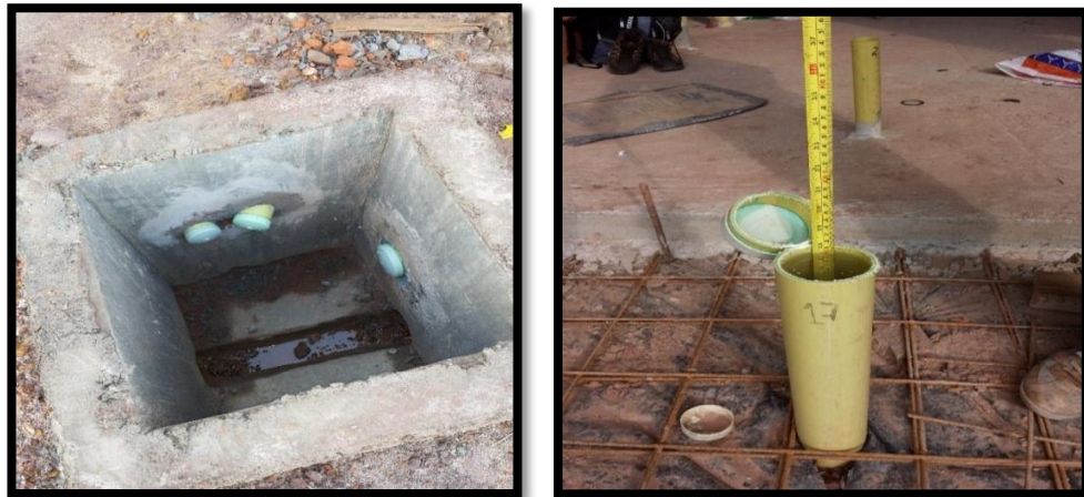
Figura 25. Prueba de Estanqueidad.
