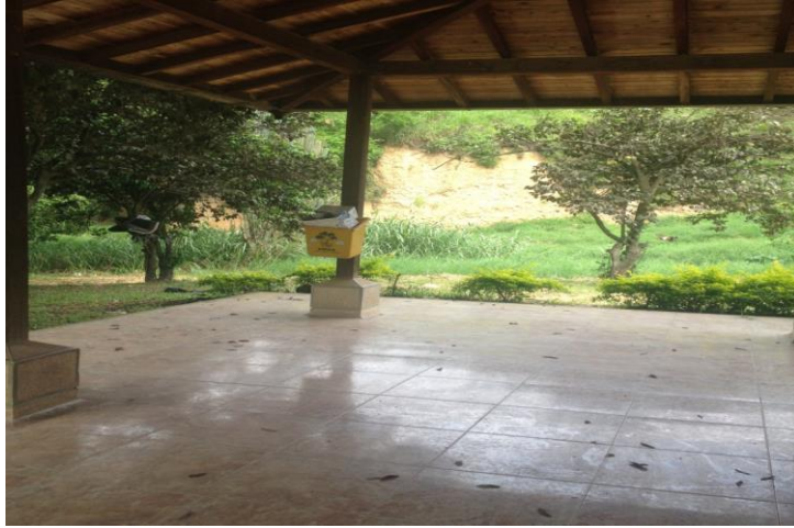
Foto 3. En esta foto se evidencia la falta de aseo en las áreas comunes.
