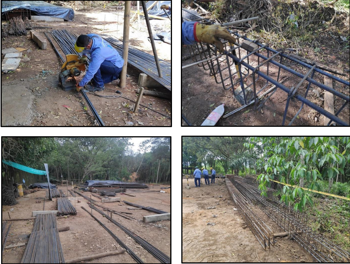
Ilustración 20. Corte, figurado y armado de hierro, fuente: propia
