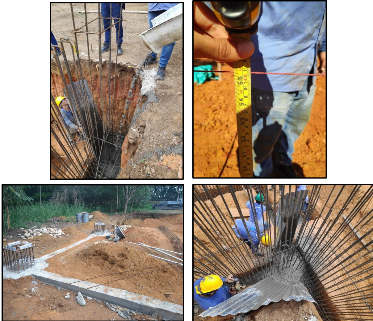
Ilustración 23. Vaciado de concreto zona bodega y oficina, fuente: propia
