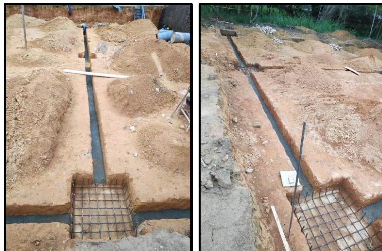
Ilustración 19. Base de solado para vigas de cimentación n-3.30, fuente: propia
