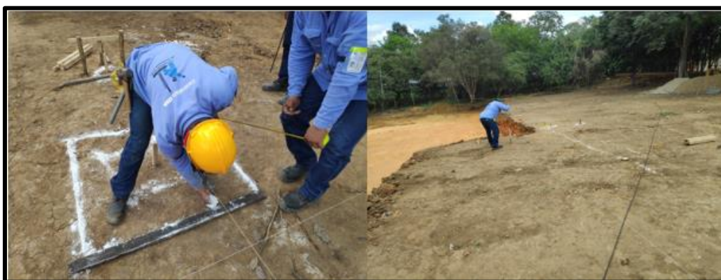
Ilustración 16. Replanteo zapatas N-3.30, fuente: propia
