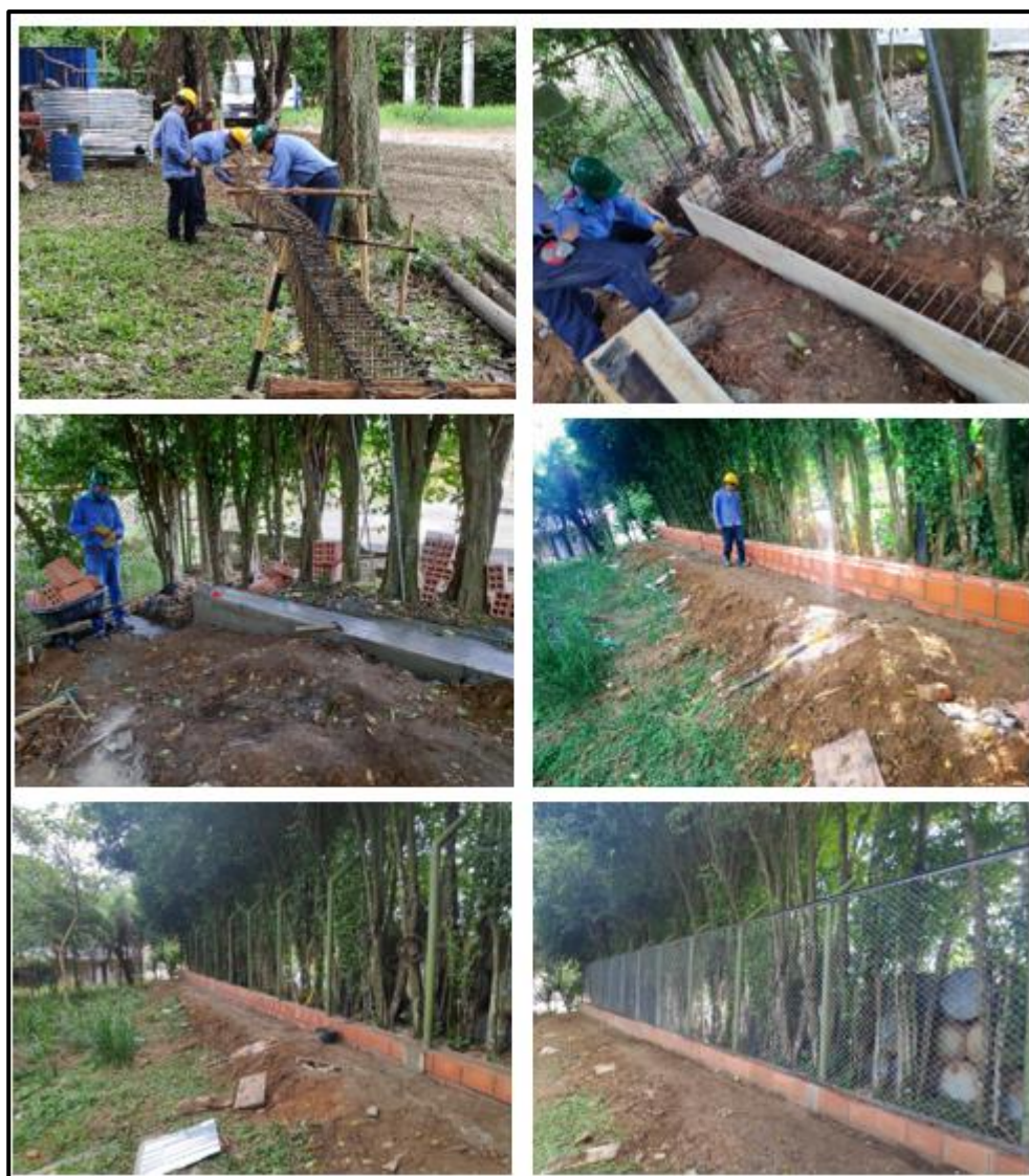
Ilustración 12. Metodología de construcción cerramiento, fuente: propia
