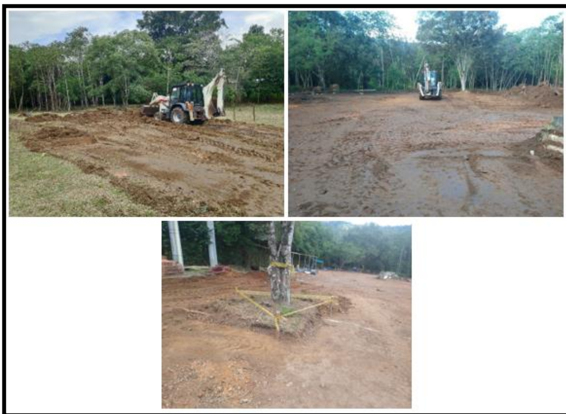
Ilustración 13. Descapote con retroexcavadora, fuente: propia
