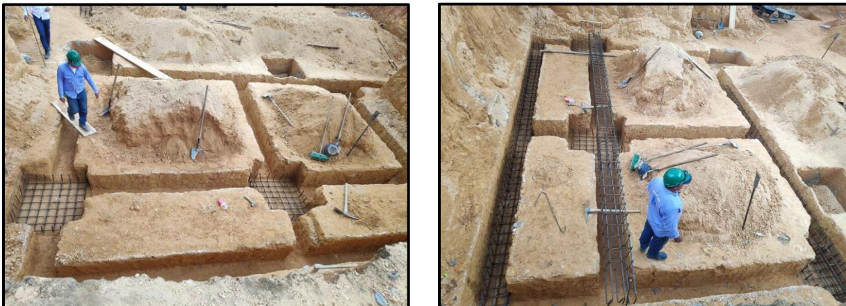
Ilustración 21. Acero de refuerzo puesto en obra, fuente: propia
