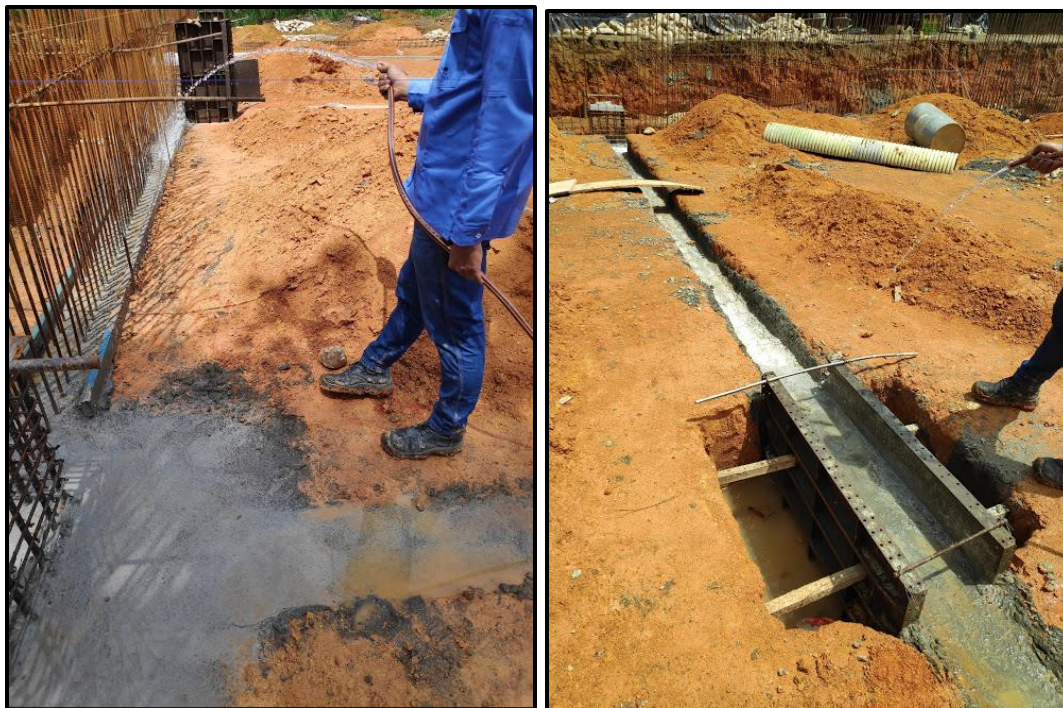
Ilustración 24. Curado vigas de cimentación, fuente: propia
