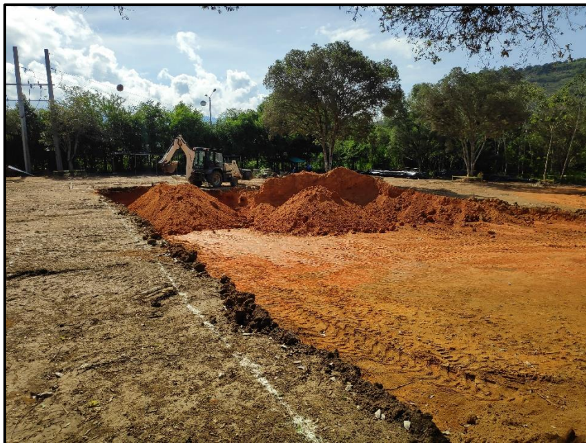
Ilustración 15. Excavación bodega N-3.30, fuente: propia
