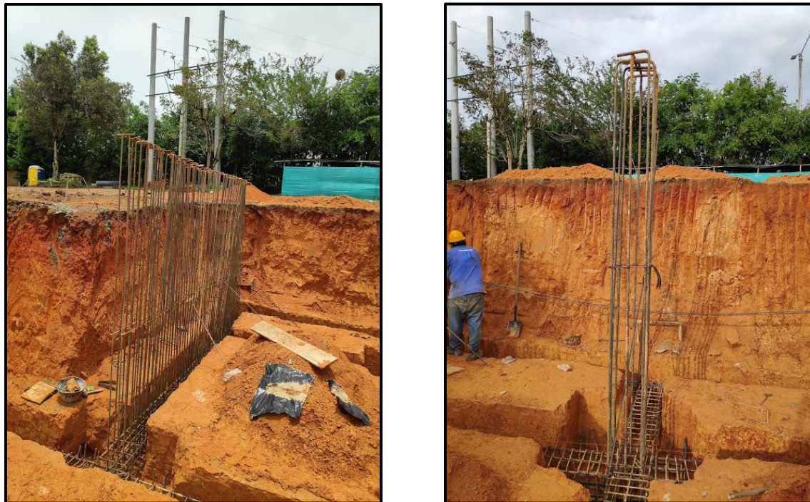
Ilustración 22. Distribución de muros de contención y columnas en obra n-2.90 oficina, fuente: propia
