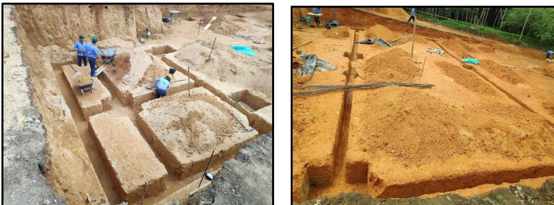
Ilustración 18. Excavación bodega y oficina nivel n-3.30, fuente: propia
