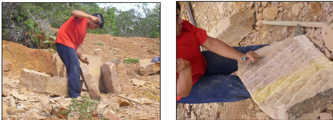
Figura 24. Forma de labrado de la piedra
