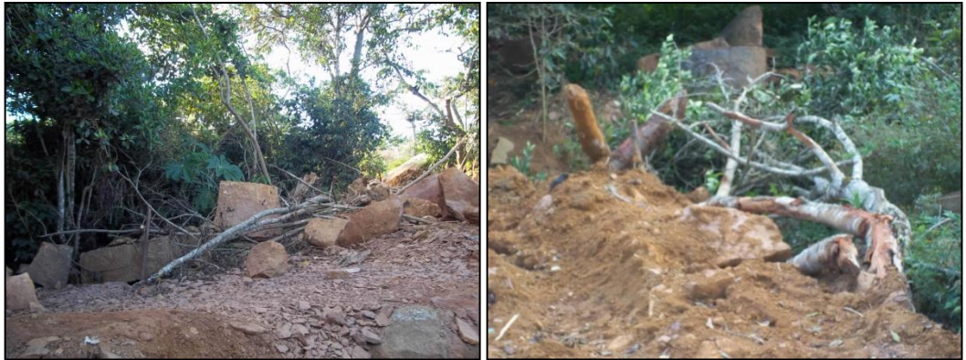
Figura 26. Descapote del área
