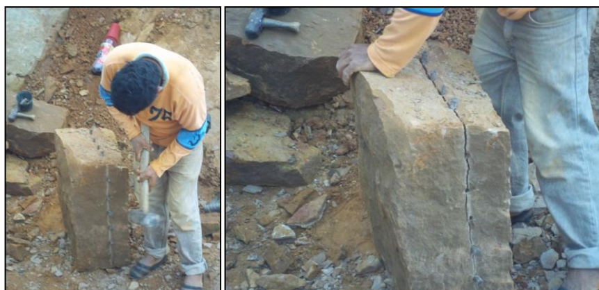
Figura 14. Fragmentación de los bloques extraídos
