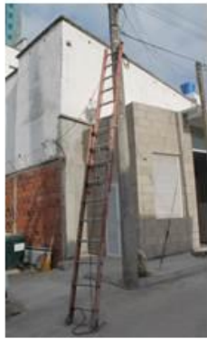
Escalera sin asegurar.
