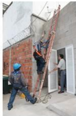
Escalera en fachada.
