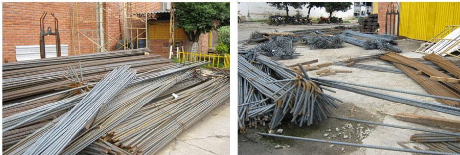
Figura 19. Entrada de la planta de figuración.
