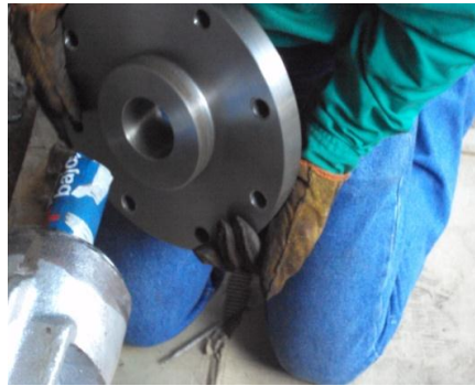
Figura 30. Roscar Acople Mecánico en Torre de la Válvula. [3]
