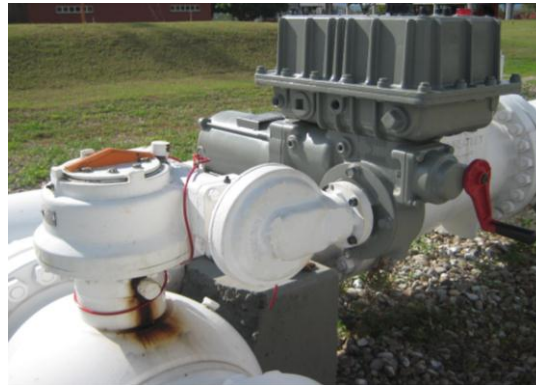
Figura 45. Acople de Actuador sobre Caja Reductora. [3]
