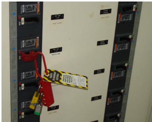
Figura 60. Identificación y Aplicación de SAES al respectivo Breaker de la MOV. [3].
