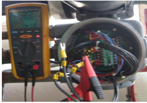
Figura 62. Pruebas de Megueo de Cables de Potencia y Comunicaciones. [3].
