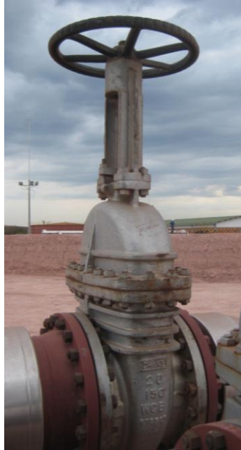
Figura 22. Válvula de Compuerta con Volante Manual. [3]
