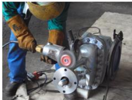
Figura 31. Limpieza de Zonas Próximas a Soldar. [3]
