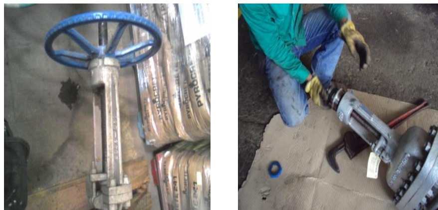
Figura 28. Retirar Piezas para Operación Manual de la Válvula. [3]
