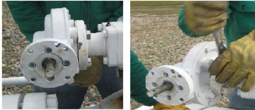
Figura 44. Montaje de Caja Reductora sobre la Válvula. [3]
