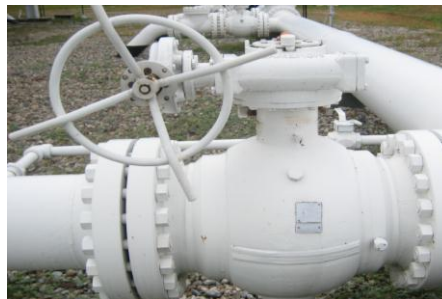
Figura 41. Válvula de bola con Caja Reductora. [3]
