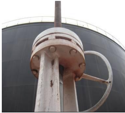
Figura 40. Retirar Caja Reductora de la Válvula. [3]
