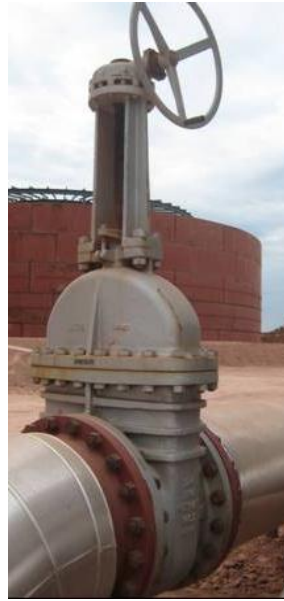
Figura 39. Válvula de Compuerta con Caja Reductora. [3]
