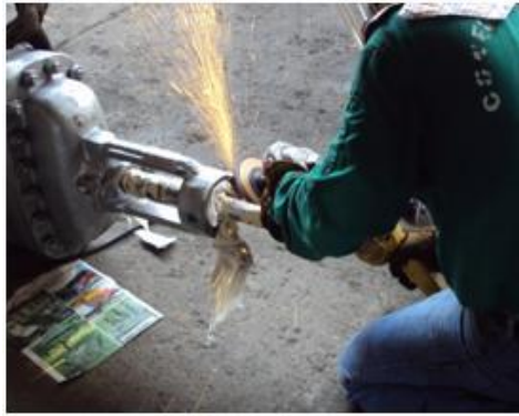
Figura 29. Realizar Bisel a Torre de la Válvula. [3]
