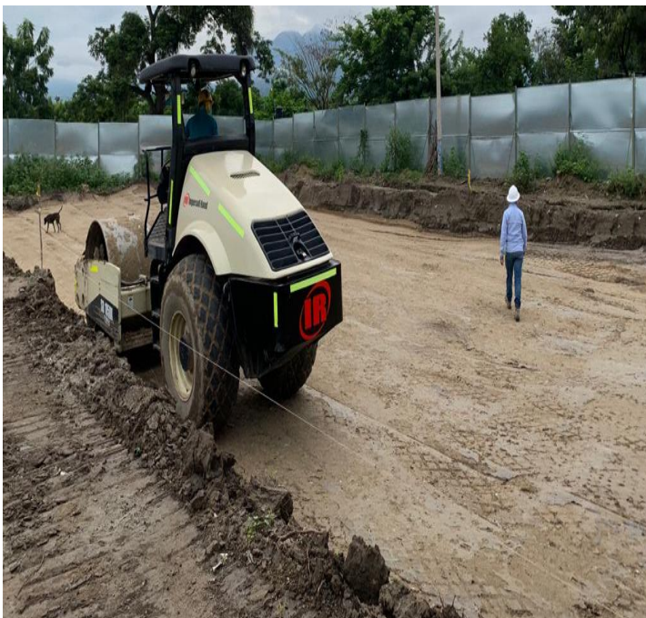
IMAGEN 27. TERRAZA 8, PRIMERA CAPA COMPACTADA.
