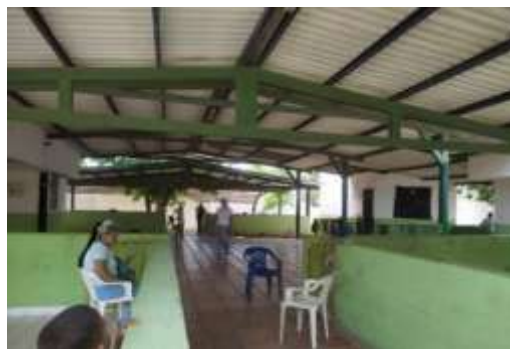
Figura 3 Interior de las instalaciones del CDI
