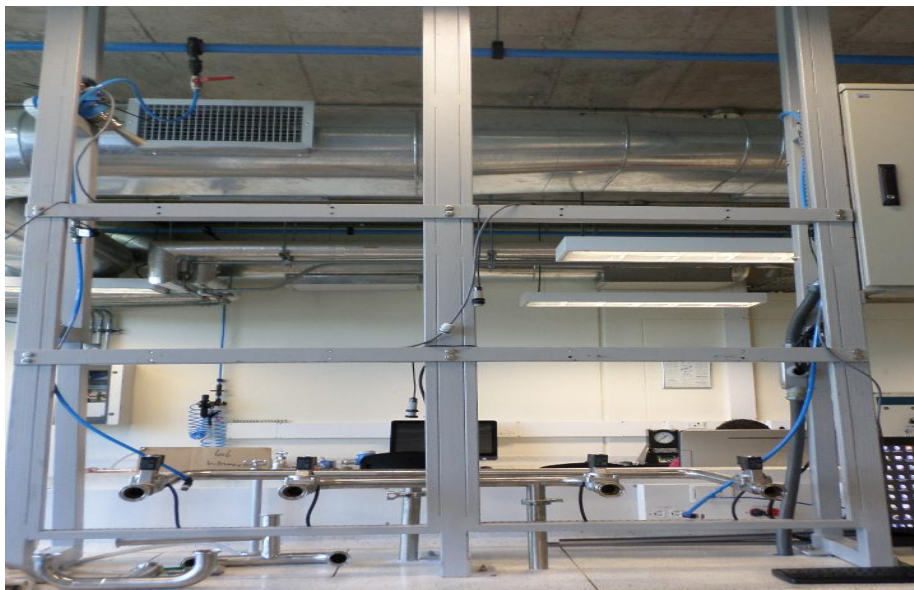
FIGURA 2-4: DESINSTALACIÓN DE LOS TANQUES DE PROCESO. FUENTE: AUTOR
