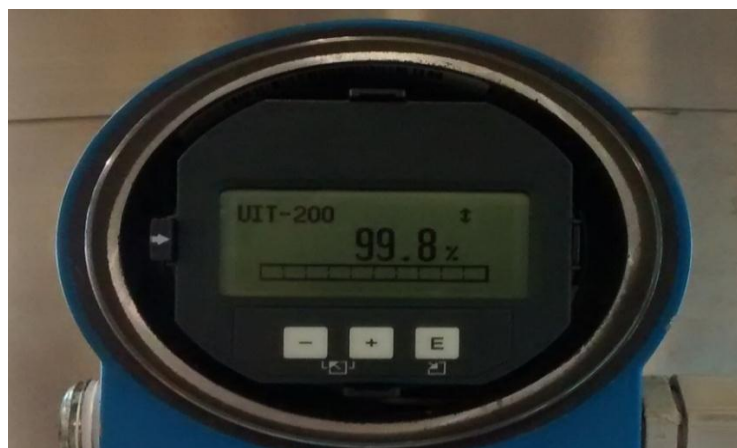
FIGURA 4-8: LECTURA DEL SENSOR DELTAPILOT M FMB50 TK-20 LLENO. FUENTE: AUTOR
