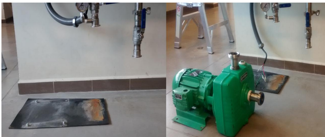
FIGURA 2-5: DESINSTALACIÓN DE LA BOMBA. FUENTE: AUTOR
