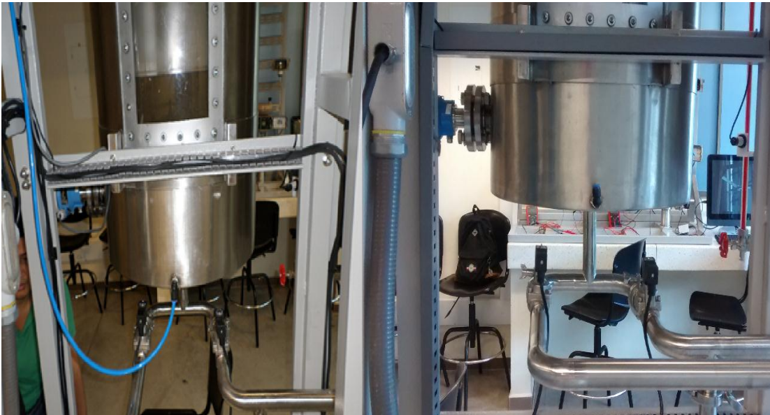
FIGURA 2-1: CORRECCIÓN DEL CABLEADO. FUENTE: AUTOR
