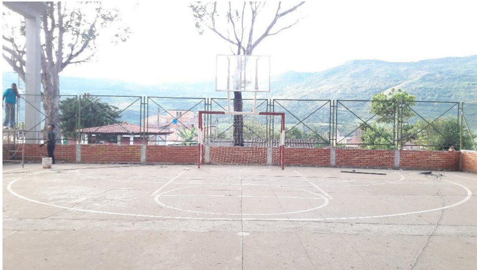
Ilustración 40. Instalación de cerramiento reparado. Fuente: Propia.
