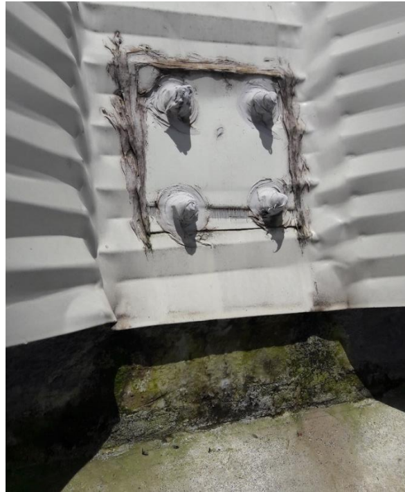
Ilustración 10. Viga canal pernos de la cubierta. Fuente: Propia.
