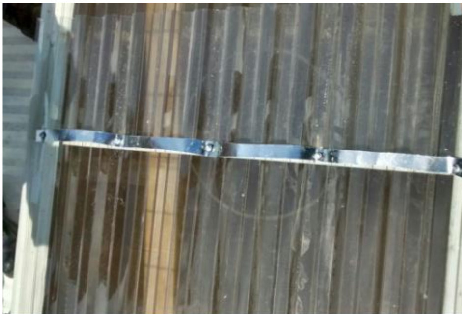
Ilustración 32. Resultados de la reparación de la cubierta. Fuente: ARQUIACERO S.A.S.
