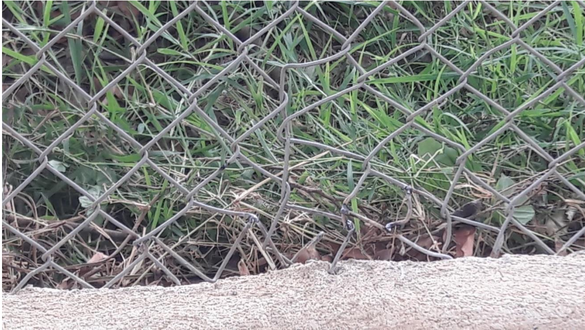
Ilustración 42. Reparaciones al cerramiento que no se cambió. Fuente: Propia.
