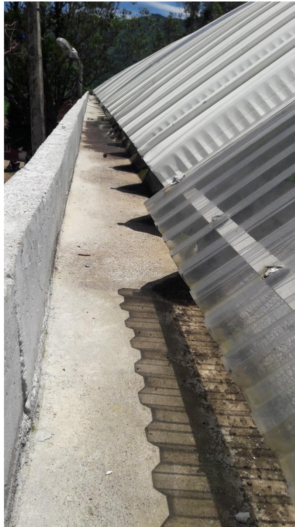
Ilustración 9. Viga canal parte interna. Fuente: Propia.
