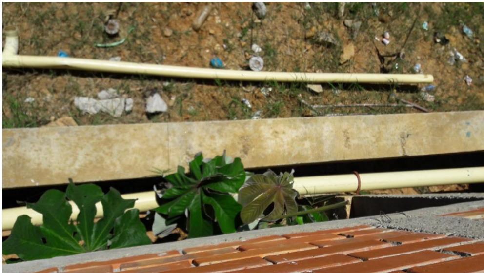
Ilustración 18. Cambio de tubo. Fuente: Propia.
