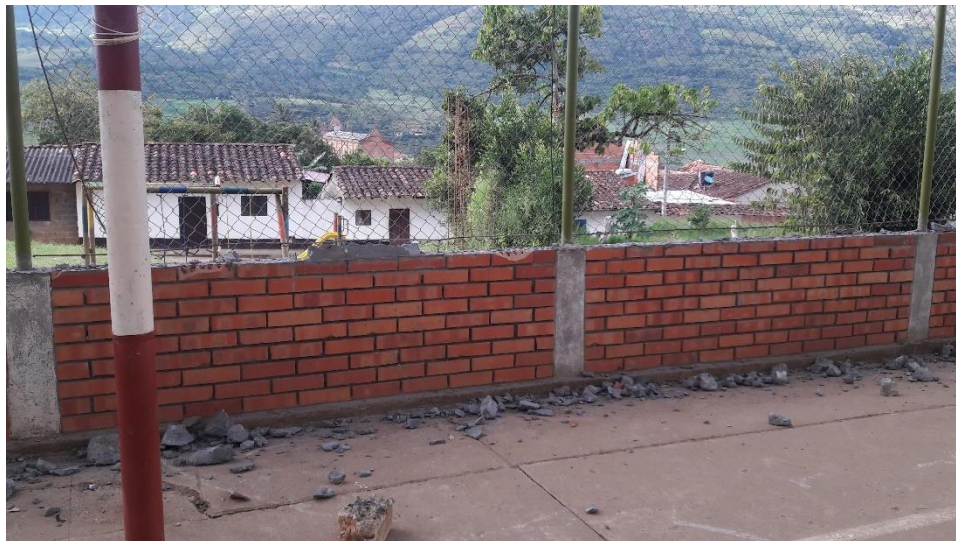
Ilustración 37. Desinstalación de la malla. Fuente: Propia.
