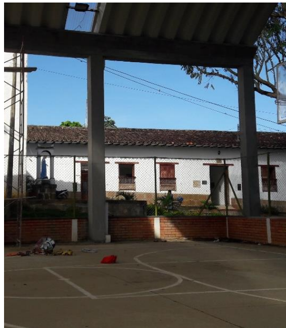
Ilustración 28. Acabados finales de las columnas. Fuente: Propia.
