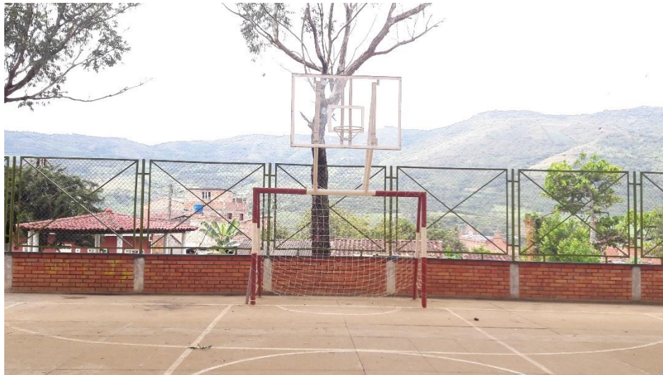
Ilustración 41. Cerramiento terminado. Fuente: Propia.
