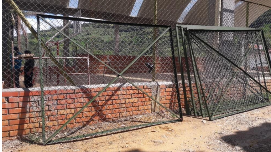
Ilustración 38. Cerramiento reparado. Fuente: Propia
