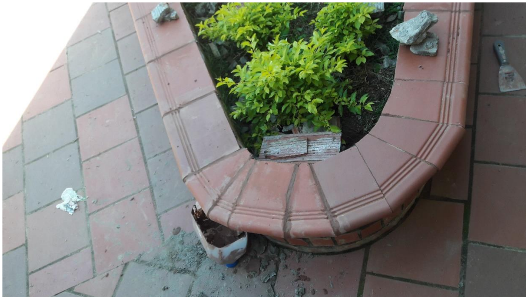
Ilustración 26. Reparaciones en la cerámica del Hospital Municipal. Fuente: Propia.
