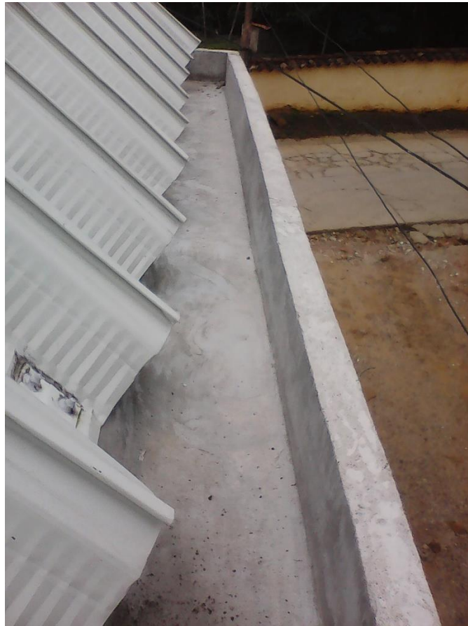
Ilustración 12. Limpieza general de la viga canal Fuente: Propia.
