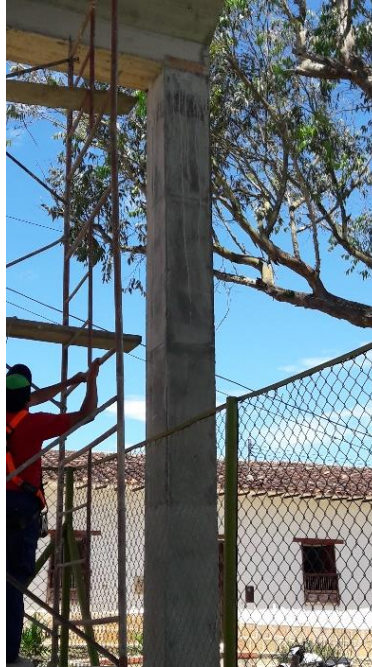
Ilustración 27. Limpieza de columnas. Fuente: Propia.
