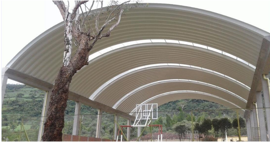
Ilustración 35. Resultados finales de la cubierta. Fuente: ARQUIACEROS S.A.S.
