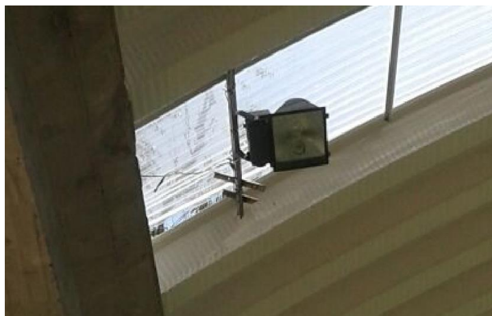
Ilustración 34. Reparación en la zona de la lámpara. Fuente: ARQUIACEROS S.A.S.
