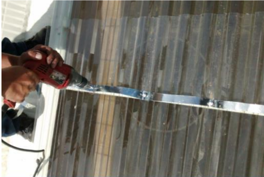
Ilustración 31. Reparaciones de la cubierta. Fuente: ARQUIACERO S.A.S.
