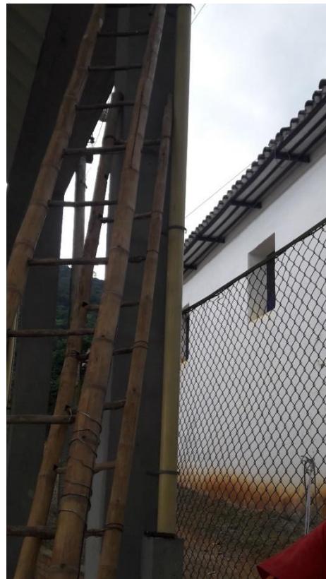
Ilustración 20. Instalación de Abrazaderas. Fuente: Propia.
