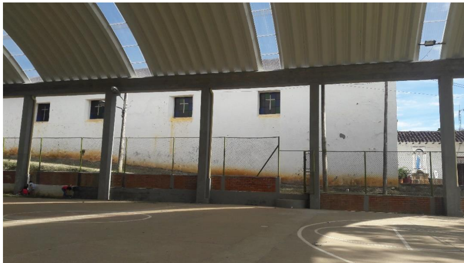
Ilustración 16. Limpieza de la viga canal parte externa. Fuente: Propia.
