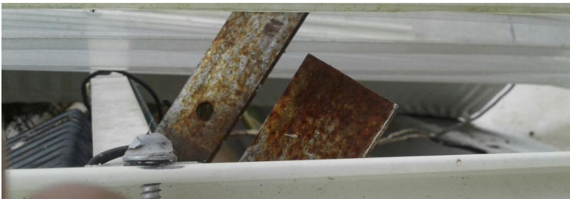
Ilustración 33. Reparaciones en la zona de la lámpara. Fuente: ARQUIACEROS S.A.S.
