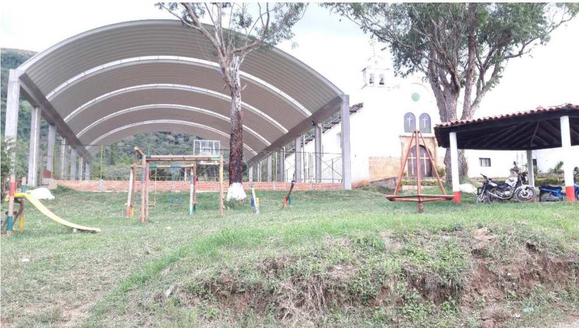
Ilustración 43. Proyecto terminado. Fuente: Propia.
