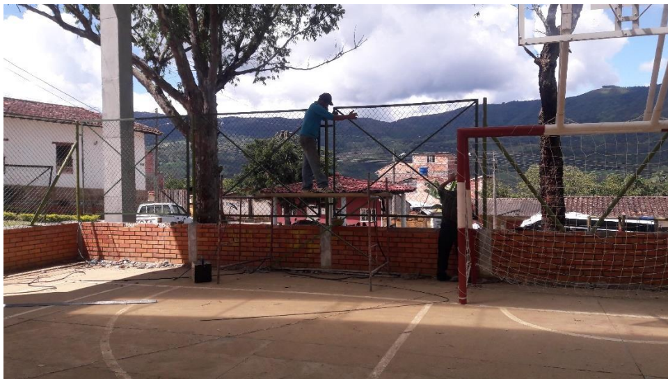
Ilustración 39. Instalación del cerramiento reparado. Fuente: Propia.
