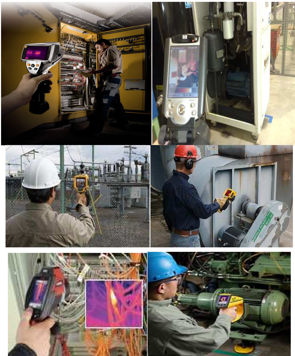
Figura 21. Mantenimiento usando termografía infrarroja [9], [12], [13]
