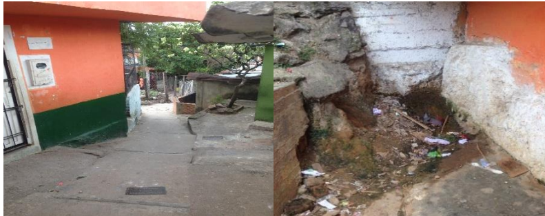
Ilustración 8, Afloramiento vivienda, Barrio transición II
