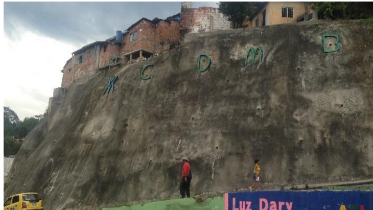
Ilustración 10, Obra estabilización, Morrórico.
