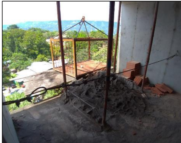
Ilustración 30. Entarimado en piso 4, torre 3
