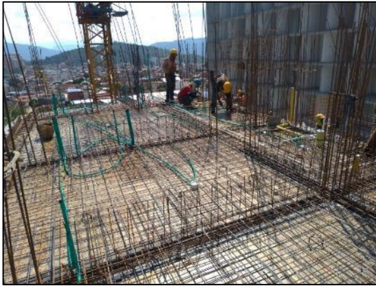
Ilustración 12. Armado de placa
