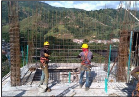
Ilustración 35. Instalación de mallas electrosoldadas en el alma del muro
