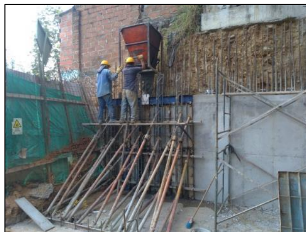
Ilustración 18. Fundida de muro de contención calle 11
