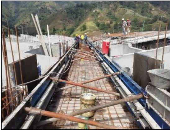
Ilustración 15. Armado de viga canal torre 3
