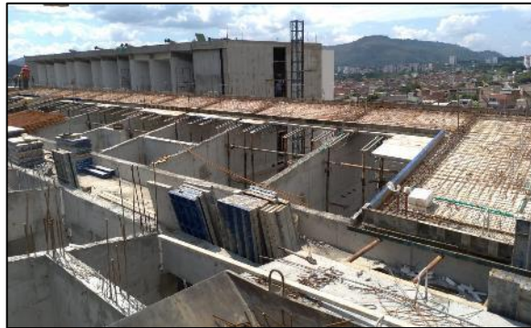
Ilustración 14. Armado cubierta torre 3
