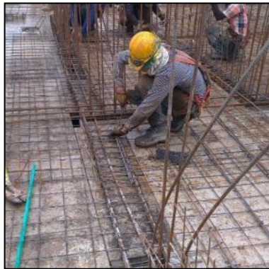
Ilustración 38. Vigas en placa
