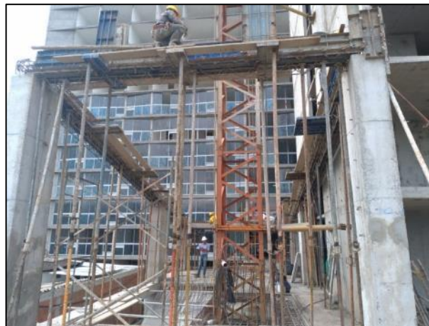
Ilustración 22. Armado pórtico módulo 4
