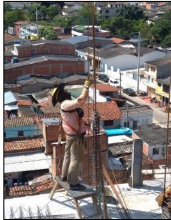
Ilustración 33. Armado de flejes y traslajos de varillas
