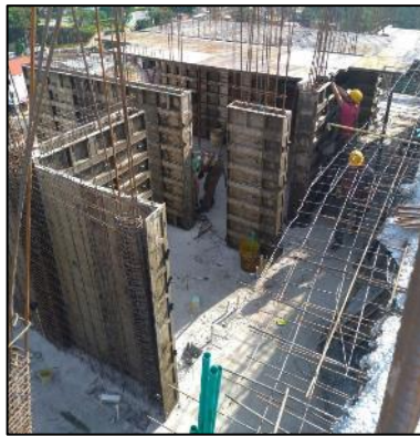
Ilustración 32. Modulación de muros con FORSA Alum
