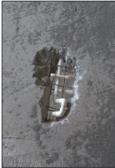
Ilustración 24. Arreglo en placa de fuga en red hidráulica
