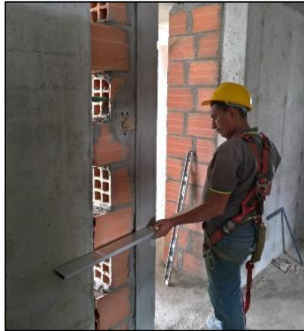
Ilustración 23. Inspección de alineamiento en vano de entrada apartamento T3
