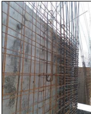
Ilustración 36. Instalación de conectores de elemento de borde y malla
