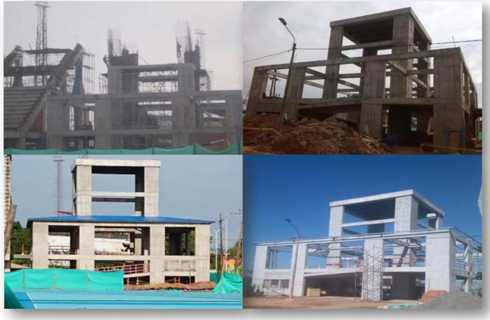
Figura 11. Torre Sur-Occidental Estadio Daniel Villa Zapata.
