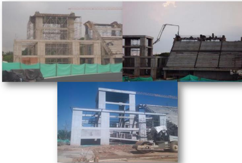
Figura 12. Torre Sur-Oriental Estadio Daniel Villa Zapata.
