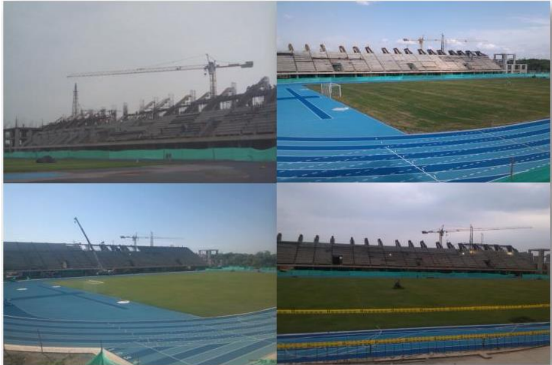
Figura 8. Gradería oriental Estadio Daniel Villa Zapata.
