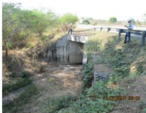
Imagen 8 Alcantarillado y Box culvert en perfectas condiciones
