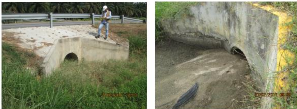
Imagen 9 Rocería y sedimentación de alcantarillas
