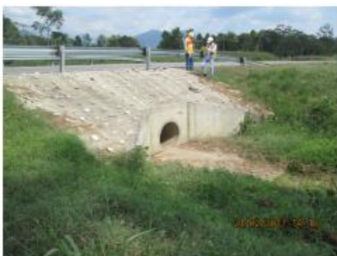
Imagen 8 Alcantarillado y Box culvert en perfectas condiciones
