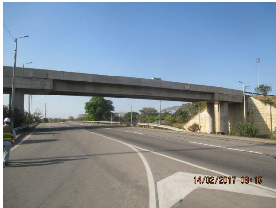
Imagen 4 Panorámica Puente Aguaclara
