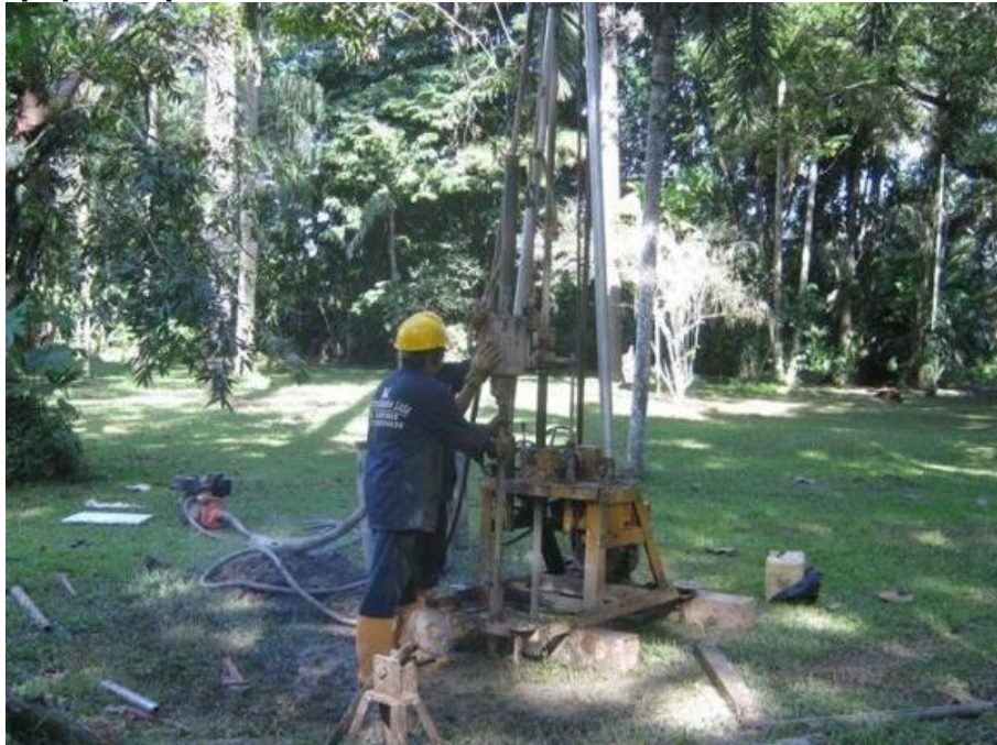
Figura 1. Equipo de perforación.
