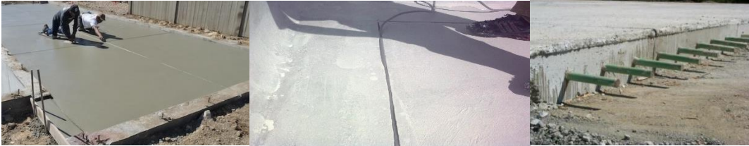
Figura 5. Juntas en concreto. Fuente: 360 Concretos-Argos Colombia[22].
