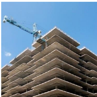
Figura1. Estructura de concreto. Fuente: Revista EMB de construcción[19].
