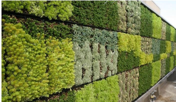
Figura 3. Ejemplo de un sistema de cajas. Fuente Verdicultura.
