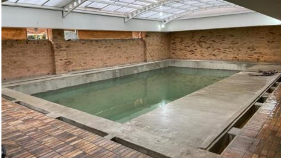
Ilustración 48 Segundo vaciado de agua equivalentes al segundo tercio de agua vaso piscina
