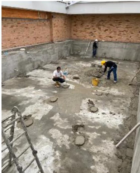
Ilustración 18 Replanteo de las maestras.
