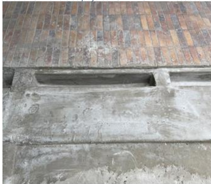
Ilustración 54 Remate de playa con SIKALASTIK - 1K costado norte
