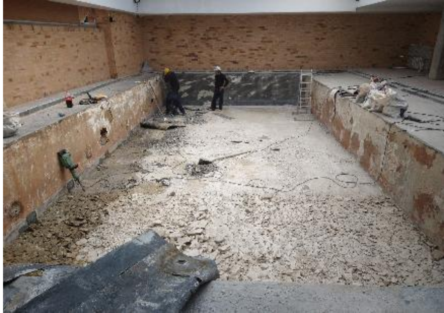
Ilustración 3 Apiques muro en mampostería.
