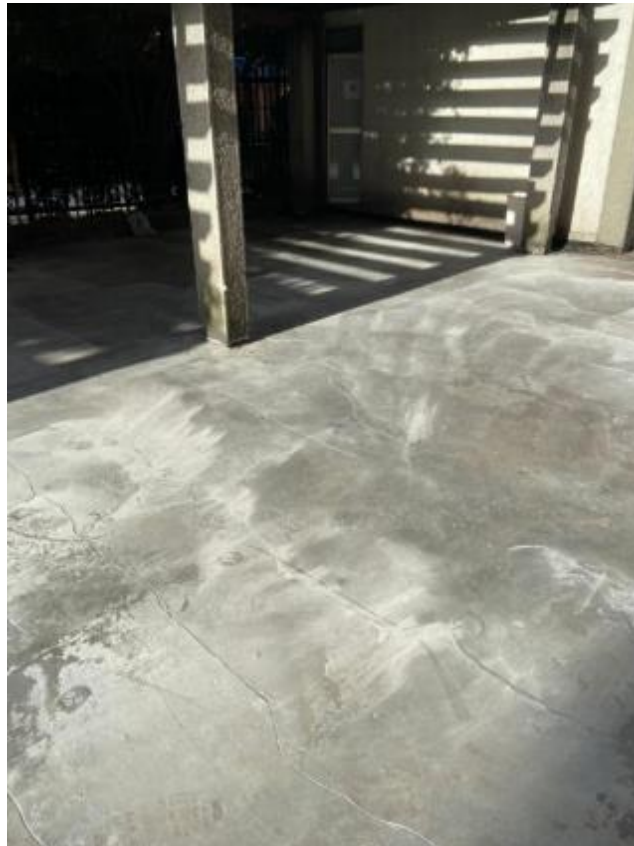
Ilustración 71 Dilatación de fisuras con disco de corte
