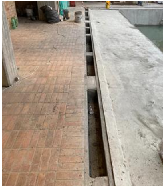
Ilustración 43 Acabado final cárcamos desnatadores.
