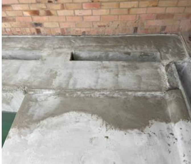
Ilustración 53 Remate de playa con SIKALASTIK - 1K costado sur
