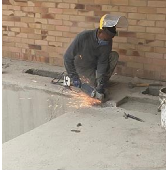
Ilustración 50 Adecuación borde de playa con pulidora.
