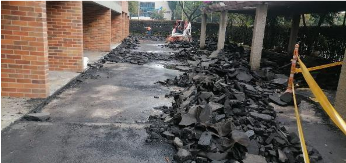
Ilustración 67 Retiro de escombros con BOB CAT
