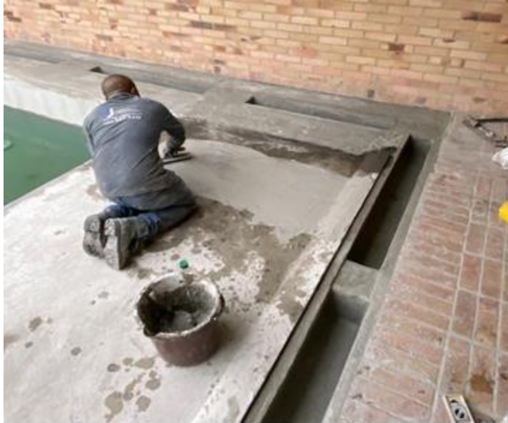
Ilustración 38 Aplicación SIKALASTIK - 1K playa piscina con llana.
