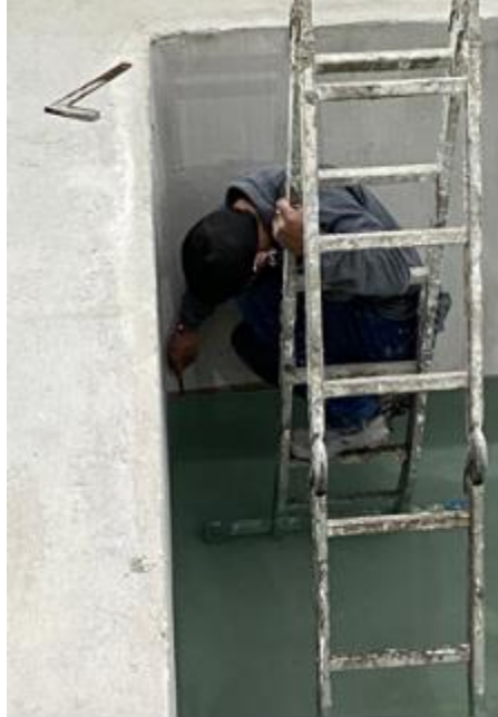
Ilustración 47 Señalización nivel lámina de agua
