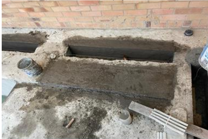
Ilustración 51 Remate playa costado sur.
