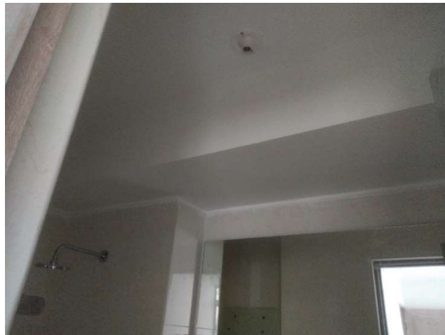
FIGURA 30. DRYWALL BAÑO PRINCIPAL
