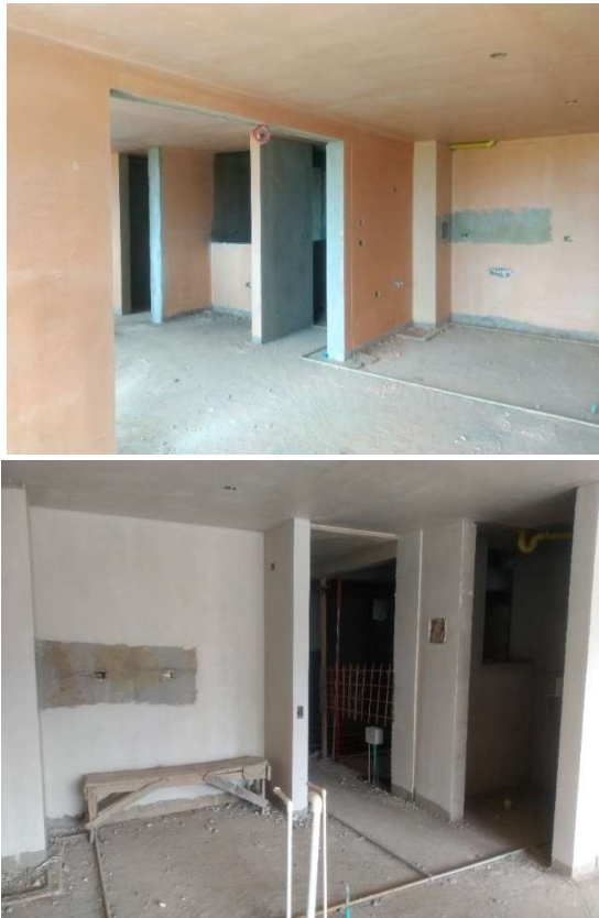
FIGURA 22. APLICACIÓN DE ESTUCO
