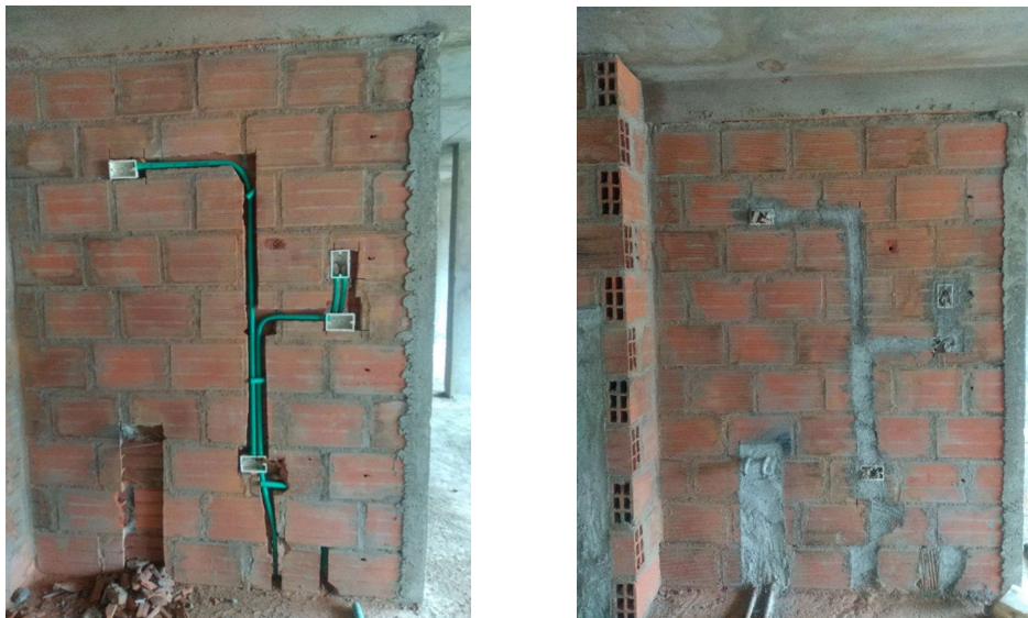
FIGURA 20. REGATAS MURO DE ESTUDIO
