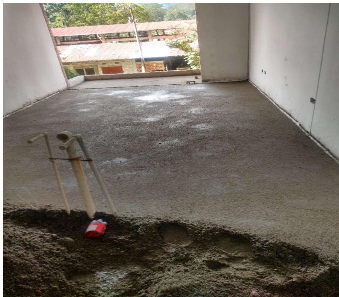
FIGURA 23. APLICACIÓN DE MORTERO
