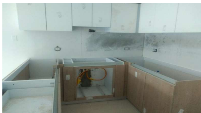
FIGURA 32. INSTALACIÓN CARPINTERÍA COCINA
