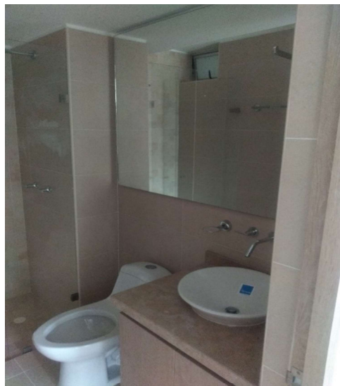
FIGURA 38. INSTALACIÓN DE ESPEJOS
