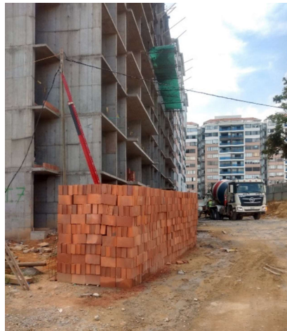
FIGURA 46. AVANCE DE OBRA
