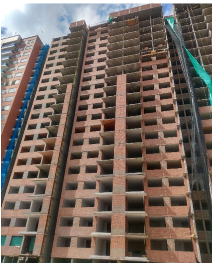
FIGURA 14. AVANCE EN FACHADA TORRE 1
