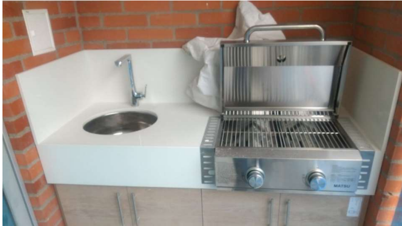
FIGURA 36. INSTALACIÓN DE BBQ Y LAVAMANOS
