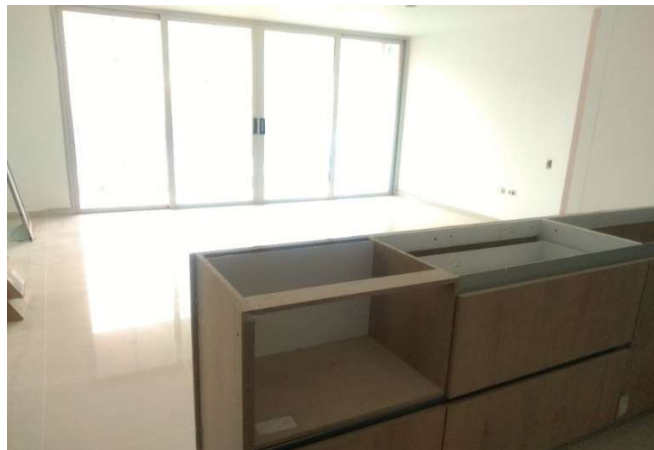
FIGURA 31. INSTALACIÓN CARPINTERÍA COCINA
