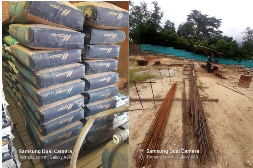
FIGURA 51. INSPECCIÓN DE ESTADO DE MATERIALES.
