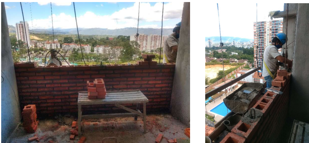
FIGURA 16. MAMPOSTERÍA FACHADA ALCOBAS
