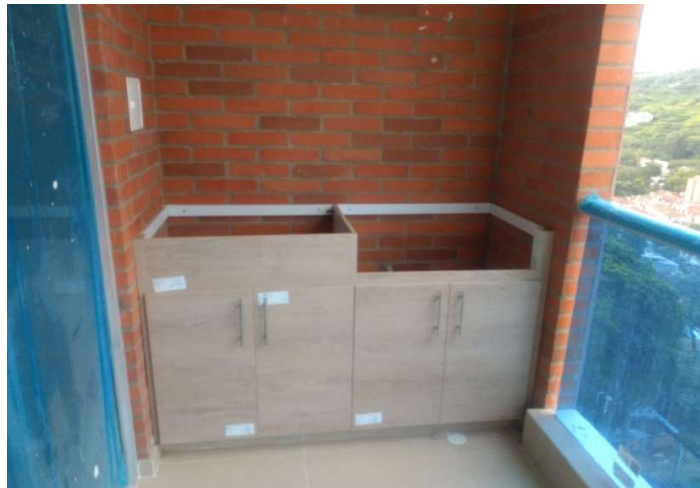
FIGURA 33. INSTALACIÓN CARPINTERÍA BBQ
