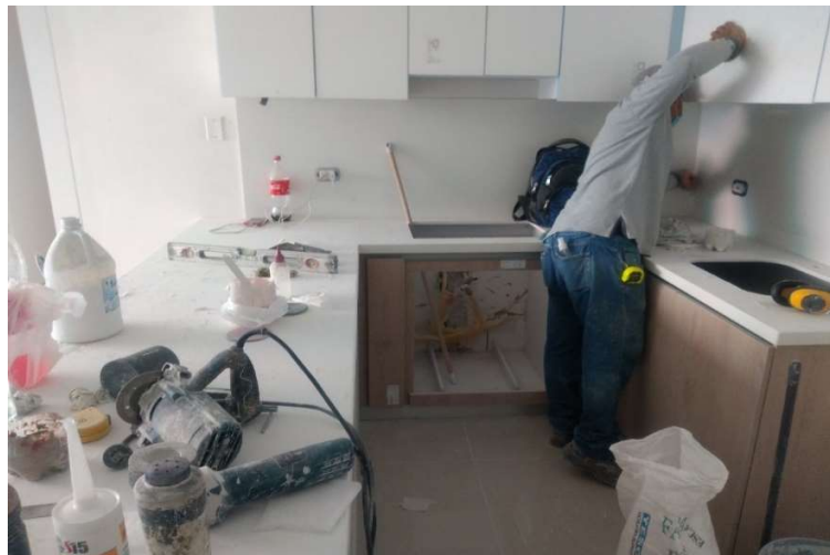
FIGURA 34. INSTALACIÓN DE MÁRMOL
