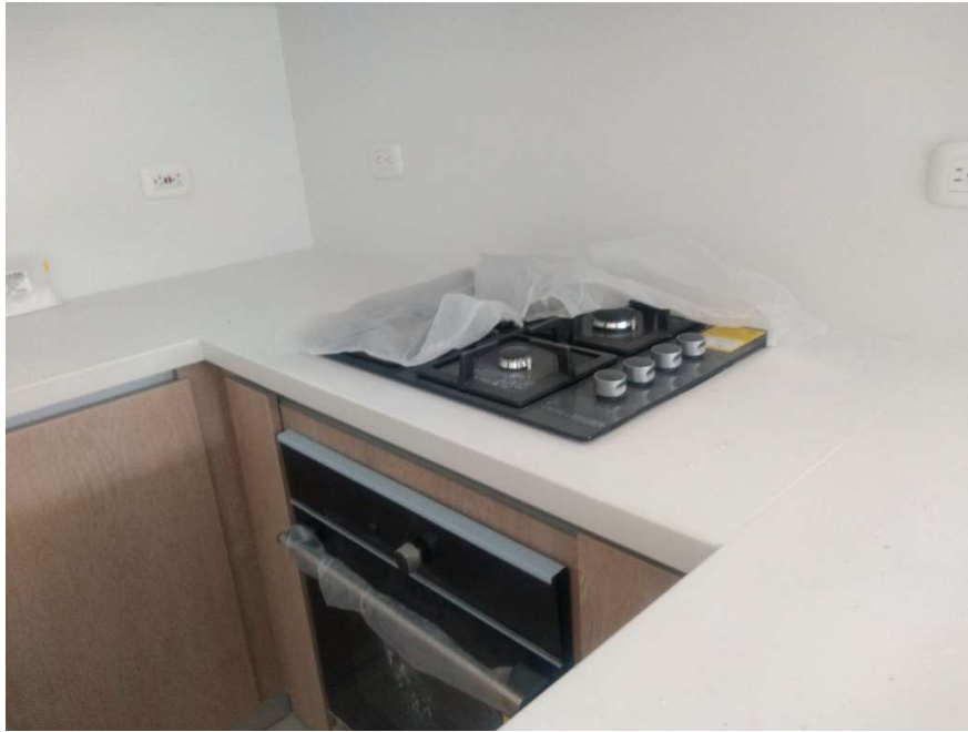
FIGURA 35. INSTALACIÓN DE GASODOMESTICOS
