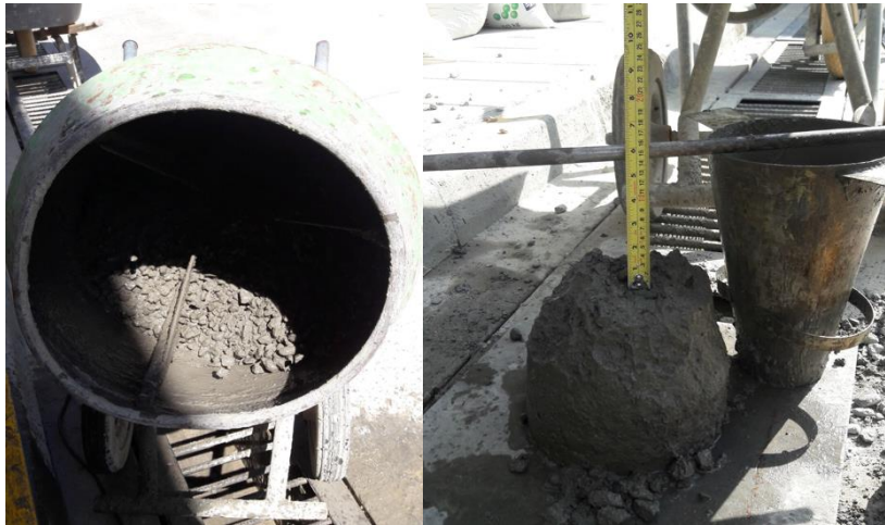
Imagen No 35. Batidas de concreto industrializado Fuente: PROPIA
