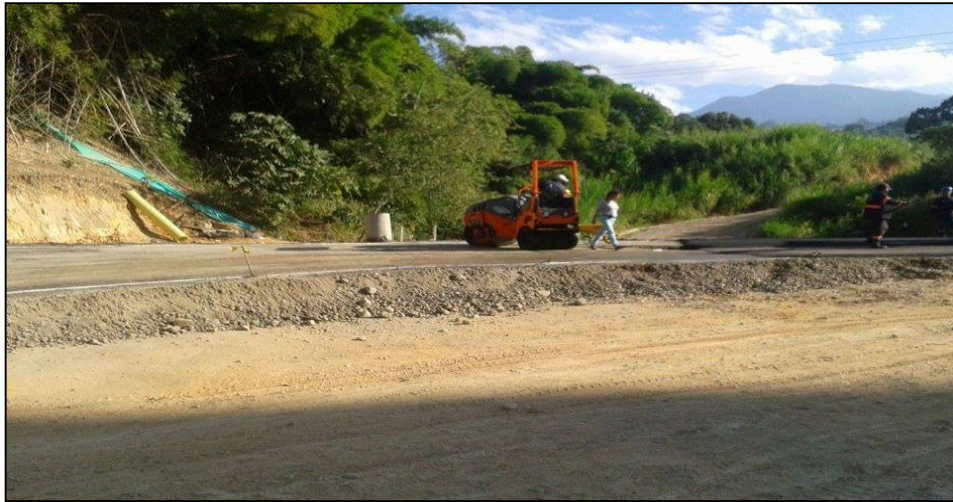
Figura 6. Compactación base tramo 4 curva
