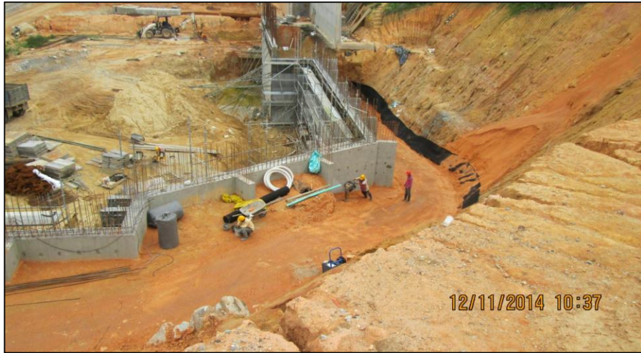
Figura 8. Compactación del relleno muro club
