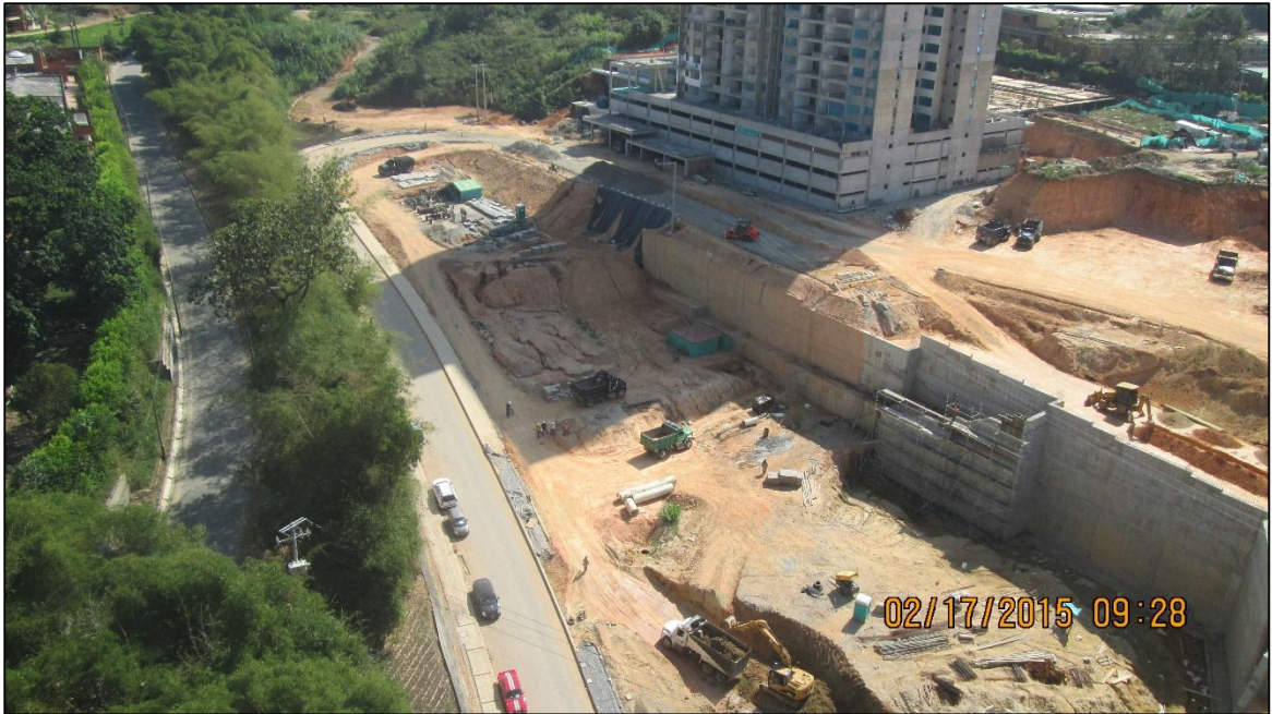
Figura 18. Panorámica tramo 3, 4,5 vía, muro club zona socia, muro escalera y Montecasino.
