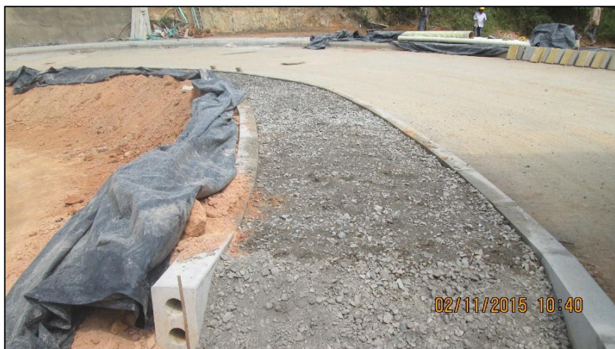
Figura 10. Base andenes tramo 4 curva
