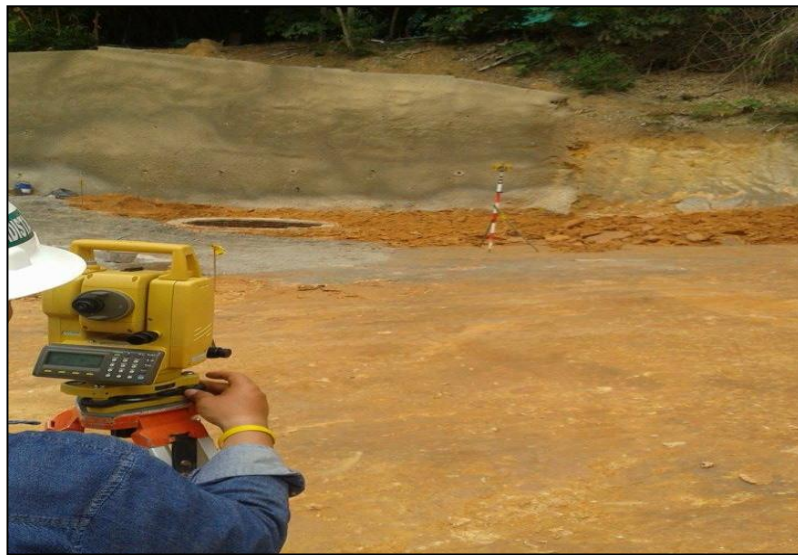
Figura 13. Calibración mensual prisma y estación total, cierre de la poligonal.
