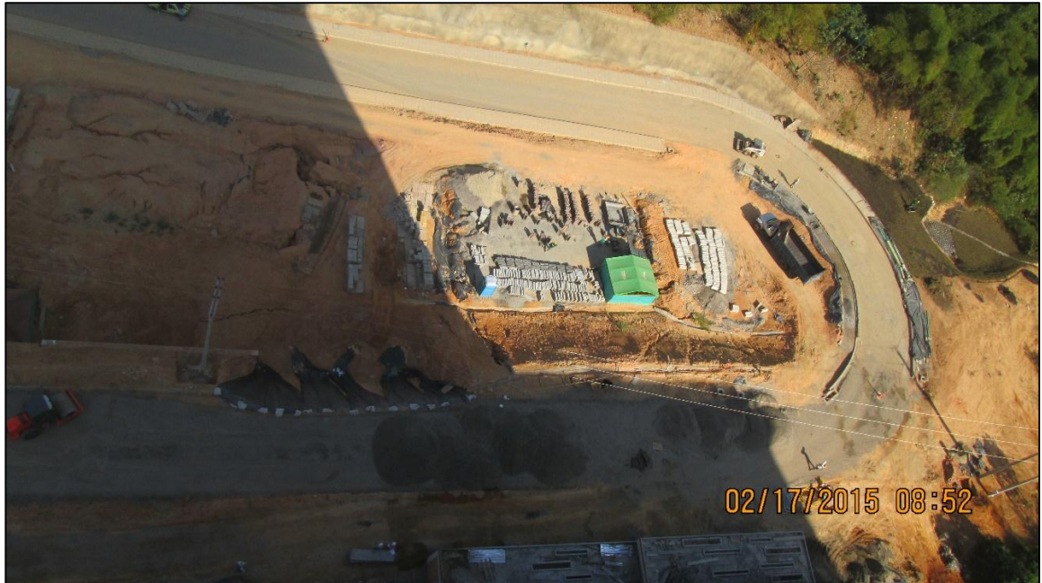
Figura 16. Panorámica Tramo 4 vía curva y tramo 5 vía, frente a Montecasino
