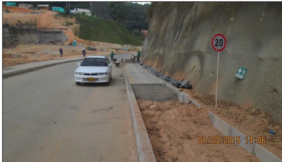
Figura 7. Puesta de andenes costado norte tramo 3 de la vía
