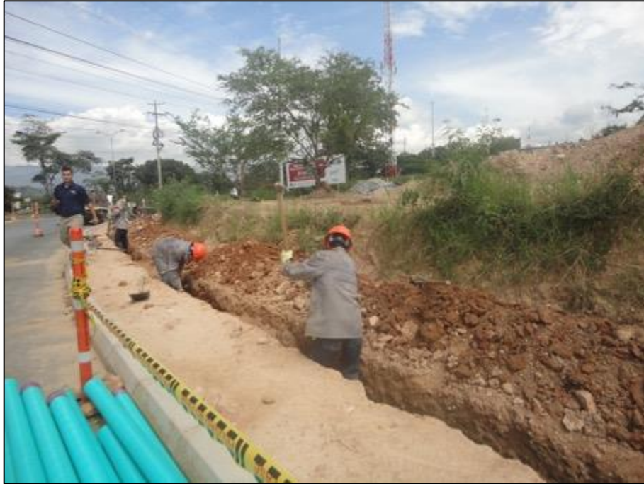
Figura 64 Re ubicación de canalización intercambiador de la intersección Transversal El Bosque – Anillo Vial Fuente: Autor
