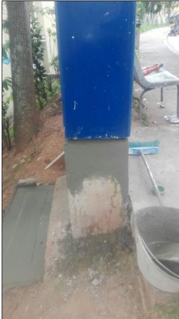
Figura 56 Mantenimiento base armario de cobre 4837 ubicado en Bellavista Fuente: Autor
