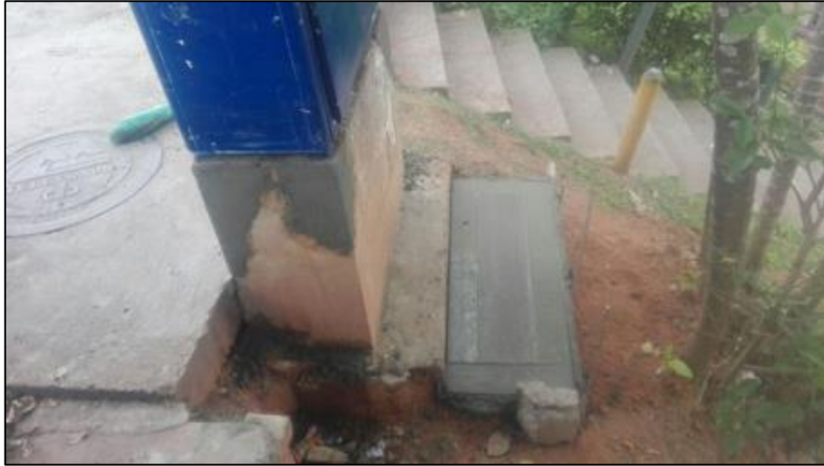
Figura 57 Mantenimiento base armario de cobre 4837 ubicado en Bellavista Fuente: Autor
