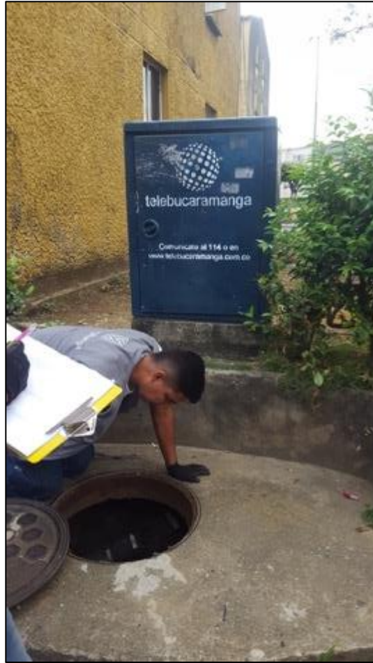
Figura 36 Inventario de canalización existente – Sector Ciudad Bolívar Fuente: Autor
