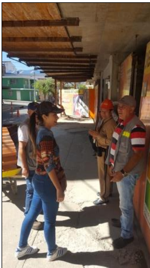
Figura 33 Levantamiento de canalización existente Fuente: Autor
