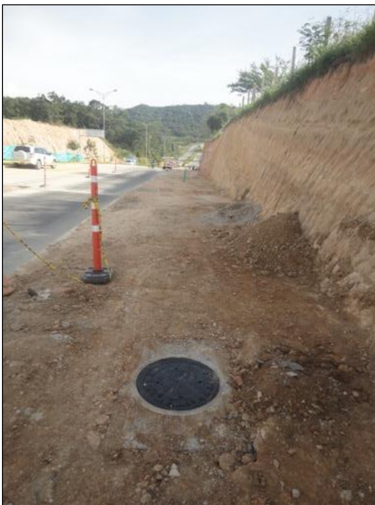
Figura 63 Re ubicación de canalización intercambiador de la intersección Transversal El Bosque – Anillo Vial Fuente: Autor
