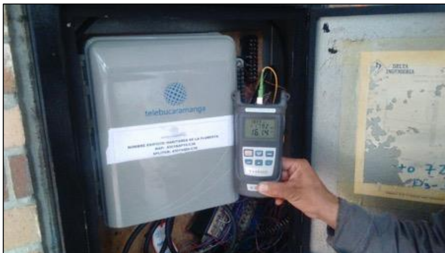
Figura 15 Nap indoor instalada en el conjunto Habitares de la Floresta Fuente: TELEBUCARAMANGA S.A
