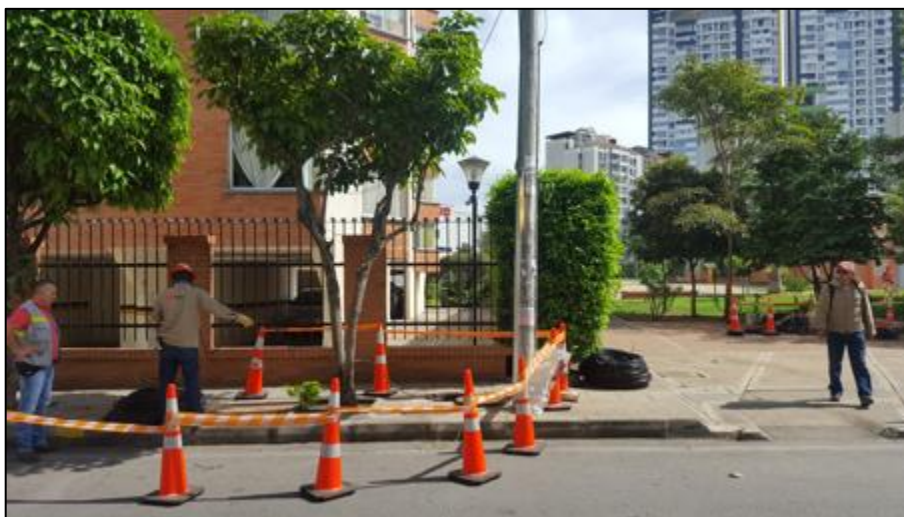
Figura 42 Supervisión tendido de fibra óptica Parque de las Cigarras – Ciudadela Real de Minas Fuente: Autor
