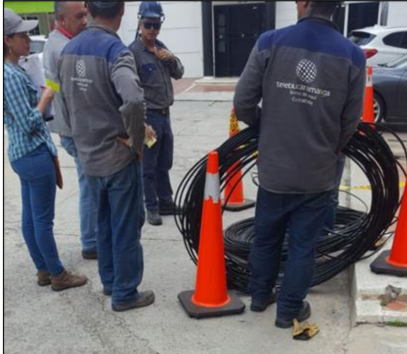
Figura 30 Supervisión del tendido de red de fibra óptica sector Cañaveral – Cra 22c con calle 35 Fuente: Autor
