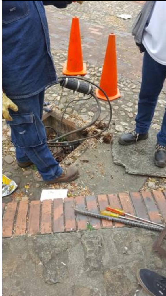
Figura 27 Levantamiento de canalización sector Plaza Mayor – Ciudadela Real de Minas Fuente: Autor
