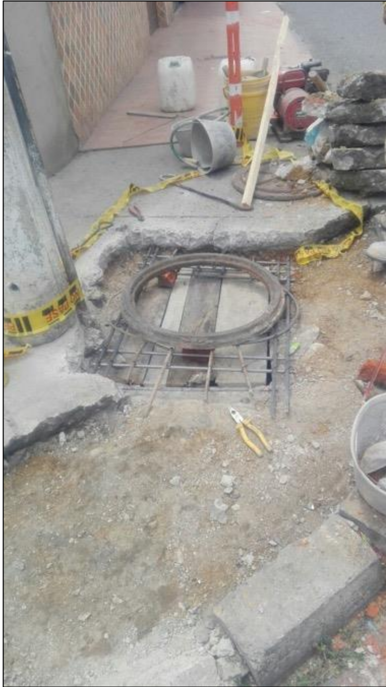
Figura 61 Reparación de la placa de la cámara sector San Rafael - Esquina calle 3 con carrera 11 Fuente: Autor
