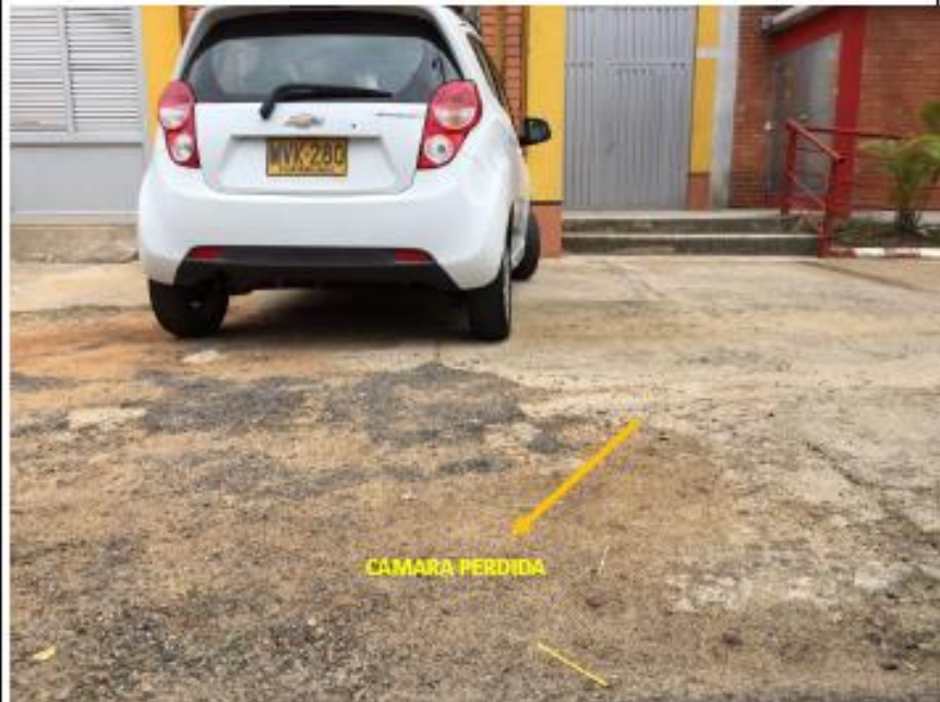
Figura 49 Ejemplo de un registro fotográfico entregado a la oficina de planeación municipal
