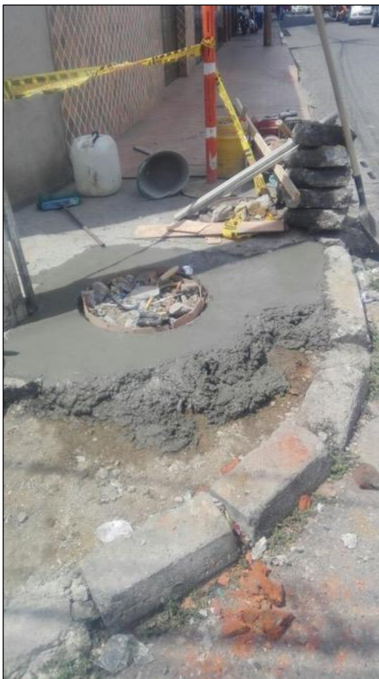
Figura 62 Reparación de la placa de la cámara sector San Rafael - Esquina calle 3 con carrera 11 Fuente: Autor
