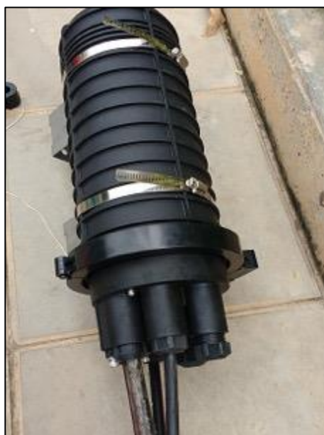
Figura 14 Domo de fibra óptica Fuente: TELEBUCARAMANGA S.A
