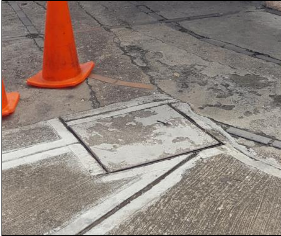
Figura 23 Tapa de rectangular de concreto sobre andén Fuente: Autor
