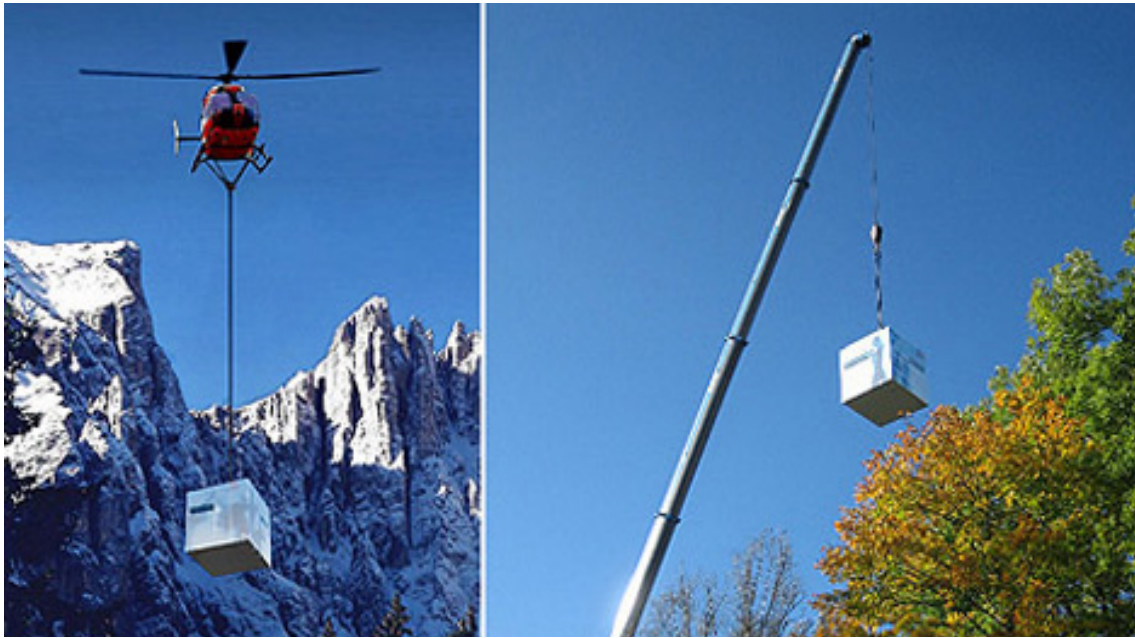
28. Transporte e instalación de unidad M-CH a Brissago, Suiza | Prototipo como casa de huéspedes
