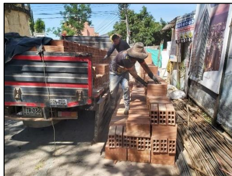
Imagen 25. Llegada de mampostería a obra
