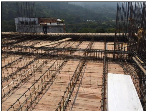
Imagen 15. Armado placa entrepiso
