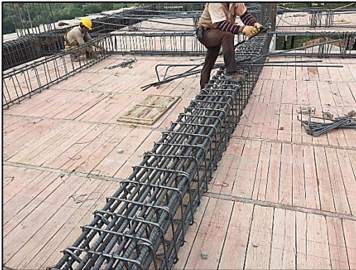
Imagen 14. Armado vigas entrepiso
