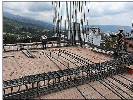
Imagen 13. Inicio armado placa entrepiso
