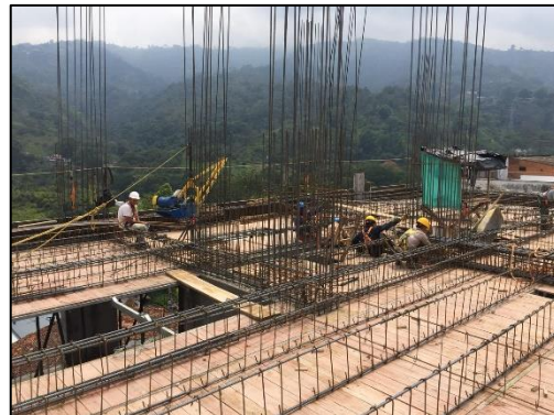
Imagen 16. Armado de columnas
