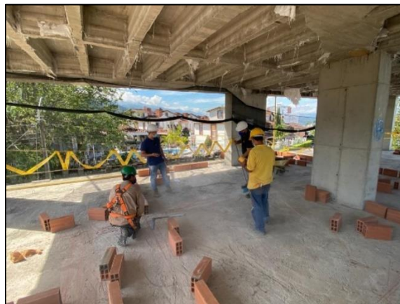
Imagen 26. Cimbrado de la mampostería
