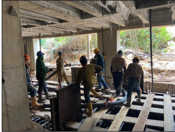
Imagen 36. Fundición del tanque
