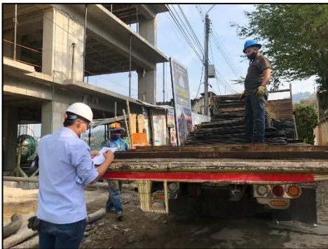
Imagen 12. Supervisión llegada del hierro
