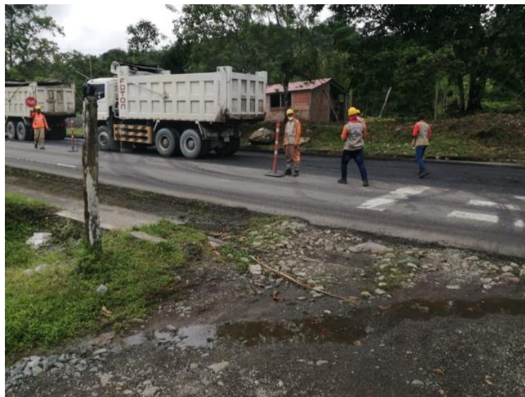
Ilustración 32, Intervención vial sector Resguardo Sever Dabeiba
