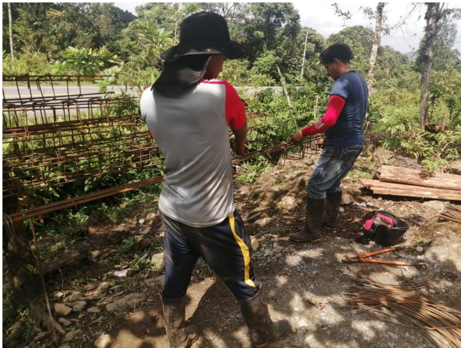
Ilustración 42, Figurado de acero de refuerzo
