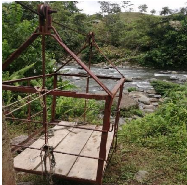
Ilustración 31, Estructura aérea para paso de materiales del beneficiario José Luis Domicó Resguardo Sever
