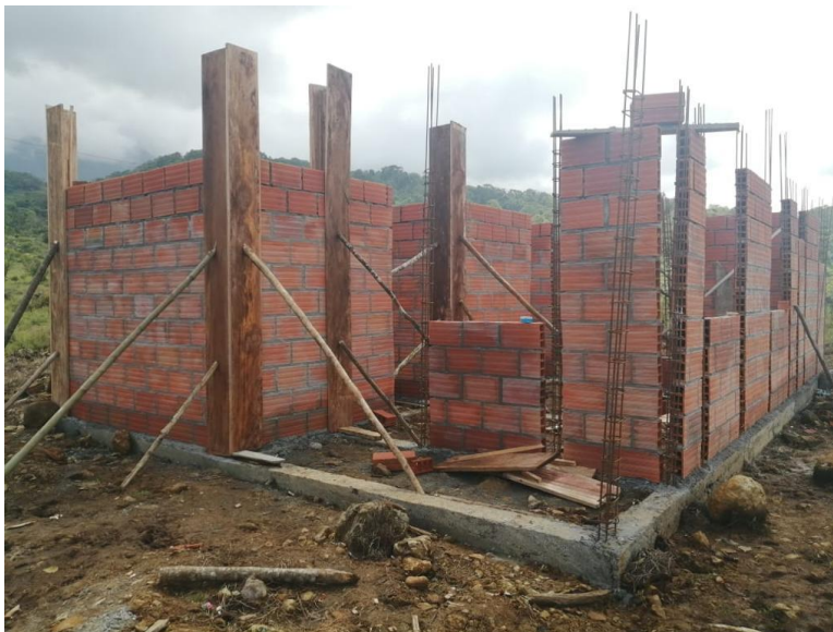
Ilustración 46, Fundición de columnas
