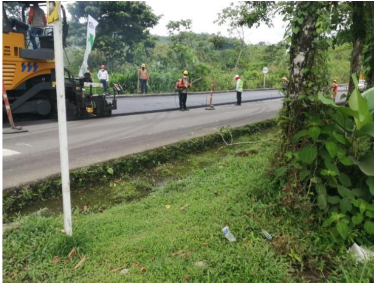
Ilustración 33, Intervención vial sector Resguardo Sever Dabeiba
