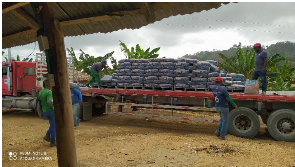
Ilustración 44, Llegada de material a obra
