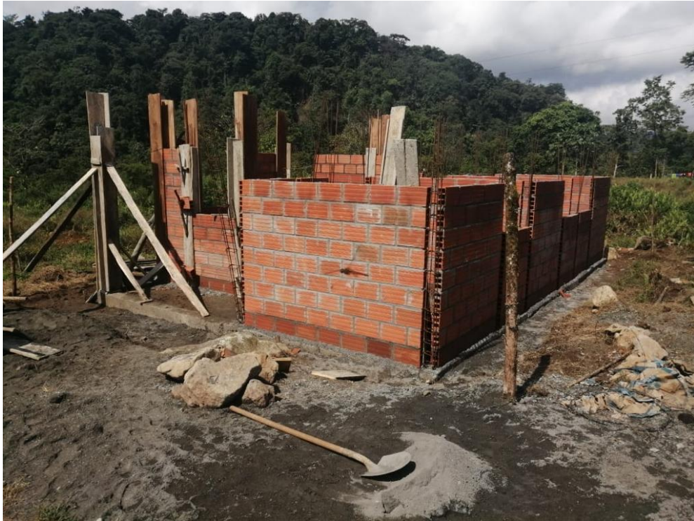
Ilustración 41, Armado de formaleta para columnas
