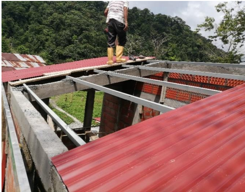
Ilustración 48, Instalación de la cubierta
