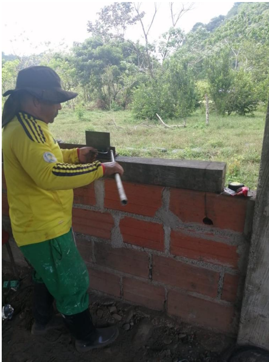
Ilustración 45, Colocación de muros en mampostería
