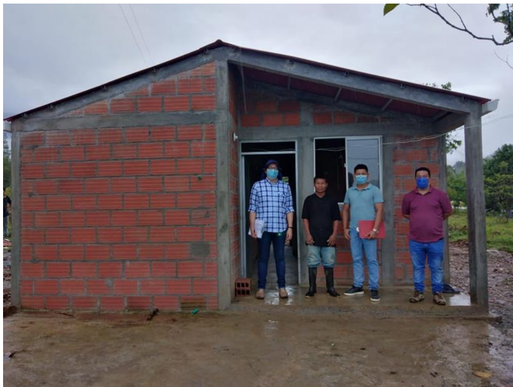
Ilustración 49, Entrega de la vivienda terminada
