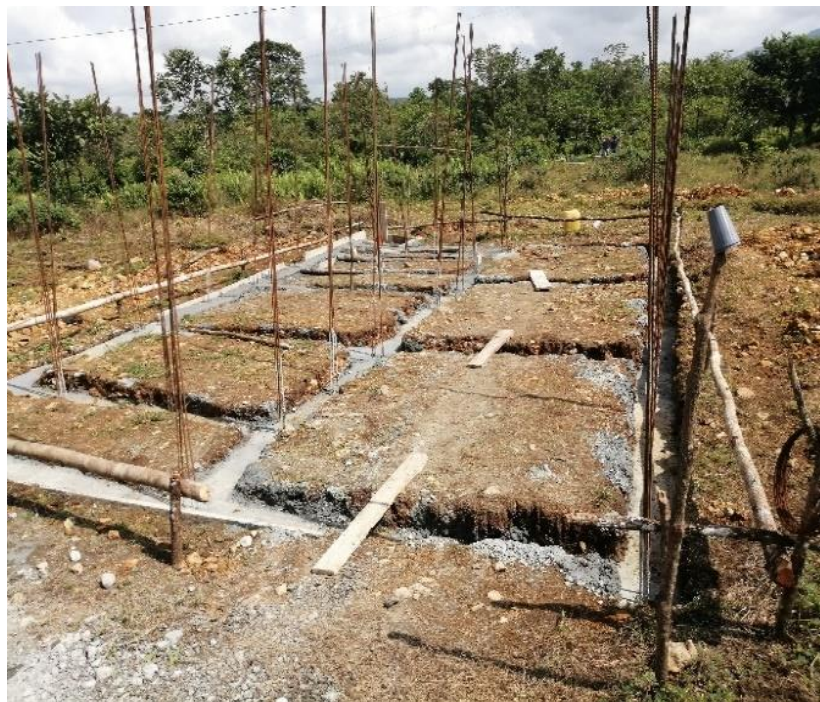
Ilustración 40, Fundición de vigas de cimentación
