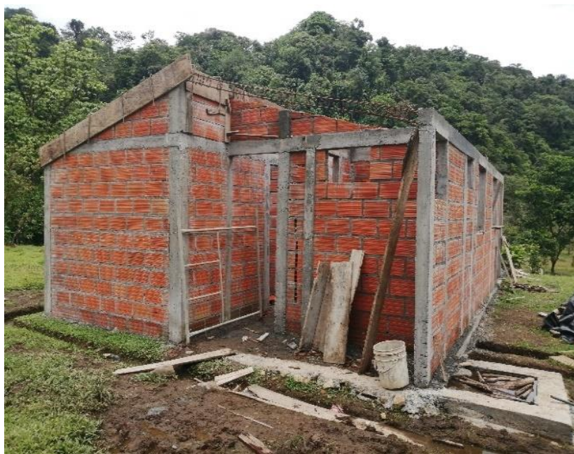
Ilustración 47, Vigas de amarre y columnas fundidas
