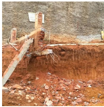
Foto 8: Parte del muro construido en días pasados por el Sr José.
