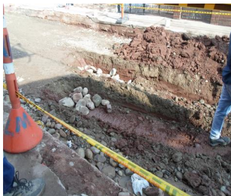
ENERO 8 DE 2016 - REPARACION DE 3 PEQUEÑOS FALLOS EN LA CALLE 8, BARRIO ALAMOS.
