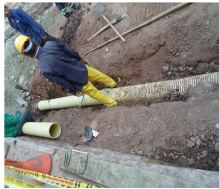
ENERO 8 DE 2016 - REPARACION DE TUBERIA DE ALCANTARILLADO PRINCIPAL DE LA CALLE 8, DEBIDO A FRACUTRAS ENCONTRADAS EN TUBERIA DE GRES EXISTENTE, SE REALIZÓ CAMBIO A TUBERIA PVC 8".
