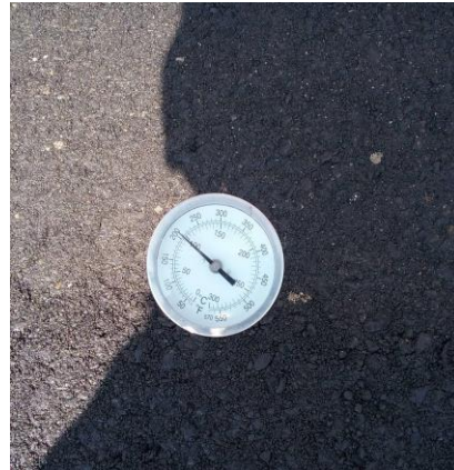
DICIEMBRE 30 DE 2015 - CONTROL TEMPERATURA DE MEZCLA ASFALTICA A APLICAR EN LA CARRERA 9, BARRIO ALAMOS.
