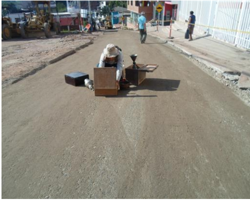
DICIEMBRE 29 DE 2015 - CONTROL DE MATERIALES, ENSAYO DENSIDADES A BASE GRANULAR COMPACTADA, CARRERA 9 BARRIO ALAMOS.
