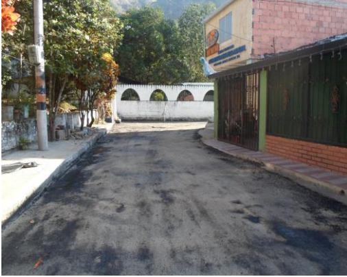
DICIEMBRE 28 DE 2015 - IMPRIMACION DE LA CALLE 1, BARRIO TURBAY.
