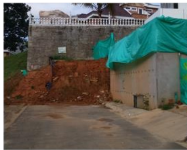
Foto 1: Estado inicial del terreno
