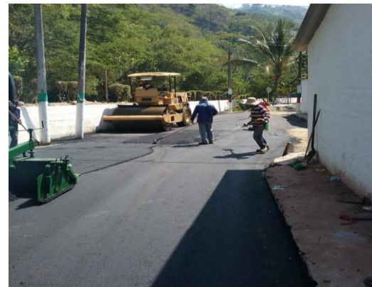
DICIEMBRE 29 DE 2015 - PAVIMENTACION CARRERA 2 Y CALLE 1, BARRIO TURBAY.
