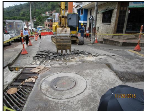
NOVIEMBRE 28 DE 2015 - DEMOLICIÓN PAVIEMNTO CARRERA 9 - K0+000.
