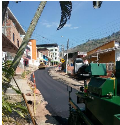
DICIEMBRE 30 DE 2015 - PAVIMENTACION CARRERA 9, BARRIO ALAMOS.
