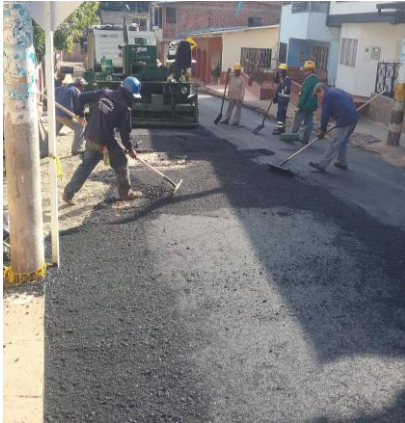
DICIEMBRE 30 DE 2015 - PAVIMENTACION CARRERA 9, BARRIO ALAMOS.
