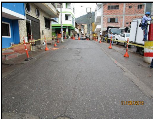
NOVIEMBRE 28 DE 2015 - UBICACIÓN SEÑALIZACIÓN PREVENTIVA EN LA CARRERA 9 - CALLE 8.
