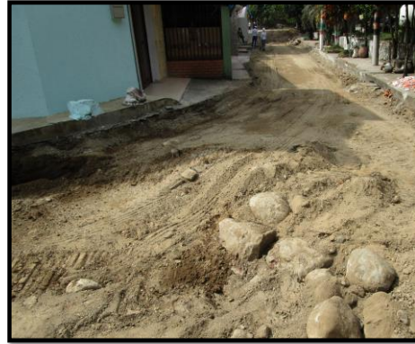
DICIEMBRE 08 DE 2015 - CULMINACIÓN DDEMOLICIÓN DE PAVIMENTO BARRIO TURBAY .
