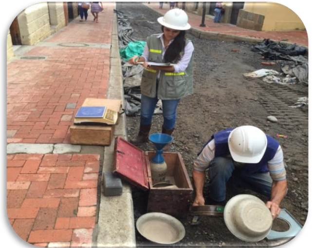
Figura 6: Toma densidades Material de relleno, Carrera 14 Socorro, Santander.
