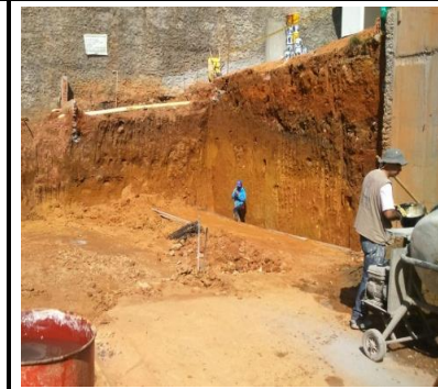
Foto 12: Iniciación Obras del Sr. Jose Suarez.
