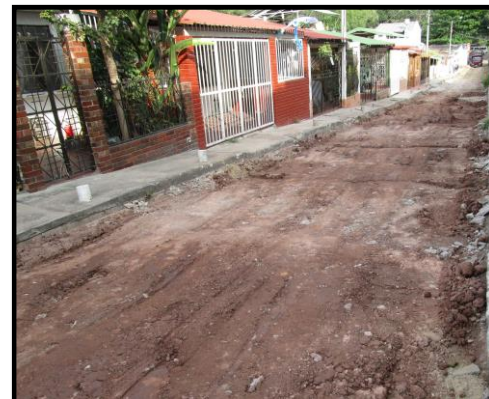
DICIEMBRE 12 DE 2015 - COMPACTACIÓN RELLENO DE ZANJAS DE TUBERÍAS EN CALLE 8, BARRIO ÁLAMOS
