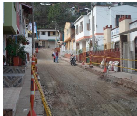
ENERO 8 DE 2016 - BASE GRANULAR COMPACTADA SIN SEREO EN EXTREMO SUPERIOR DE LA CALLE 8, BARRIO ALAMOS.
