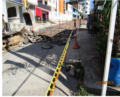
DICIEMBRE 01 DE 2015 - CONTINUACIÓN DEMOLICIÓN DE PAVIMENTO CARRERA 9, BARRIO ALAMOS - K0+050 HASTA K0+100.
