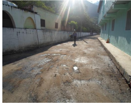
DICIEMBRE 28 DE 2015 - IMPRIMACION DE LA CARRERA 2, BARRIO TURBAY.
