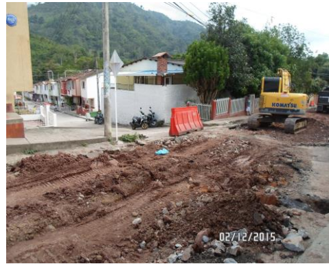
DICIEMBRE 02 DE 2015 - CULMINACIÓN DE DEMOLICIÓN DE PAVIMENTO CARRERA 9, BARRIO ÁLAMOS.
