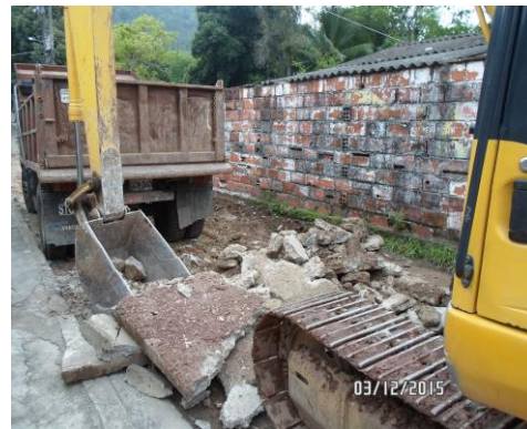
DICIEMBRE 3 DE 2015 - INICIO DEMOLICIÓN PAVIMENTO CALLE 8, BARRIO ÁLAMOS. K0+000 - K0+030.
