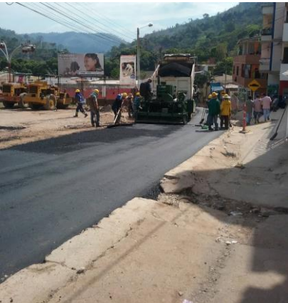
DICIEMBRE 30 DE 2015 - PAVIMENTACION CARRERA 9, BARRIO ALAMOS.
