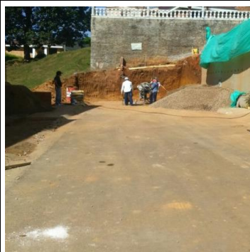
Foto 11: Lugar del Proyecto después de limpieza provisional del movimiento de tierra
