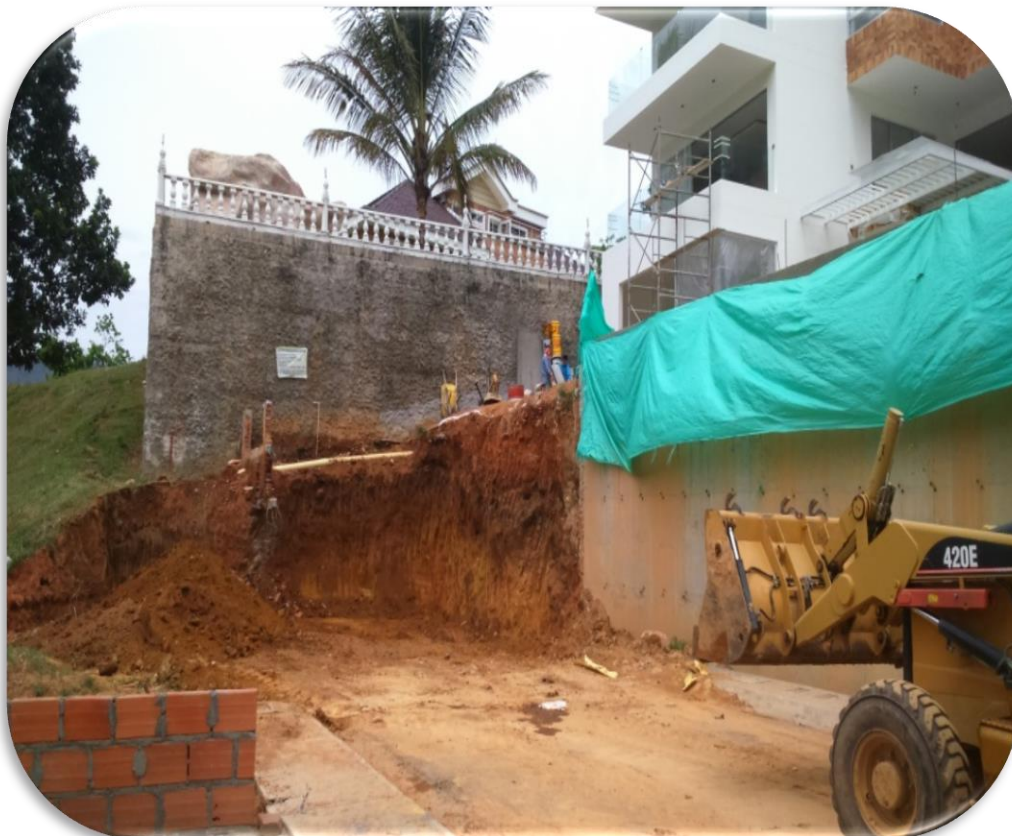
Figura 7: Zona de trabajo, Lotes 165 A y 163 A.
