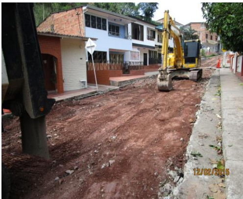
DICIEMBRE 03 DE 2015 - ARREGLO VÍA CARRERA 9, BARRIO ÁLAMOS. ACCESO TEMPORAL.
