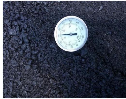
DICIEMBRE 29 DE 2015 - CONTROL DE TEMPERATURA DE MEZCLA DENSA EN CALIENTE (MDC- 19) 120 GRADOS CELCIUS
