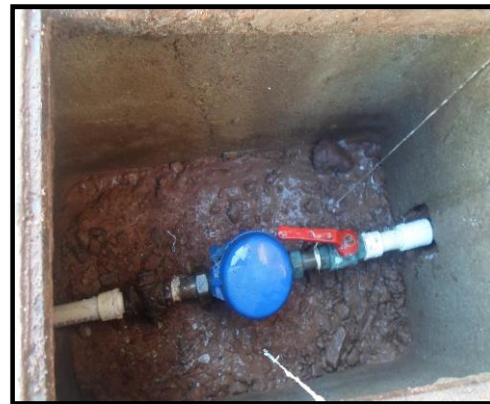
DICIEMBRE 10 DE 2015 - REPARACIÓN CONTADOR AFECTADO EN LA CALLE 8, BARIO ÁLAMOS.
