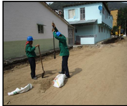
DICIEMBRE 12 DE 2015 - APIQUE SUBRASANTE PARA ENSAYOS DE PROCTOR MODIFICADO.
