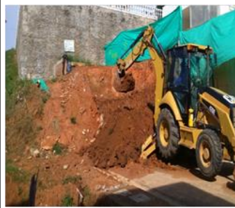
Foto 2: Inicio de Movimiento de Tierra.
