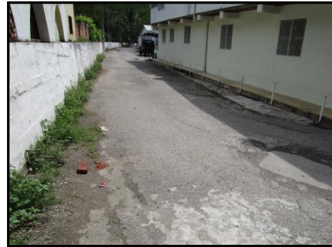
NOVIEMBRE 26 DE 2015 - VISITA DE RECONOCIMIENTO DE ZONAS DONDE SE EJECUTARÁ EL PROYECTO. BARRIO TURBAY - TRAMO 2
