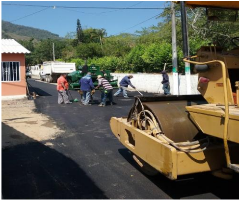
DICIEMBRE 29 DE 2015 - PAVIMENTACION CARRERA 2 Y CALLE 1, BARRIO TURBAY.
