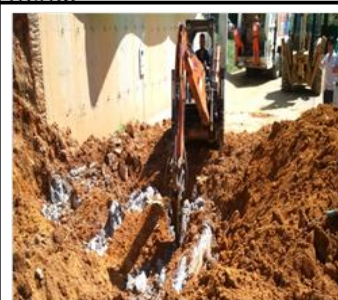
Foto 5: Demolición de Placa de concreto por el Minicargador.
