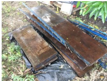
Ilustración 60: Formaleta preparada para pedestal
