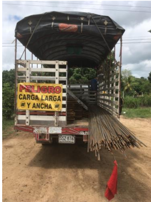
Ilustración 18: Llegada de material a la obra
