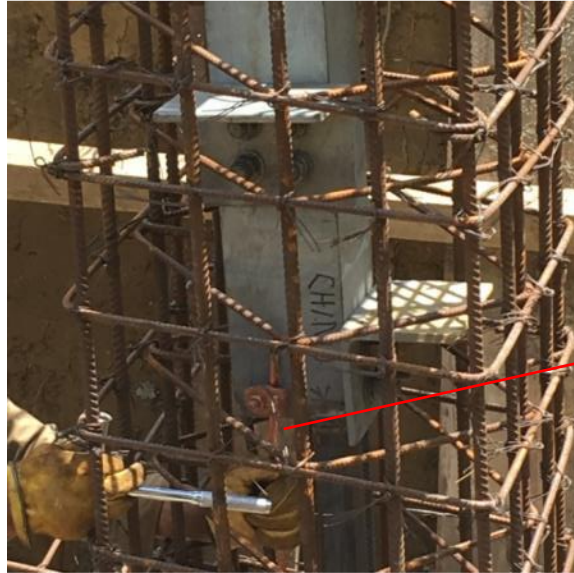
Ilustración 48: Conexión del sistema puesta tierra al Stub
