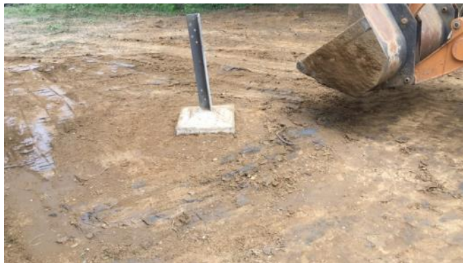
Ilustración 78: Acabado final del relleno y compactación.
