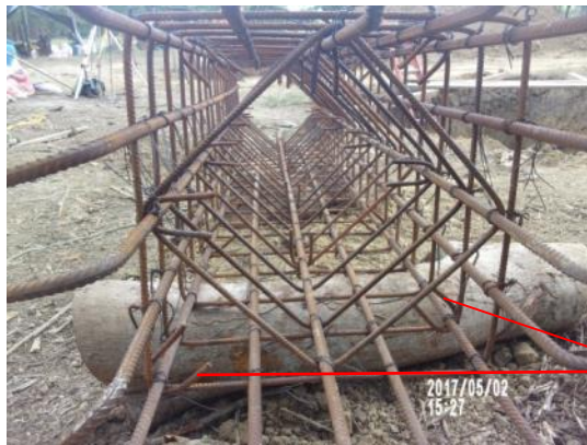
Ilustración 40: Detalle del castillo para el pedestal
