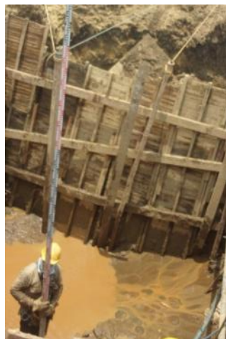
Ilustración 41: Nivelación de cota de fondo
