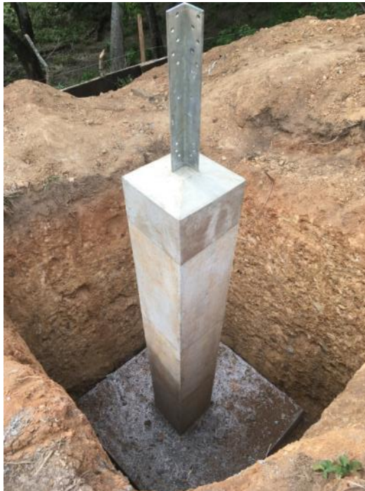
Ilustración 71: Cimentación tipo desencofrada.
