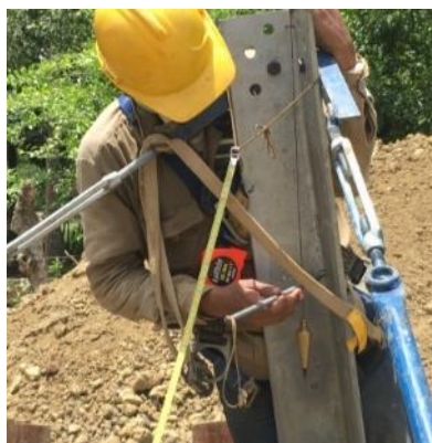
Ilustración 56: Pendiente del STUB
