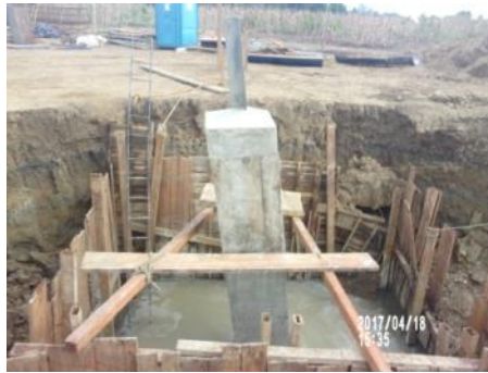
Ilustración 69: Pedestal desencofrado
