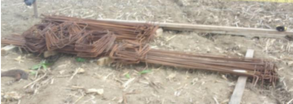
Ilustración 13: Acero de refuerzo
