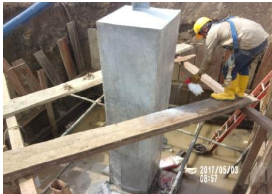
Ilustración 70: Aplicación de antisol
