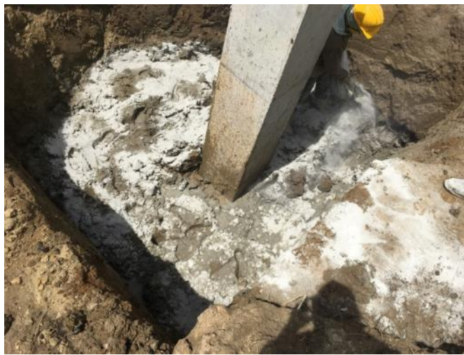
Ilustración 76: Estabilización de suelo con cemento.
