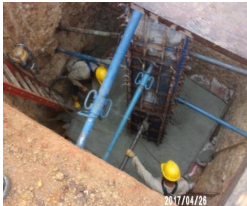
Ilustración 66: Vibrado de concreto
