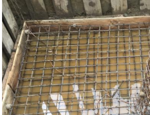
Ilustración 50: Sistema puesta a tierra anclado en la zapata
