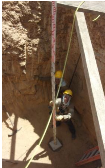
Ilustración 43: Chequeo de cota sobre panela
