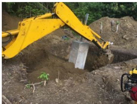
Ilustración 72: Relleno de cimentación con retro cargadora.
