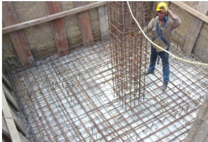
Ilustración 47: Acero de refuerzo situado en la cimentación
