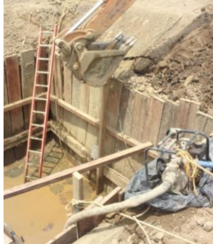
Ilustración 38: Excavación con entibado
