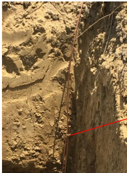
Ilustración 49: Conexión al sistema puesta tierra a la jabalina
