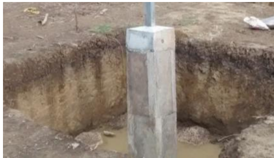
Ilustración 74: Cimentación sumergida.
