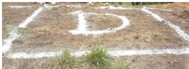
Ilustración 37: Localización y replanteo
