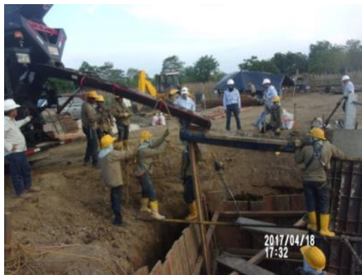
Ilustración 67: Fundida de pedestal
