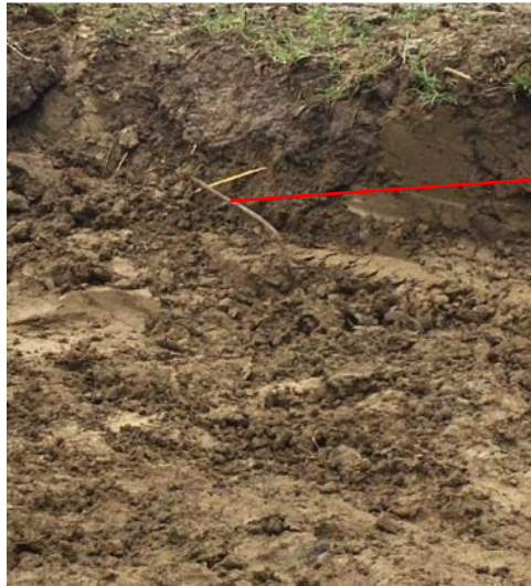
Ilustración 77: Cable puesta a tierra expuesto en el relleno.
