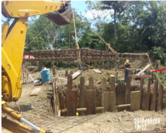
Ilustración 46: Colocación de parrilla con retroexcavadora
