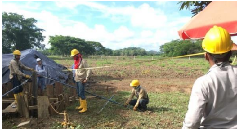
Ilustración 52: Distancia a cabeza STUB
