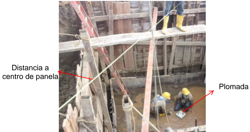
Ilustración 42: Nivelación de panela
