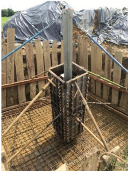
Ilustración 62: Pata formaletada para fundida
