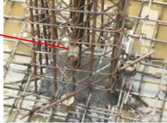
Ilustración 59: Soporte para la formaleta del pedestal
