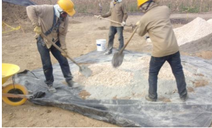
Ilustración 44: Preparación de solado
