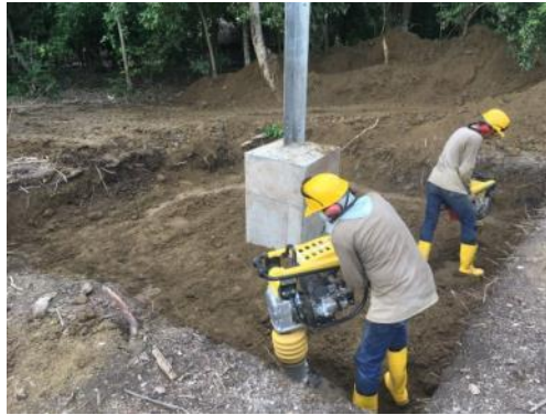
Ilustración 73: Compactación de capa con compactador o canguro
