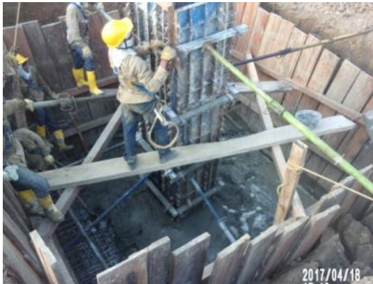
Ilustración 65: Fundida de zapata con canaleta metálica
