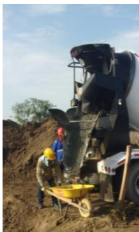
Ilustración 63: Material para prueba de concreto
