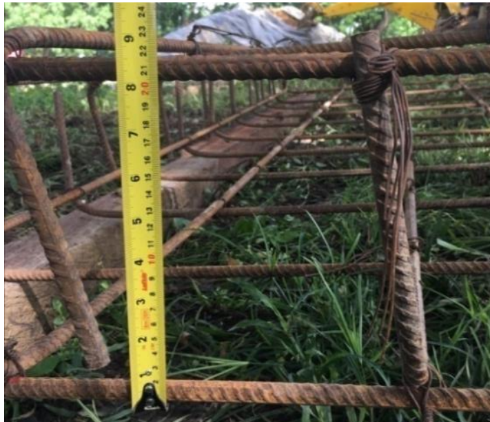
Ilustración 21: Espesor de parrilla para zapata
