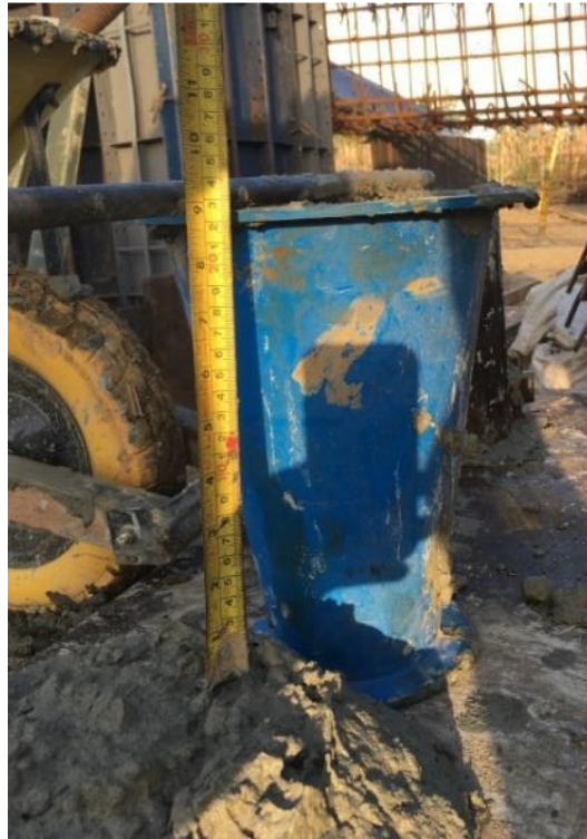
Ilustración 23: Asentamiento del concreto
