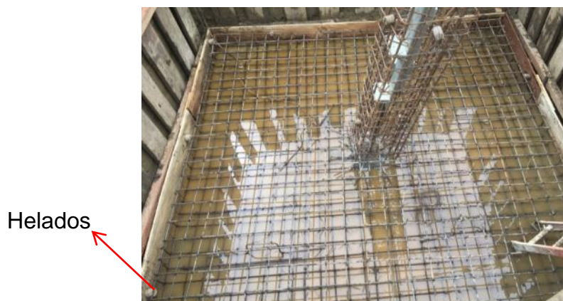
Ilustración 58: Formaleta tipo de Zapata
