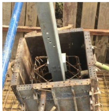
Ilustración 61: Pedestal tipo formaleteado
