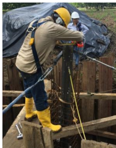
Ilustración 54: Viro del STUB
