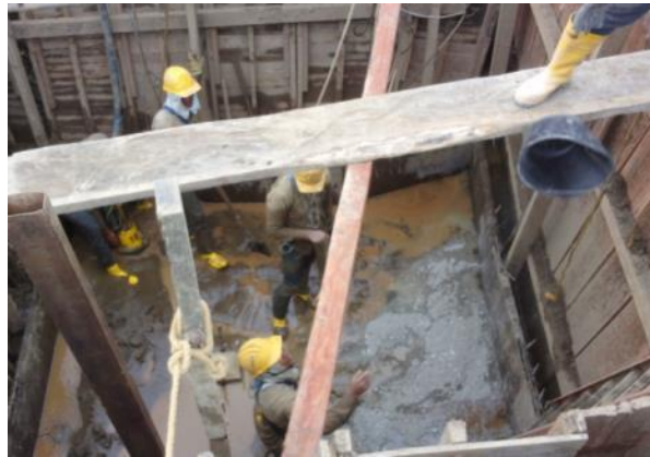
Ilustración 45: Colocación de solado seco a cimentación sumergida
