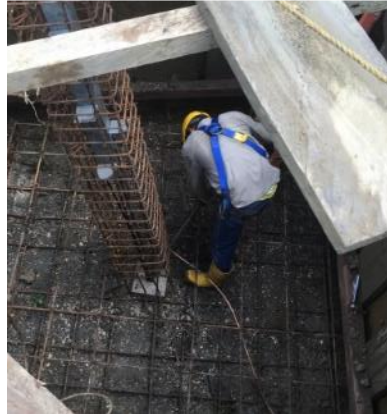
Ilustración 57: Arreglo de la verticalidad y pendiente del STUB
