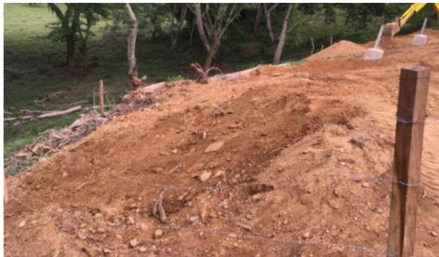
Ilustración 30: Encerramiento con alambre de púas
