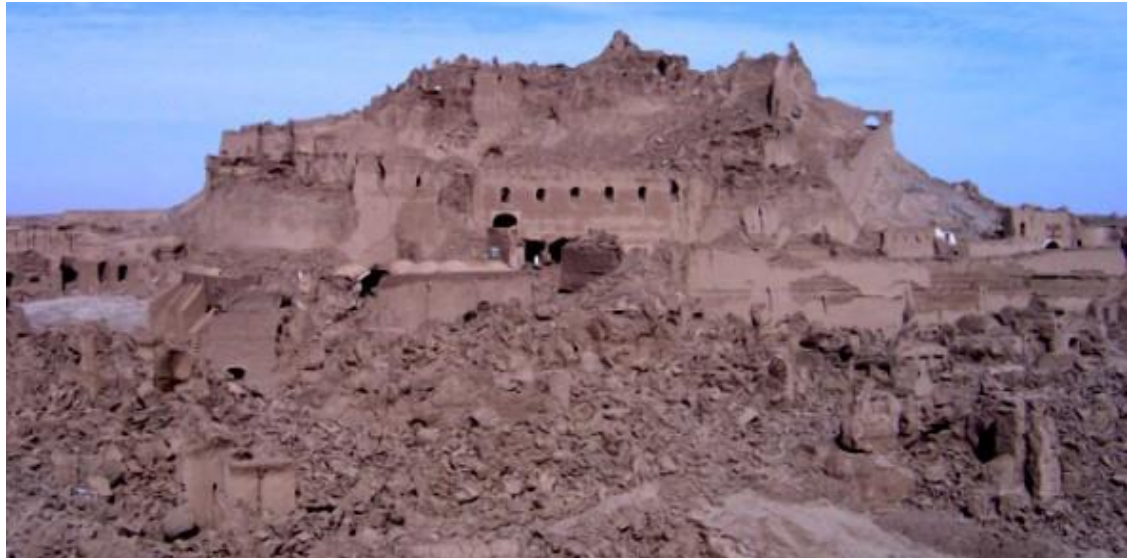
Figura 25. Doncel, José A. Bam después del sismo de 2003 (2011, 16 de noviembre). Construir frente a terremotos: la arquitectura sismo-resistente.
