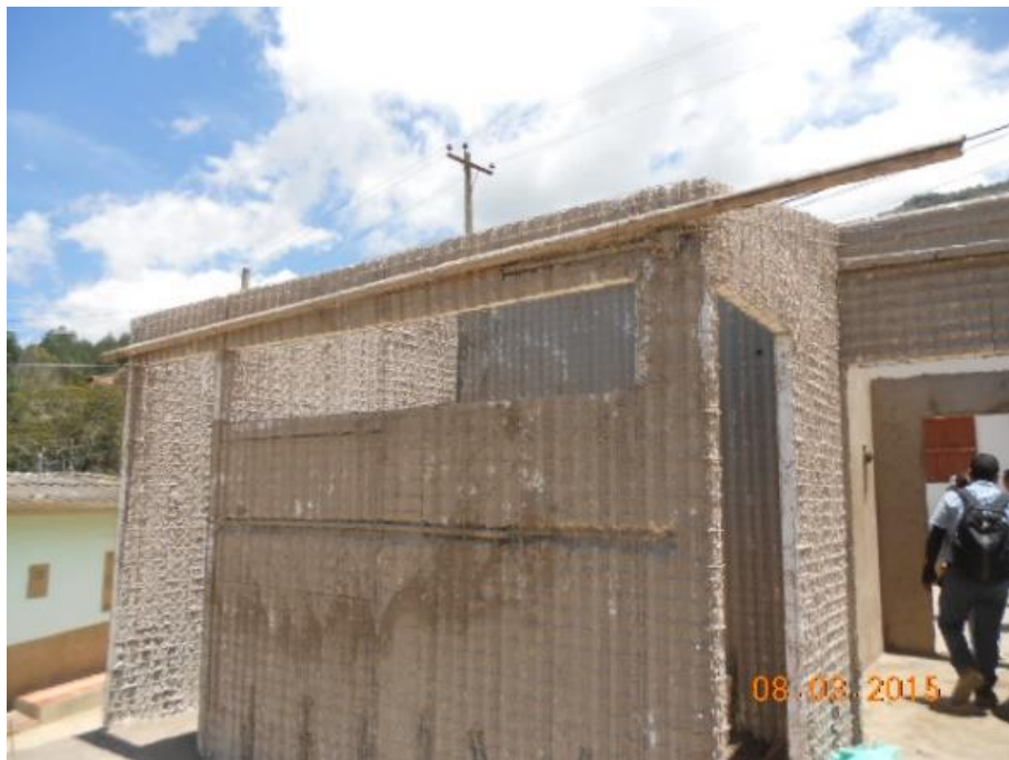
Figura 35. Alineación de muros y aplicación primera capa de mortero
