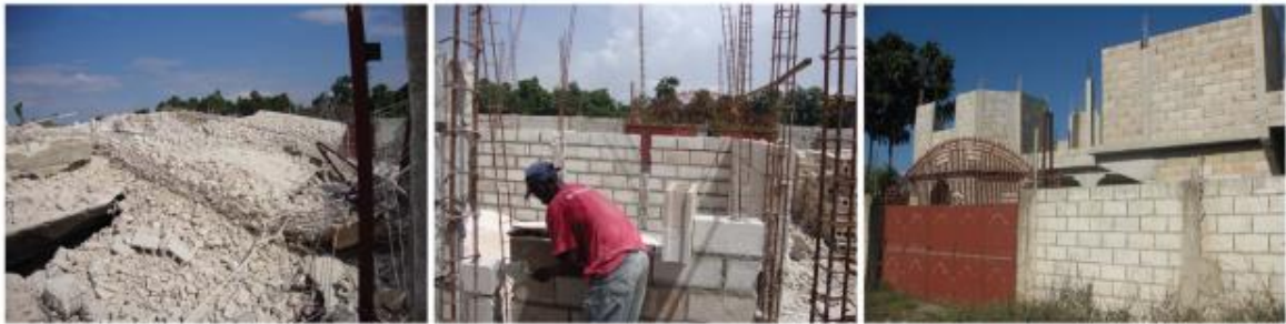
Figura 29. A) Viviendas colapsadas B) Proceso de reconstrucción, tras educación a beneficiarios acerca de la implementación del forjado. C) Viviendas en construcción de segundo piso. (2012, 1 de Octubre).
