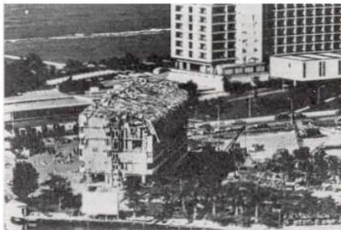
Figura 15. Colapso de los niveles superiores de un edificio de 11 pisos
