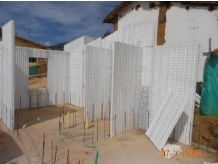
Figura 33. Levantamiento de paneles
