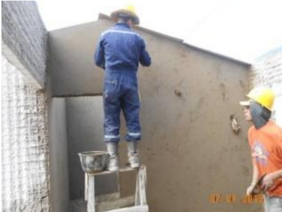
Figura 36. Aplicación segunda capa de mortero y frisado
