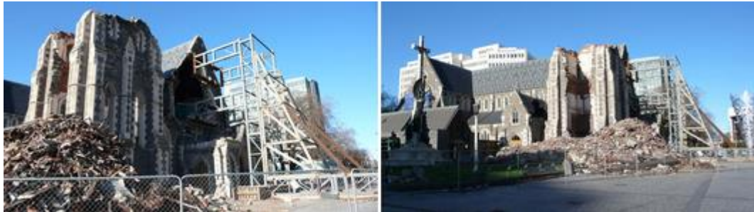
Figura 21. Catedral después del sismo (2014, 1 de febrero).
