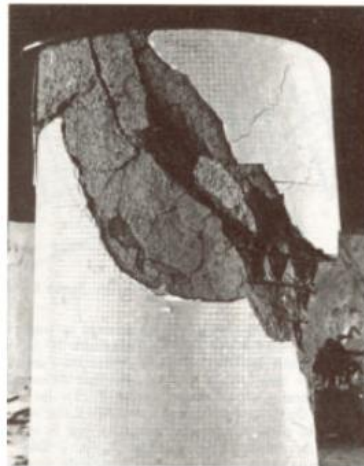
Figura 8. Falla por tensión diagonal en columna
