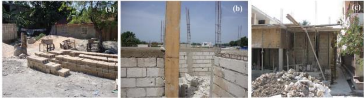
Figura 30. A) Unidades en mampostería de hormigón (CMU) B) Construcción de muros en CMU, con columnas en manera. C) Encofrado de madera para fundición con losa de hormigón. (2012, 1 de Octubre).
