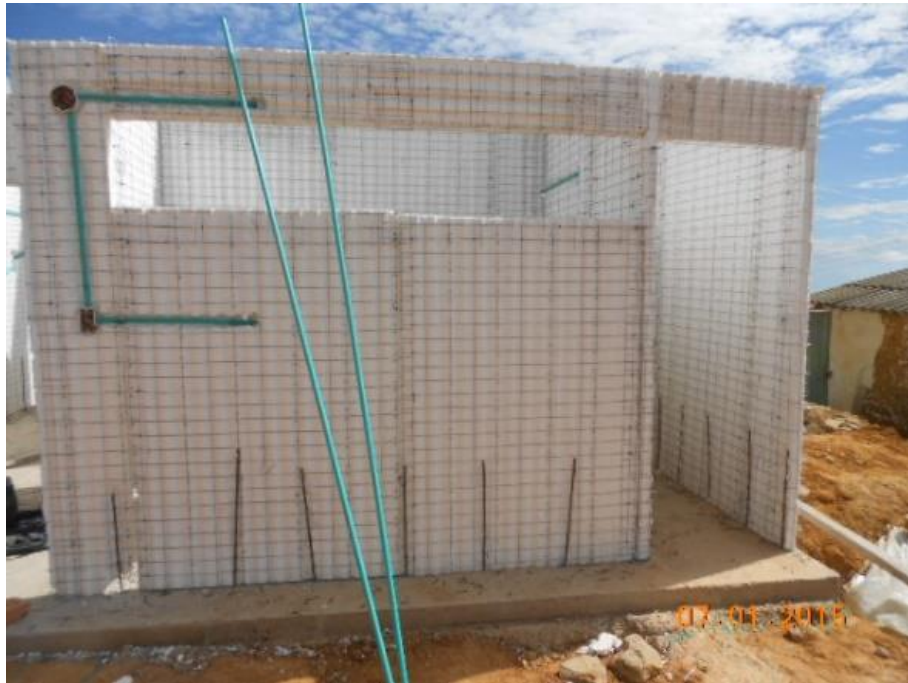
Figura 34. Instalación tuberías eléctricas
