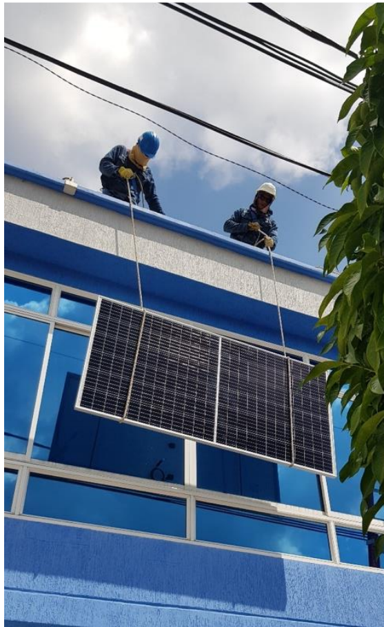
Imagen 17. Izaje de los paneles
