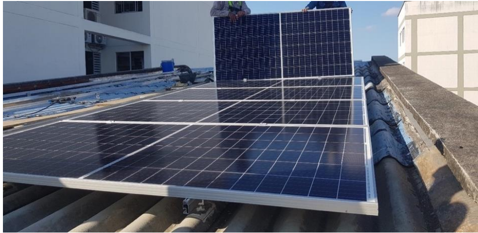
Imagen 18. Instalación de los paneles solares
