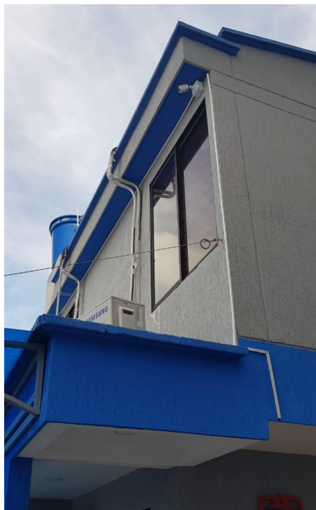
Imagen 3. Placa de acceso al techo.
