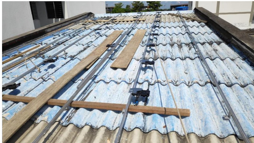
Imagen 11. Instalación de los micro inversores
