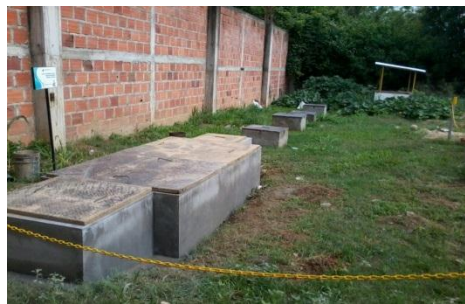
Inspección PTAR Lavadero
