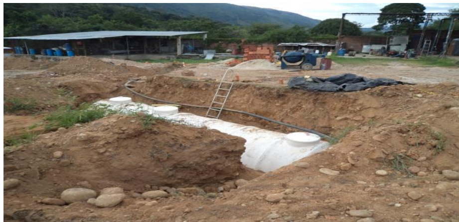
Imagen 19. Instalación sistema prefabricado compacto.
