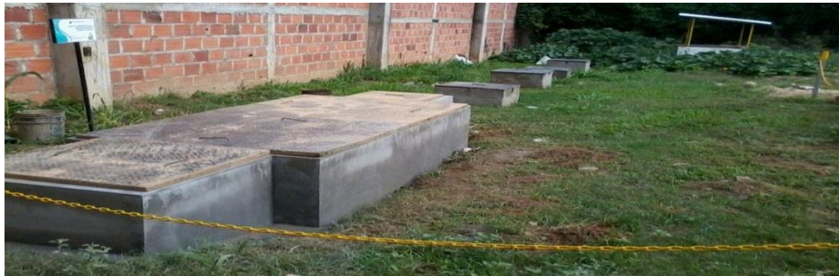
Imagen 21. Sistema PTAR Lavadero Automotriz
