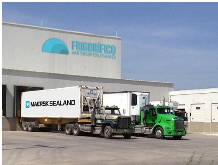
Figura 8 Área de carga y descarga de producto
