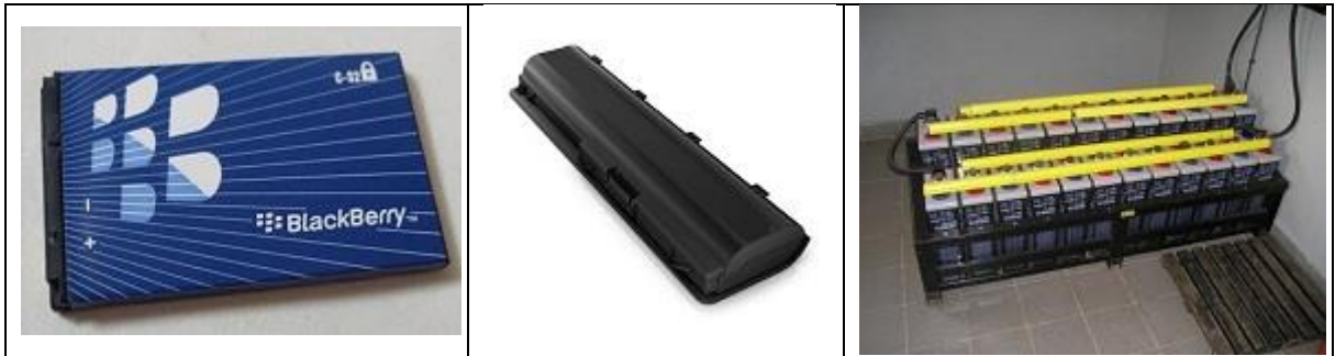
Figura 9. Batería para celular y para PC; UPS de un centro de cómputo
