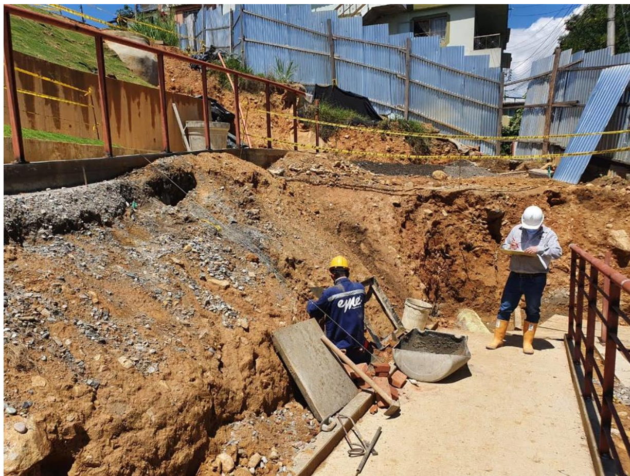
Figura 13. Recorrido de obra
