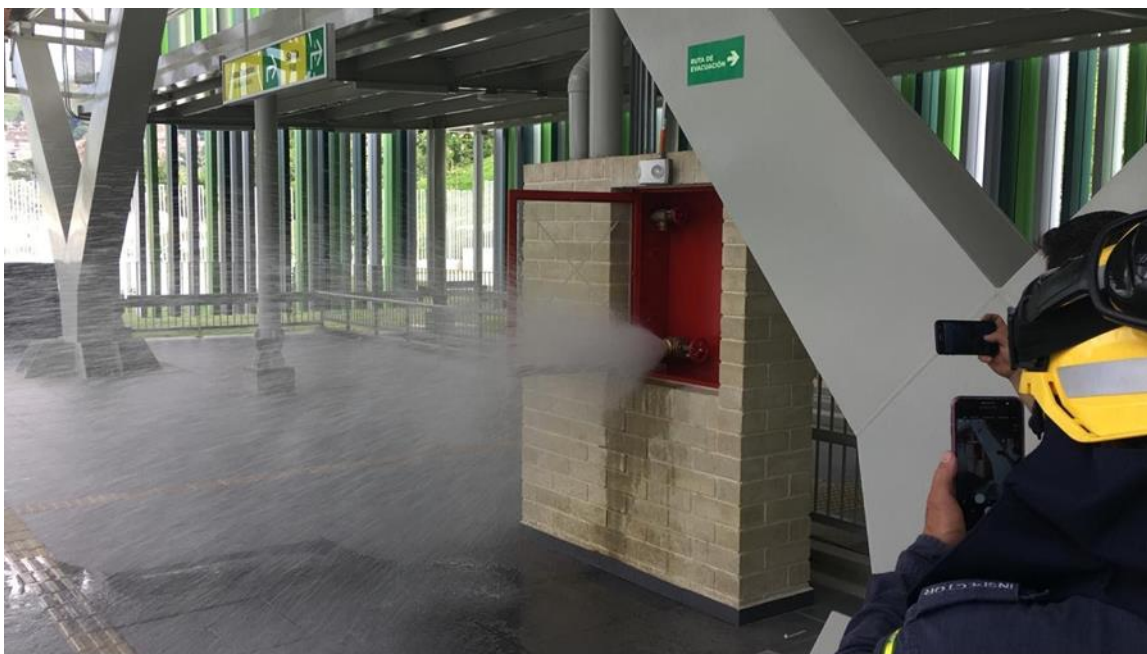
Figura 34. Prueba del sistema contraincendios
