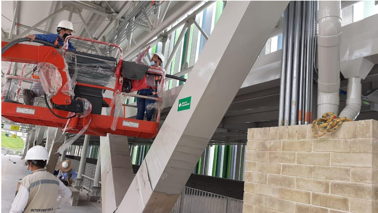
Figura 35. Prueba de estanqueidad canales plataformas
