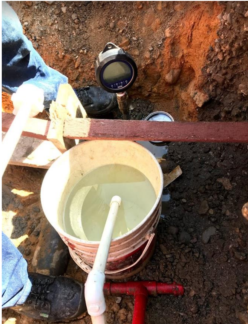
Figura 31. Presurización de red hidráulica
