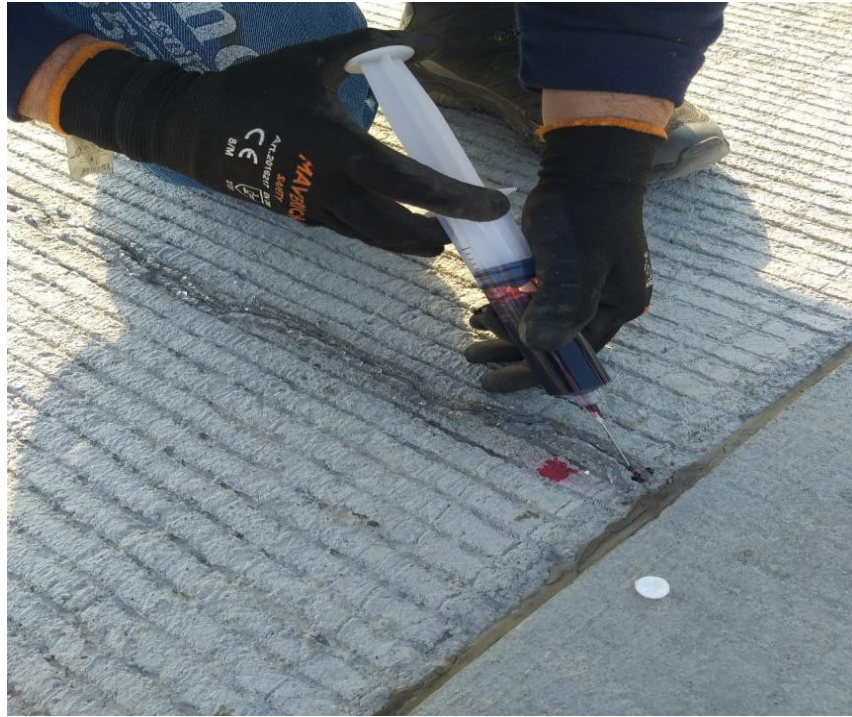
Figura 42. Reparación de fisura MR 45
