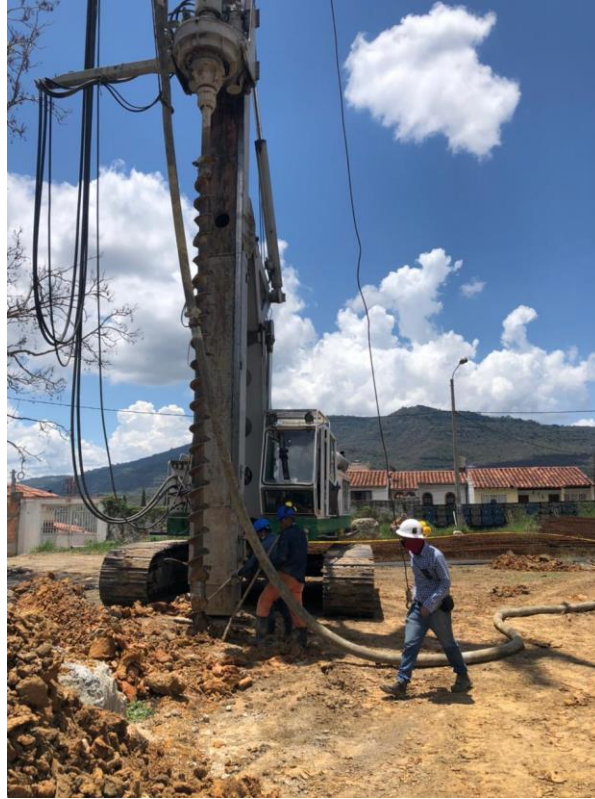
Figura 11. Barrenado de pilote.
