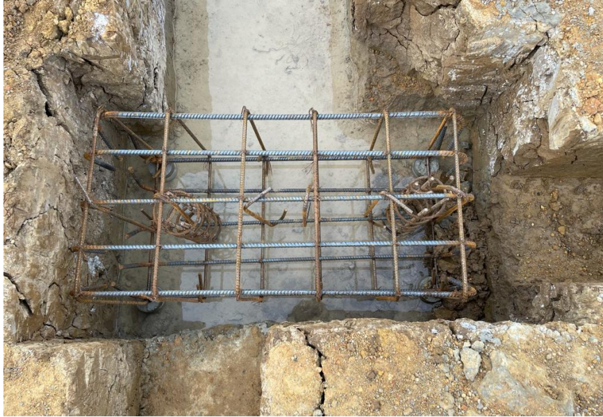
Figura 29. Verificación acero cabezal CB-3
