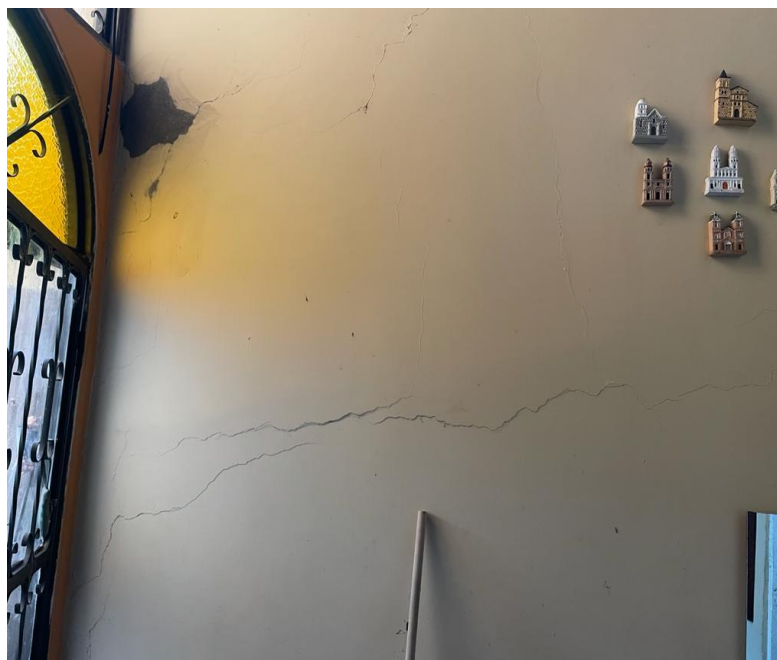
Figura 6. Revisión del estado viviendas vecinas al proyecto.
