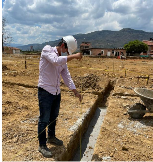
Figura 20. Revisión de niveles.
