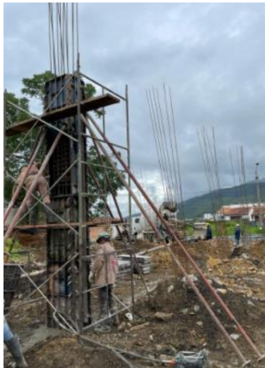
Figura 36. Fundida de columna en dos tramos.
