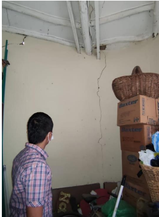
Figura 7. Revisión del estado viviendas vecinas al proyecto.
