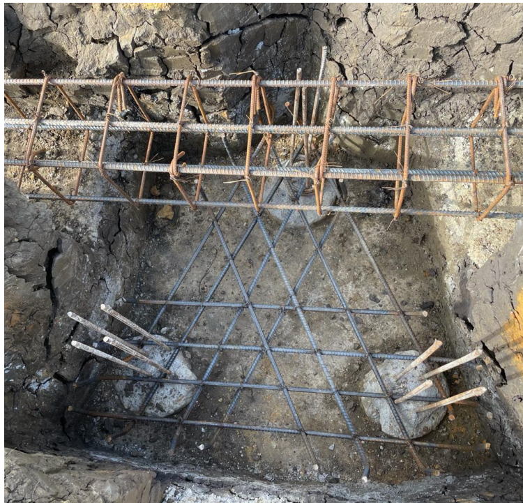
Figura 30. Verificación parrilla inferior cabezal x3.
