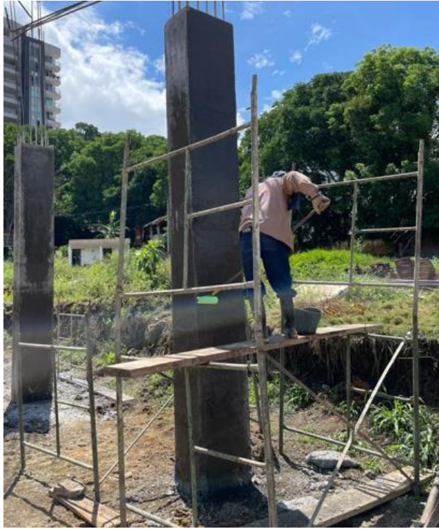
Figura 38. Aplicado de curaseal a las columnas.
