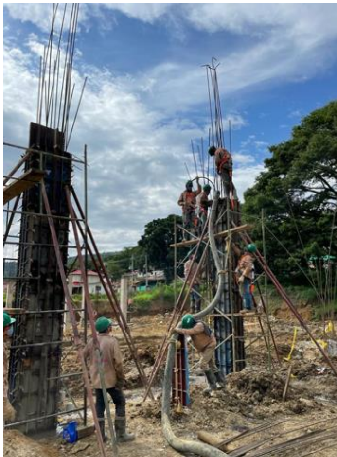
Figura 37. Fundida columnas.
