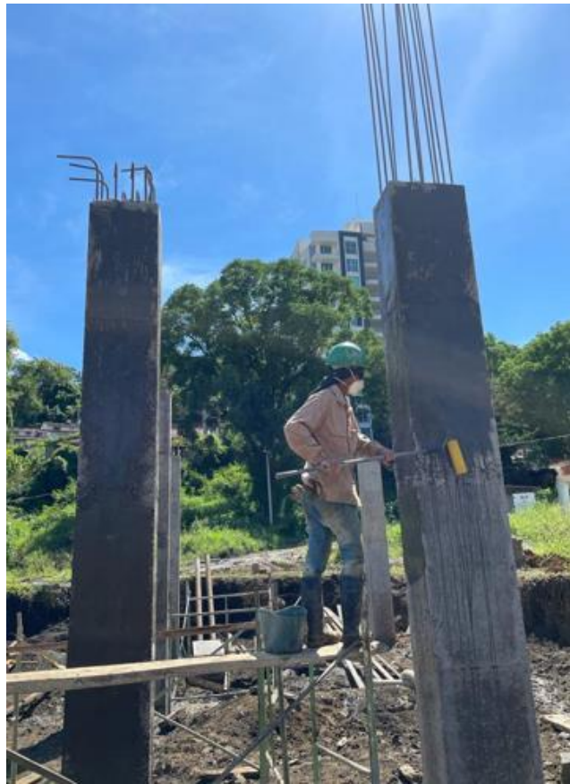
Figura 39. Aplicado curaseal a columnas.
