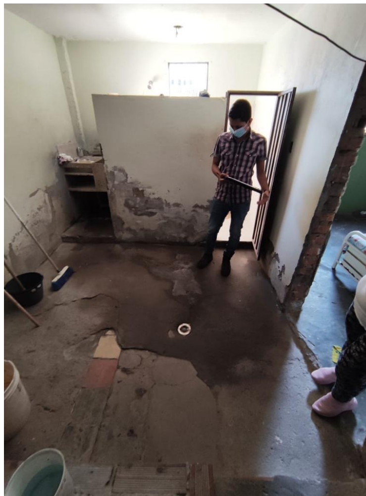
Figura 9. Revisión del estado viviendas vecinas al proyecto.
