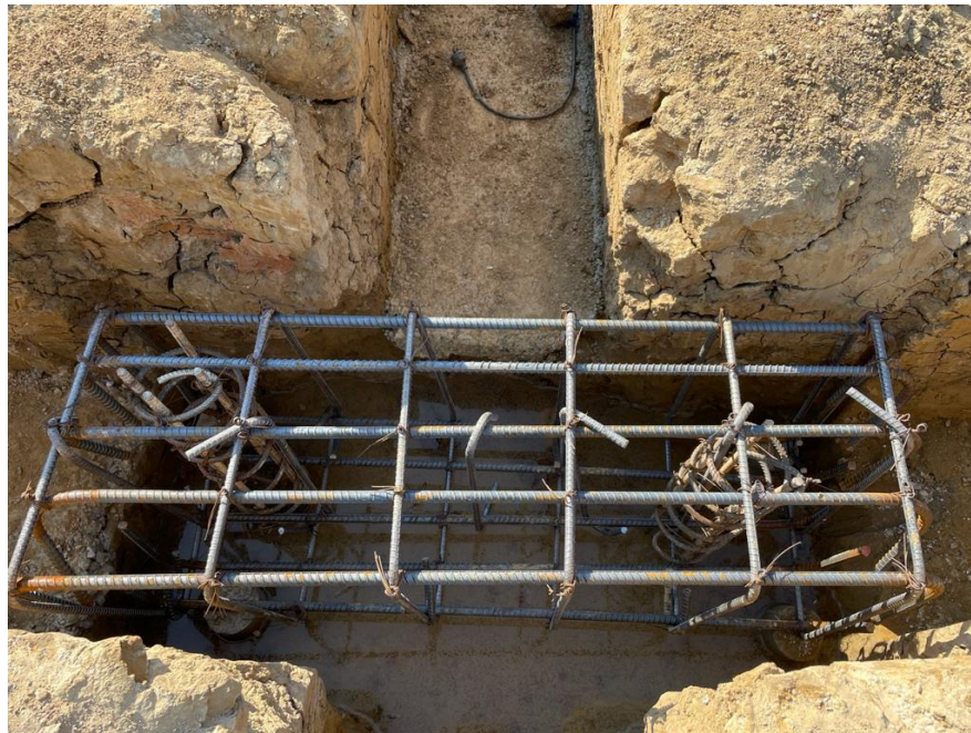
Figura 28. Verificación acero cabezal CB-1
