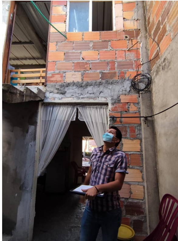
Figura 8. Revisión del estado viviendas vecinas al proyecto.
