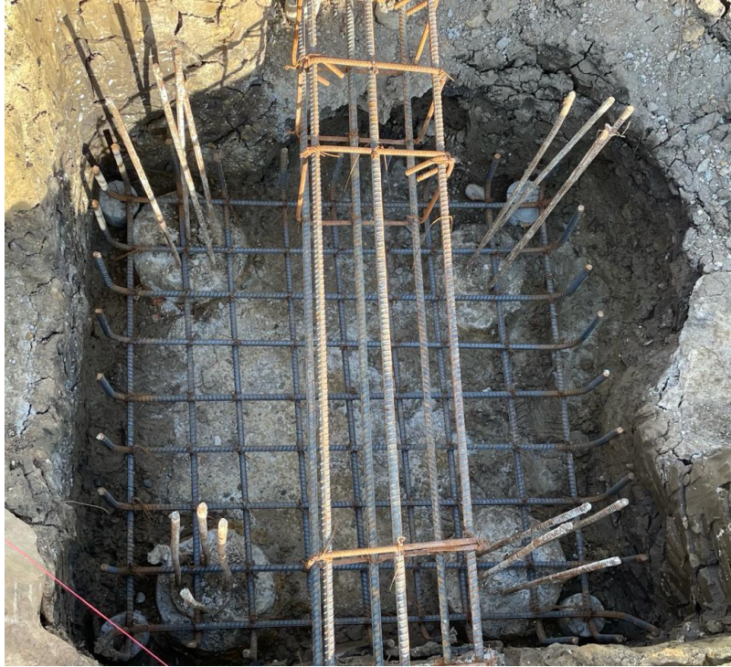
Figura 31. Acero cabezal x4.
