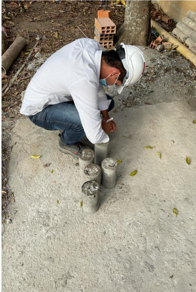
Figura 15. Marcación de cilindros de concreto.
