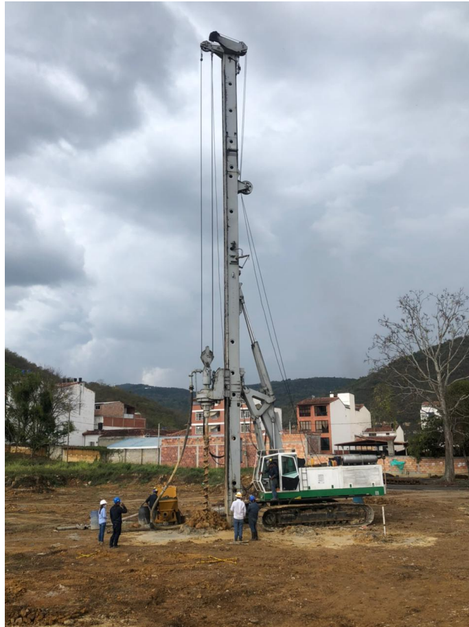
Figura 10. Barrenado de pilote.
