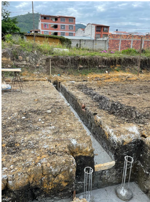
Figura 21. Solados en vigas de amarre y cabezales.
