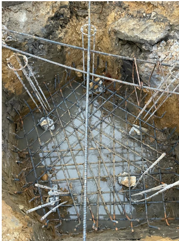
Figura 32. Acero parrilla inferior cabezal x5.
