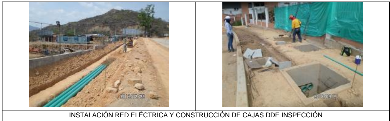
Fotografía 4. Evidencia del seguimiento en la Instalación de redes eléctricas.
