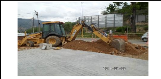
FOTO 1. Conformación de terraplen con material seleccionado
