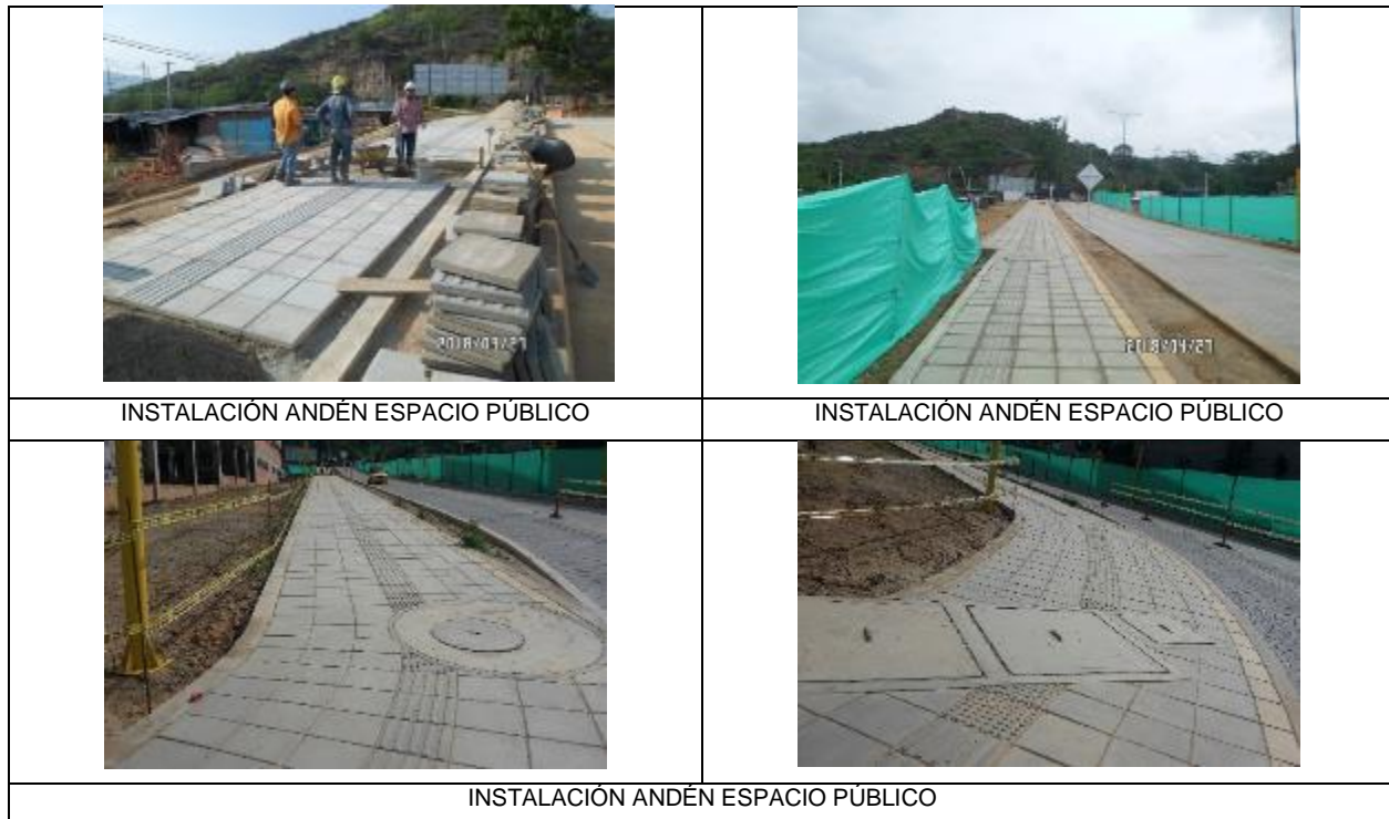
Fotografía 2. Evidencia del seguimiento en la Instalación del urbanismo. Fuente: Autor.
