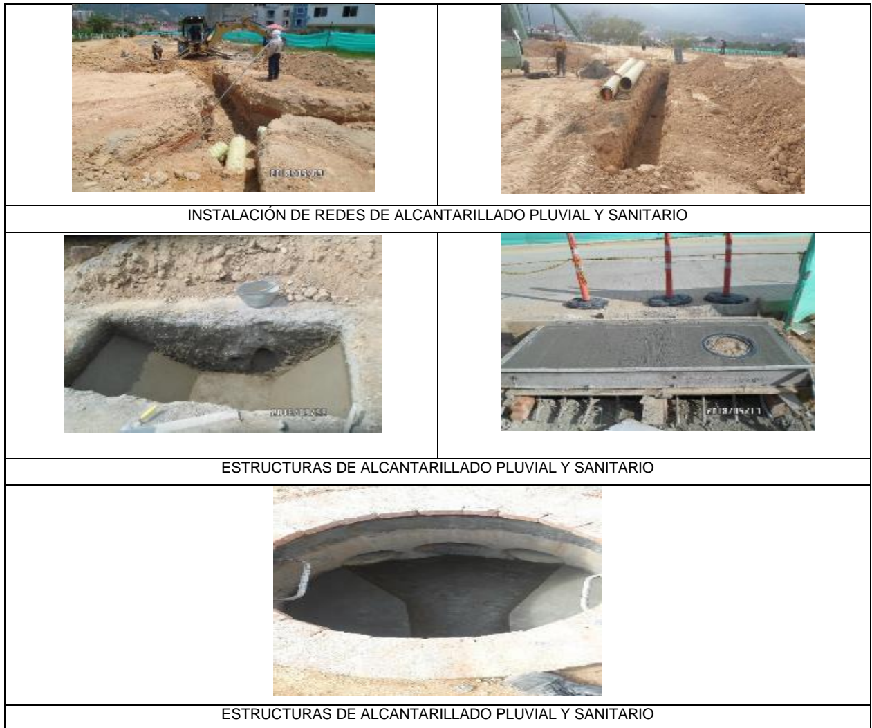
Fotografía 3. Evidencia del seguimiento en la Instalación de Redes de Alcantarillado Pluvial y Sanitario. Fuente: Autor.
