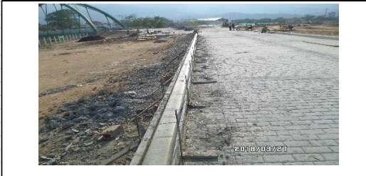
FOTO 3. Fundición de bordillos en el sector 3
