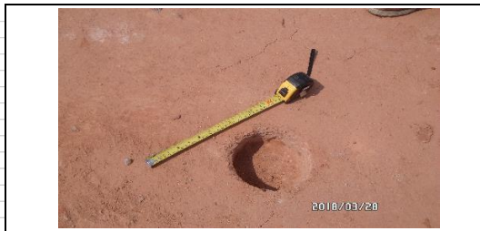
FOTO 6. Toma de densidades mediante el ensayo cono de arena
