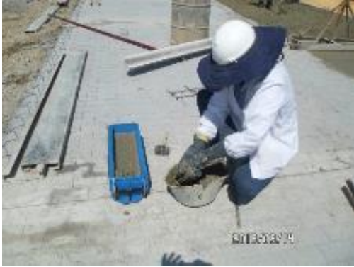
TOMA DE MUESTRAS DE CONCRETO PARA ENSAYOS DE RESISTENCIA DE VIGA A FLEXIÓN y MÓDULO DE ROTURA
