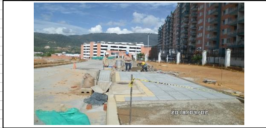
FOTO 2. Instalación anden espacio público tipo loseta de 40x40
