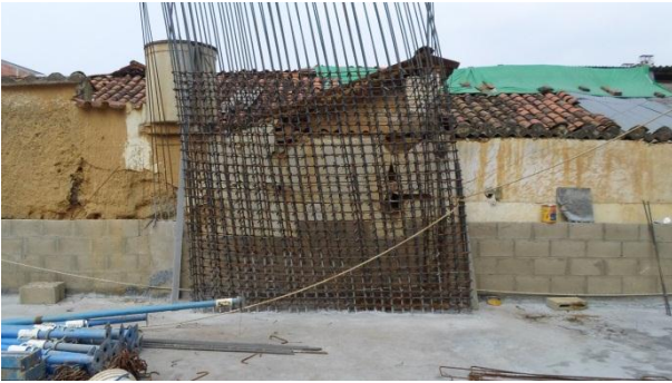
Ilustración 2: Pantalla P20 armada correctamente nivel N+1.84 m. Fuente: Peralta Ingeniería S.A.S.
