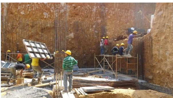
Ilustración 3: Trabajos en el armado de muro de contención. Fuente: Peralta Ingeniería S.A.S.
