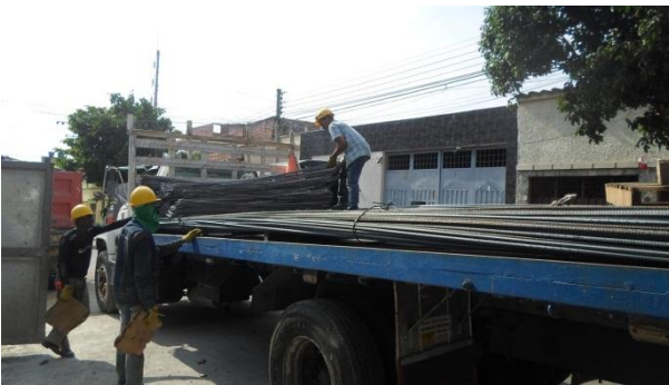
Ilustración 1: Descargue de pedido acero de refuerzo. Fuente: Peralta Ingeniería S.A.S.
