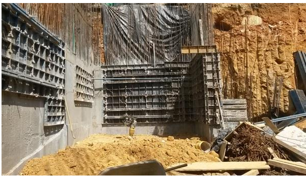
Ilustración 1: Pantalla P4 en proceso de fraguado. Fuente: Peralta Ingeniería S.A.S.
