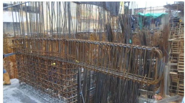
Ilustración 2: Armado de viga VP10-24 de manera correcta. Fuente: Peralta Ingeniería S.A.S.
