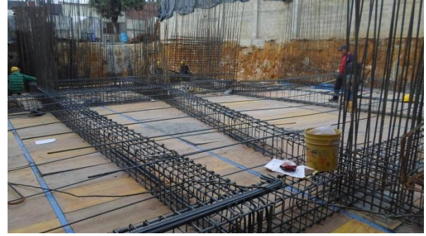
Ilustración 2: Armado de elementos sótano 1.2 nivel N-1.20 m. Fuente: Peralta Ingeniería S.A.S.
