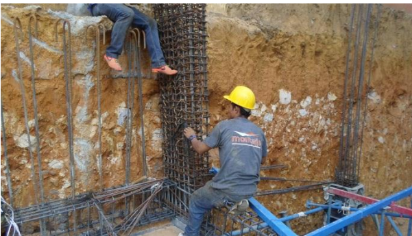
Ilustración 3: Armado columna C-A.5 sótano 1.2 nivel N-1.20 m. Fuente: Peralta Ingeniería S.A.S.
