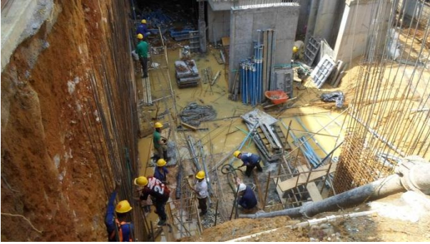
Ilustración 7: Bombeo de áreas inundadas por precipitaciones en los días anteriores. Fuente: Peralta Ingeniería S.A.S.
