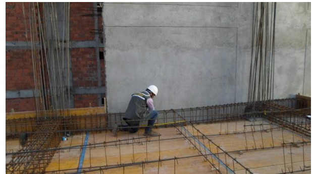
Ilustración 2: Armado de vigas piso 3.2 nivel N+7.73 m. Fuente: Peralta Ingeniería S.A.S.
