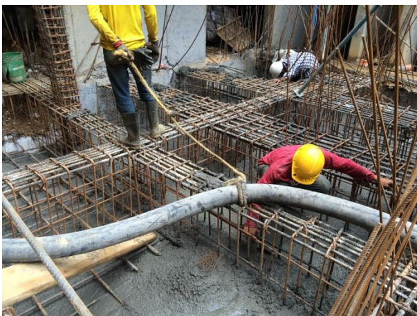
Ilustración 5: Fundida y vibración cimentación N-6.90 m. Fuente: Peralta Ingeniería S.A.S.
