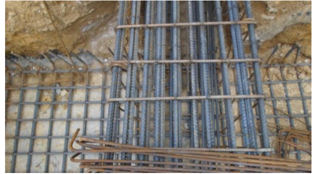
Ilustración 2: Refuerzo longitudinal superior viga V00-41. Fuente: Peralta Ingeniería S.A.S.
