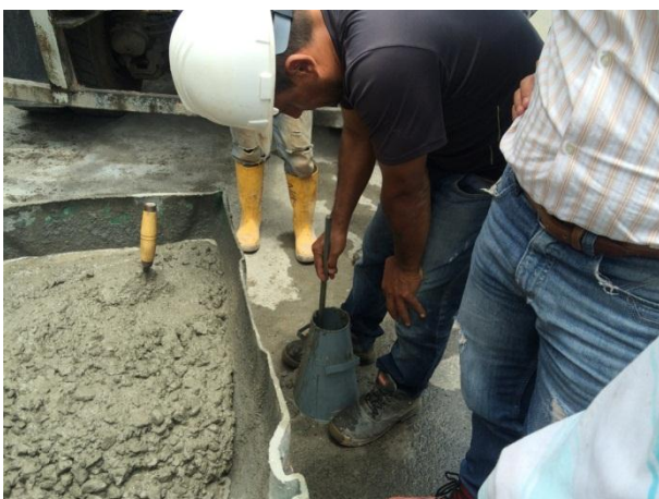
Ilustración 4: Ensayo de asentamiento para concreto de la placa de 3000 psi. Fuente: Peralta Ingeniería S.A.S.
