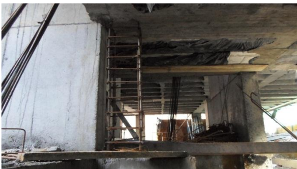
Ilustración 5: Armado de columneta que apoya la viga VP20-24 nivel N+3.48 m con el entrepiso del nivel N+1.84 m. Fuente: Peralta Ingeniería S.A.S.
