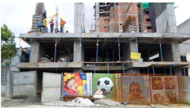
Ilustración 1: Avance de la obra a la fecha (12/05/2016). Fuente: Peralta Ingeniería S.A.S.
