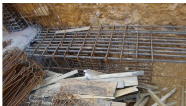
Ilustración 4: Trabajos en el armado viga de cimentación. Fuente: Peralta Ingeniería S.A.S.
