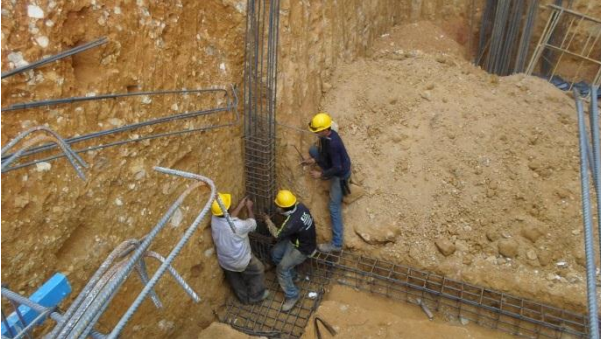
Ilustración 1: Armado de columna C-A.6 cuarto de máquinas N-4.05 m. Fuente: Peralta Ingeniería S.A.S.
