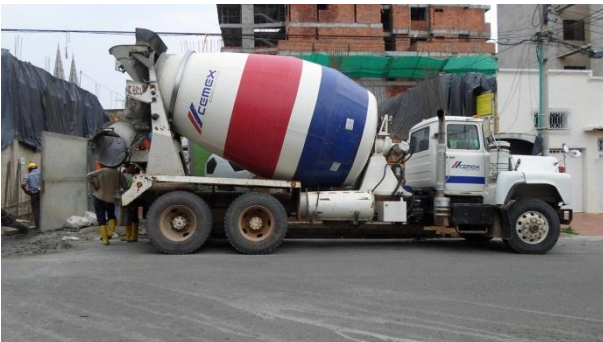
Ilustración 4: Cambio de proveedor de concreto a Cemex S.A. Fuente: Peralta Ingeniería S.A.S.
