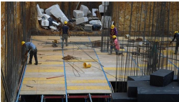
Ilustración 1: Armado de vigas y placa de entrepiso sótano 2 N-4.05m. Fuente: Peralta Ingeniería S.A.S.
