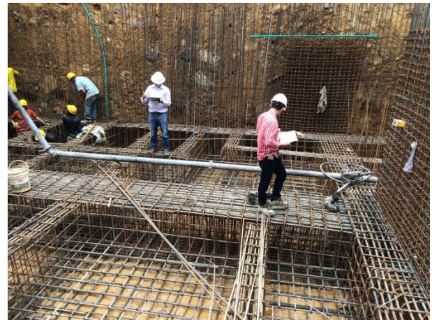
Ilustración 4: Revisión de vigas de cimentación N-6.90 m. Fuente: Peralta Ingeniería S.A.S.
