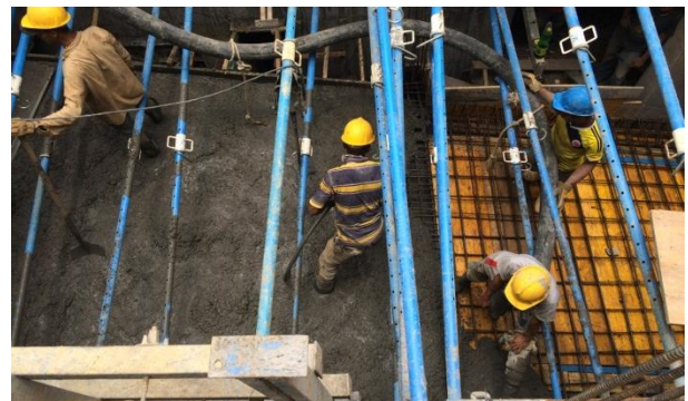
Ilustración 2: Vaciado de concreto de 3000 psi en rampa vehicular sótano 2.2 nivel N-4.05 m al sótano 2.1 N-2.62 m. Fuente: Peralta Ingeniería S.A.S.
