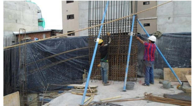
Ilustración 7: Pantalla P8 nivel N+3.48 m armada correctamente. Fuente: Peralta Ingeniería S.A.S.
