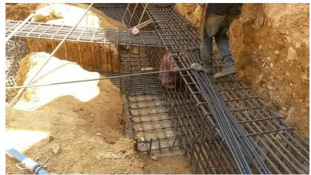
Ilustración 2: Armado de refuerzo de la viga V00-A. Fuente Peralta Ingeniería S.A.S.
