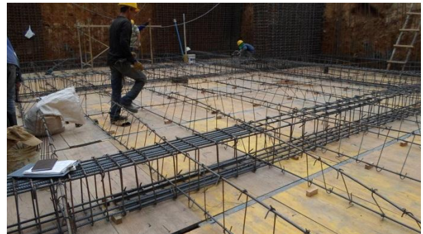
Ilustración 5: Armado de vigas sótano 1.1 nivel N-2.62 m. Fuente: Peralta Ingeniería S.A.S.
