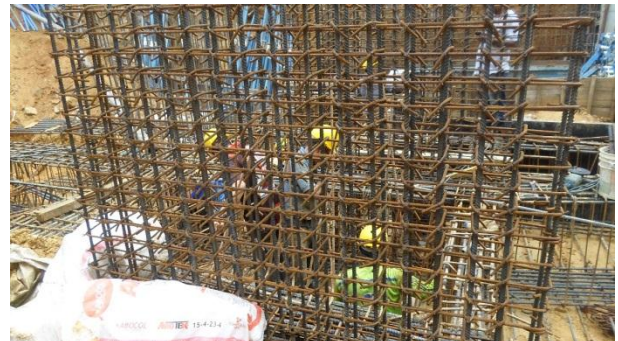
Ilustración 4: Armado de refuerzo de la pantalla P16. Fuente Peralta Ingeniería S.A.S.
