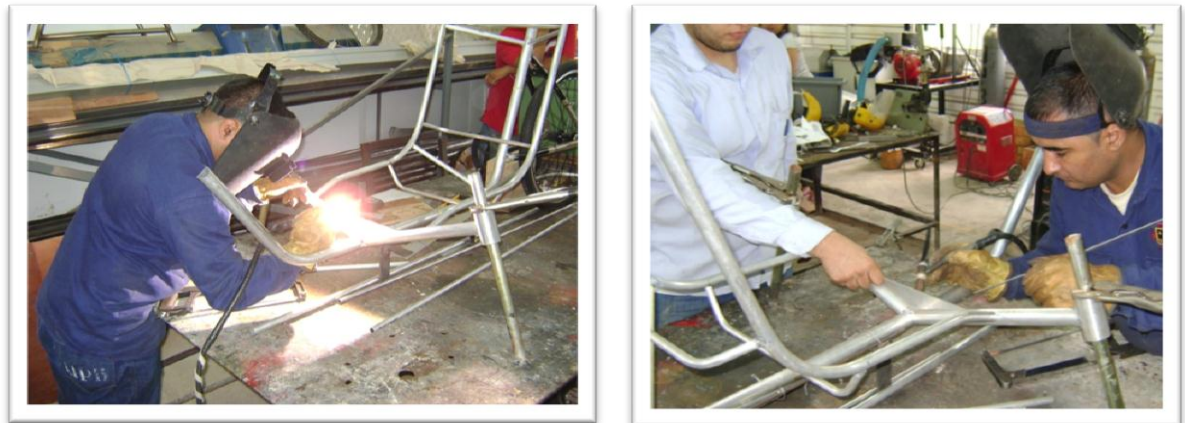
Figura 40. Proceso de soldadura del chasis. Se observa el uso de estructuras de soporte y de alicates de presión para inmovilizar las piezas, además de la posición de trabajo ergonómica lo cual ayudó en la excelente presentación de las soldaduras aplicadas.
