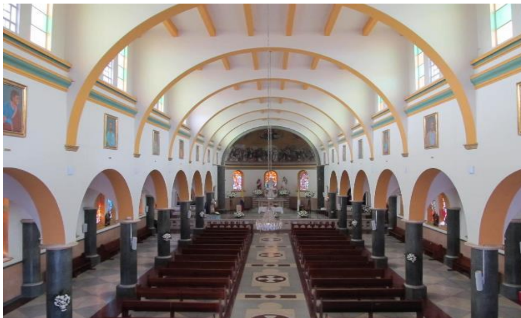
Fig 10: Vista interior de la iglesia.
