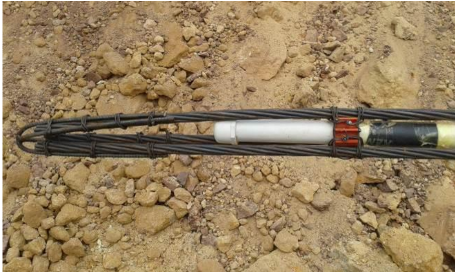
Figura 35. Gancho en acero de refuerzo
