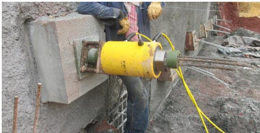
Figura 69. Tensionamiento de anclajes con gato hidráulico
