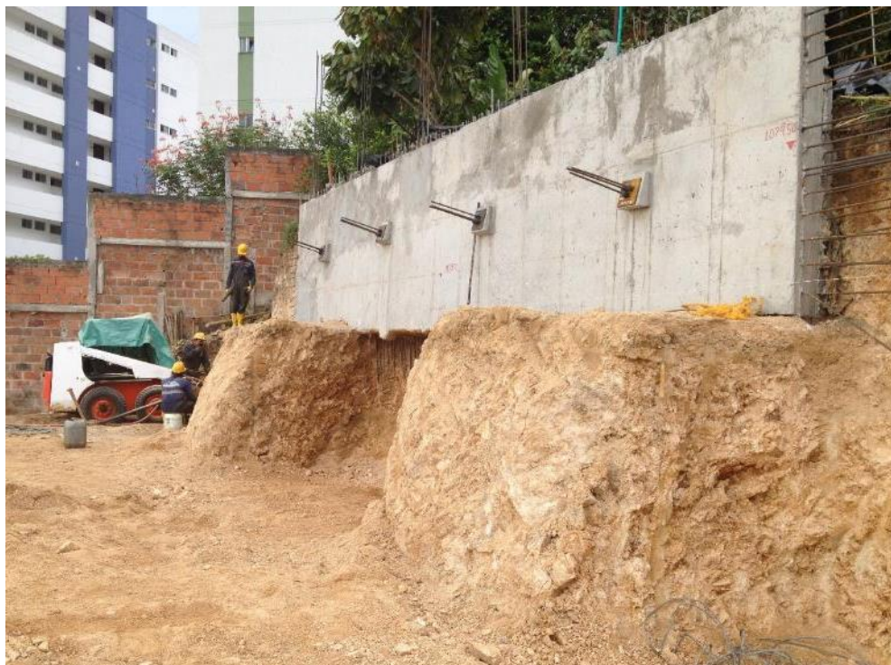
Figura 50. Modulación de trincheras en campo
