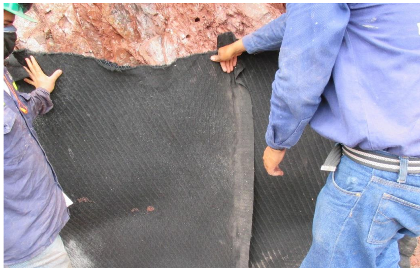
Figura 73. Instalación de geodren planar
