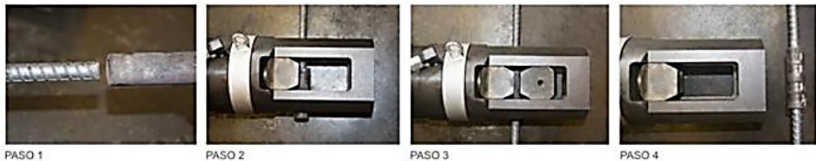
Figura 40. Proceso de instalación conector extruido
