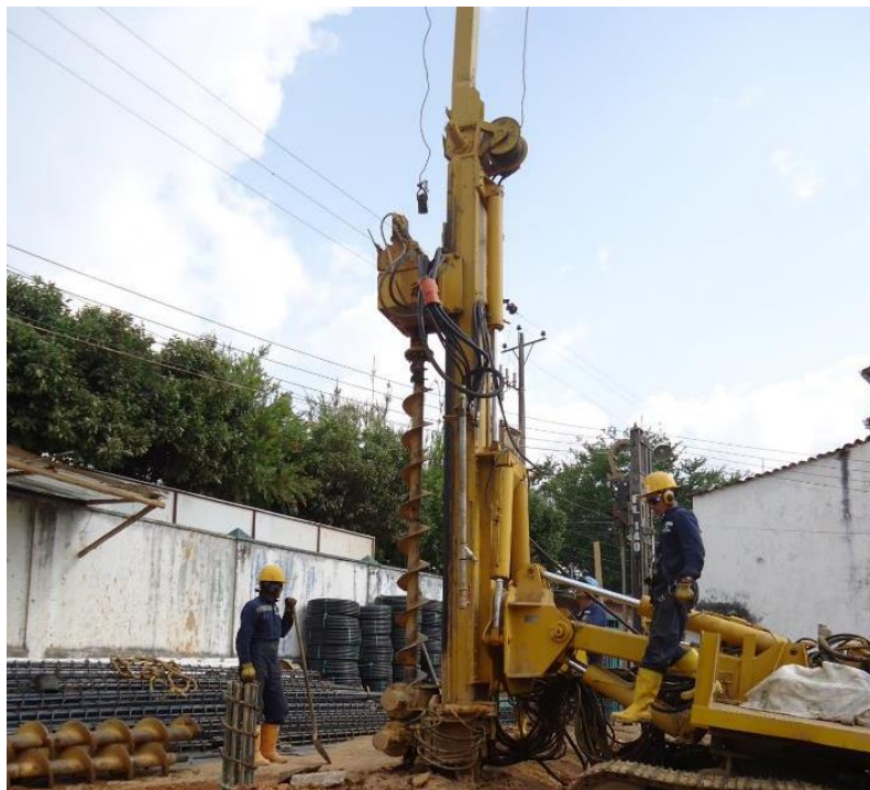
Figura 75. Maquinaria utilizada para la perforación de micropilotes
