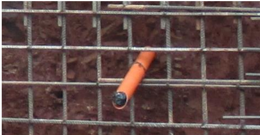
Figura 61. Instalación de lloraderos
