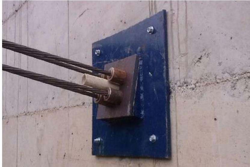
Figura 33. Cabeza de anclaje apoyada en base metálica
