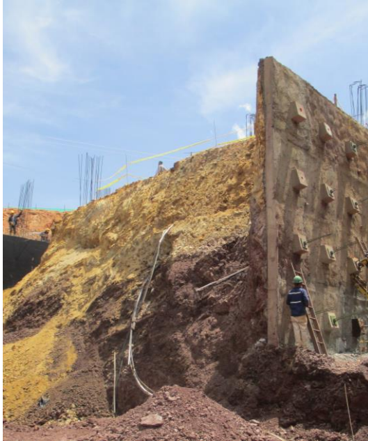
Figura 25. Construcción de anclajes en taludes de relleno
