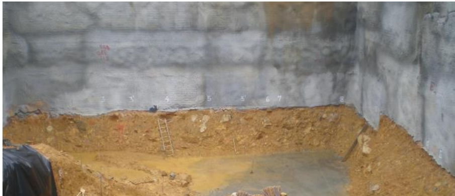
Figura 65. Pantalla anclada con pernos tipo gancho
