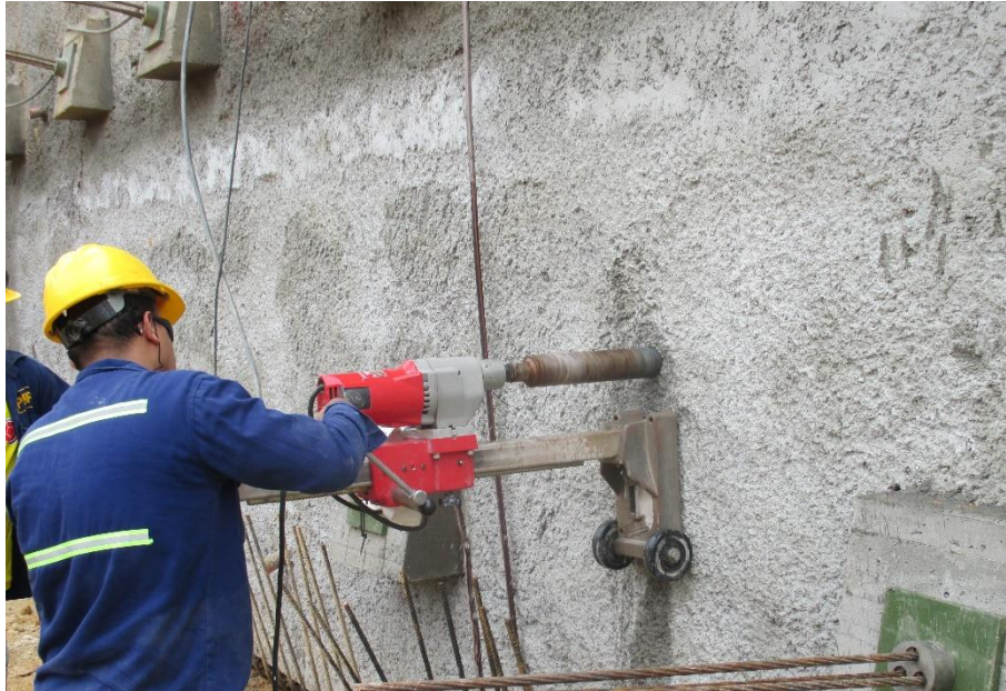
Figura 67. Extracción de núcleos en las pantallas
