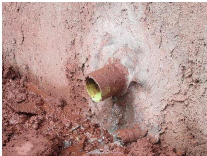
Figura 72. Subdren de penetración en funcionamiento
