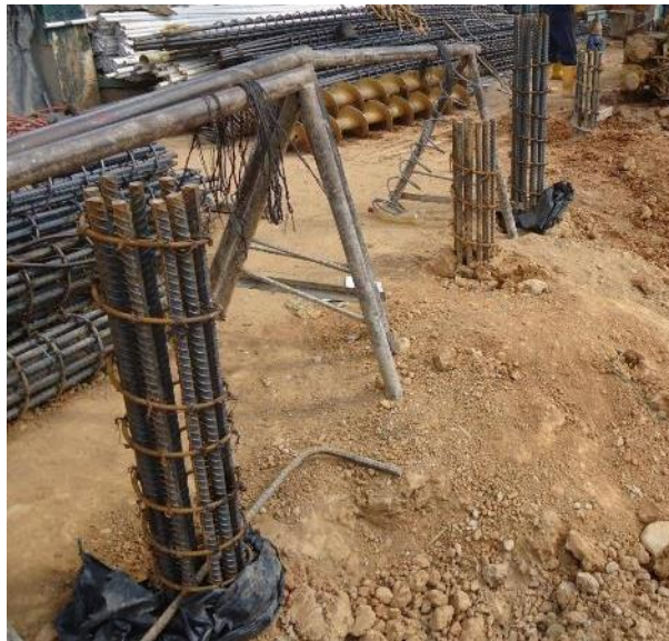
Figura 76. Armadura del micropilote instalada
