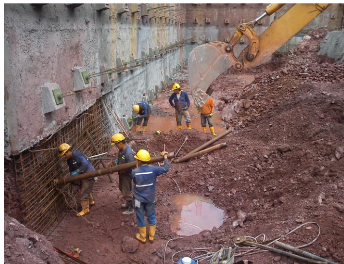
Figura 17. Perforación con tubería de revestimiento para controlar el agua
