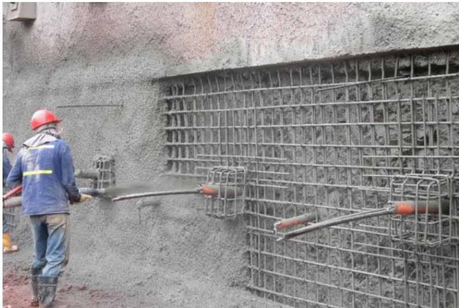
Figura 62. Concreto lanzado para pantallas ancladas
