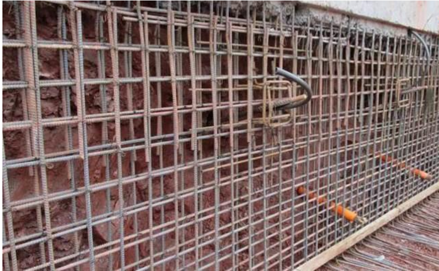
Figura 38. Armado de acero de refuerzo para las pantallas
