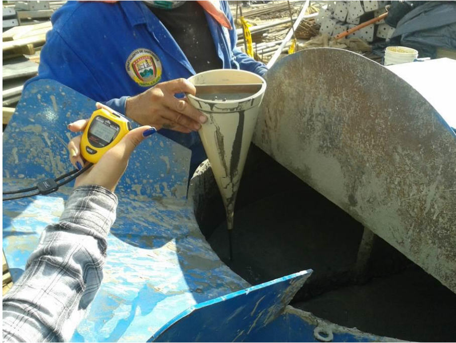
Figura 37. Lechada de cemento usada para la inyección de anclajes
