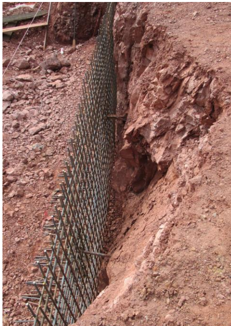
Figura 21. Sobre-espesores por eliminación de bloques de gran tamaño
