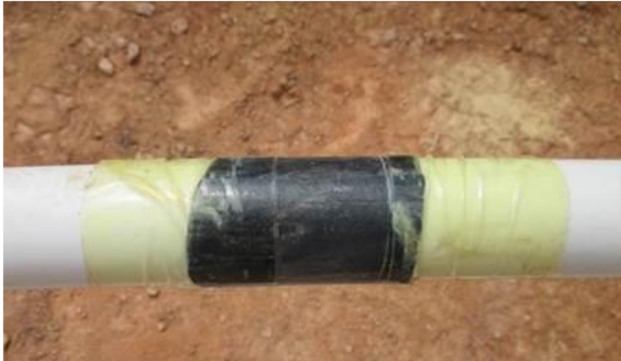
Figura 36. Neumático instalado en la zona del bulbo
