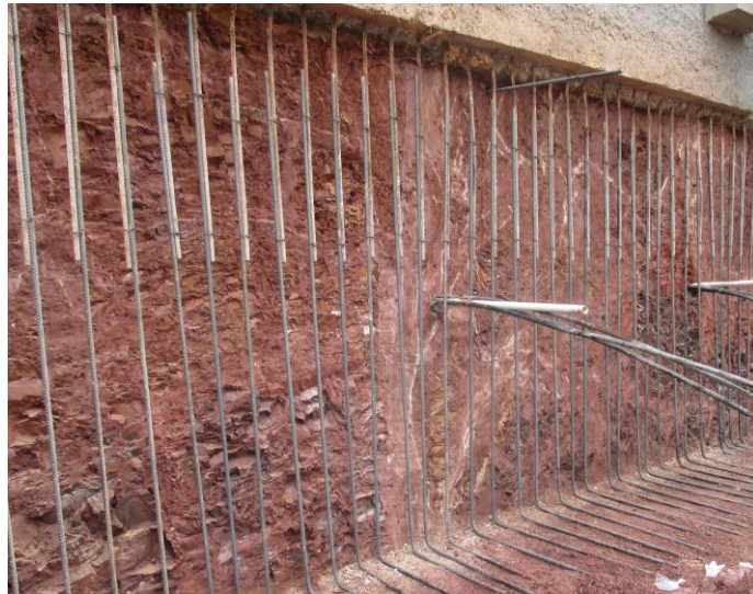
Figura 18. Refuerzo doblado para realizar el traslajo del siguiente módulo
