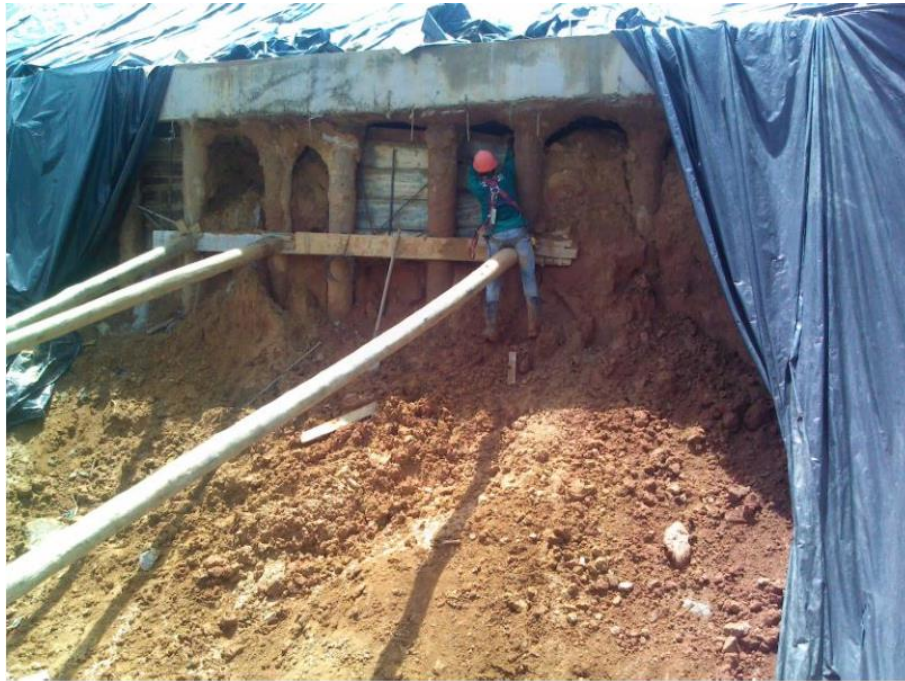
Figura 79. Conexión de micropilotes mediante una viga
