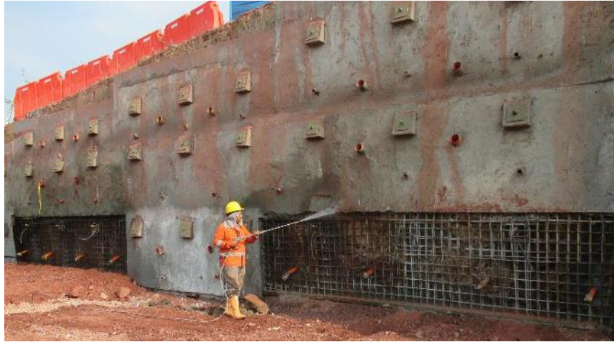
Figura 60. Limpieza de concreto
