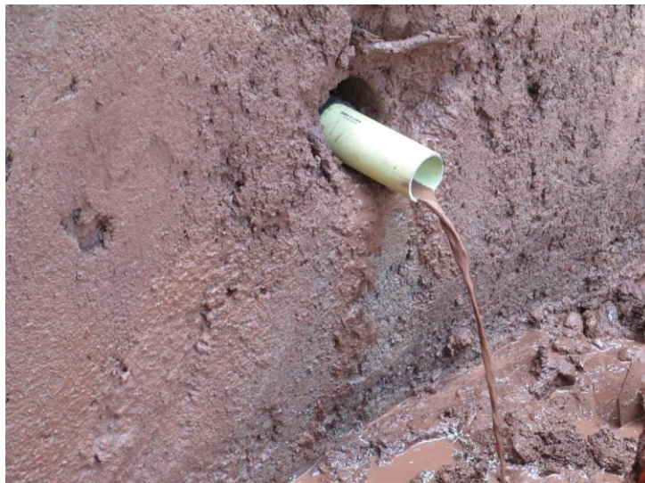
Figura 23. Subdren de penetración
